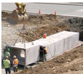
Fig. 3.4 Sistema de alcantarillas de cuadro
