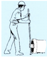
Fig. 3.33 Instalación manual de tuberías de diámetros menores
