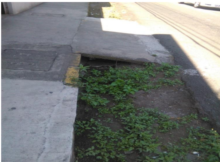
Figura 10. Canal con vegetación, evidencia el poco mantenimiento.
