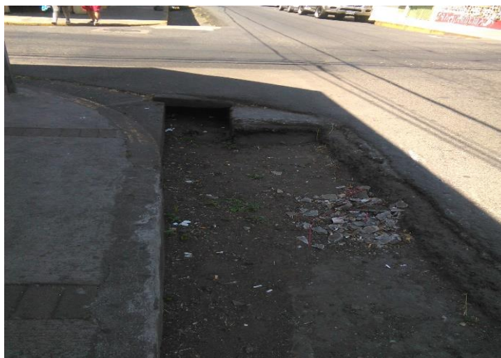
Figura 13. Reducción de área transversal del canal.
