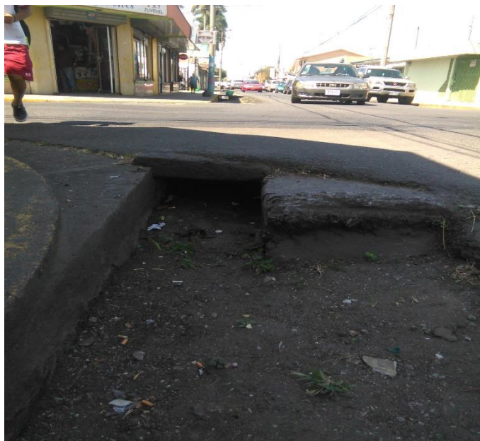
Figura 12. Reducción de área transversal del canal.
