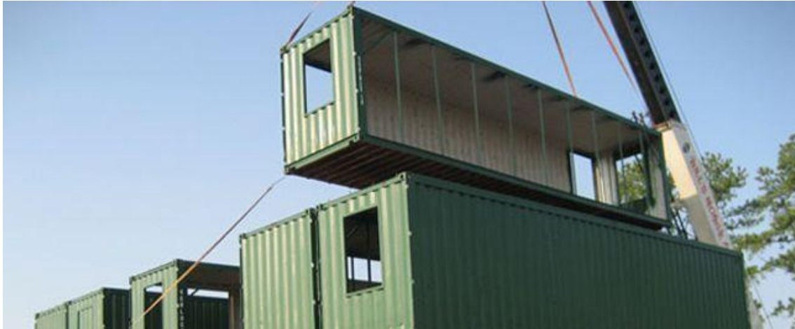
Ilustración 2. Construcción modular con contenedores
