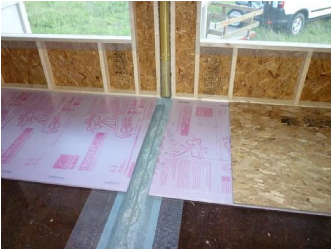
Ilustración 20: Ejemplo de junta entre contenedores
