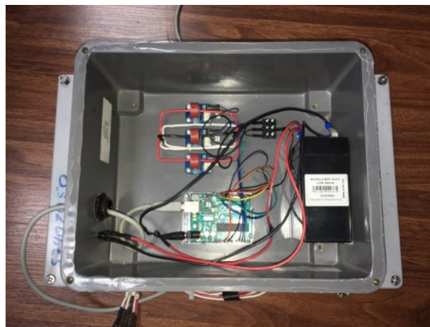
Figura 3.6. Montaje del sistema de monitoreo Fuente propia.
