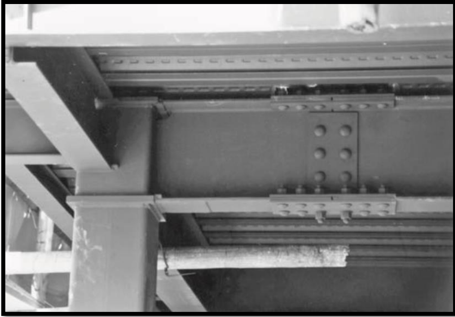
Figura 1. . Marco de momento bajo el sistema Column-Tree con columna HSS con placa diafragma. (Chia-Ming, Michel, & Rafael, 1998)
