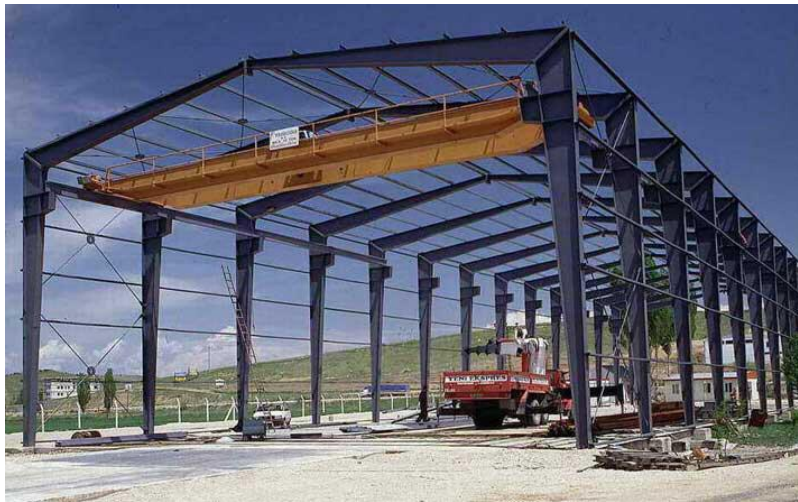
FIGURA1. NAVE INDUSTRIAL. FUENTE: HTTP://WWW.FDEDIEGOINGENIEROS.COM/NAVES-INDUSTRIALES/ VISITADO EL DÍA 22 DE SETIEMBRE DE 2017.
