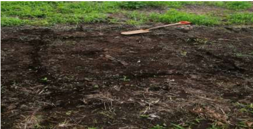
Figura 13. Trazo preliminar rectangular para zanja de calicata
