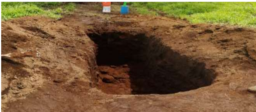
Figura 14 . Calicata completa, Brava de Heredia
