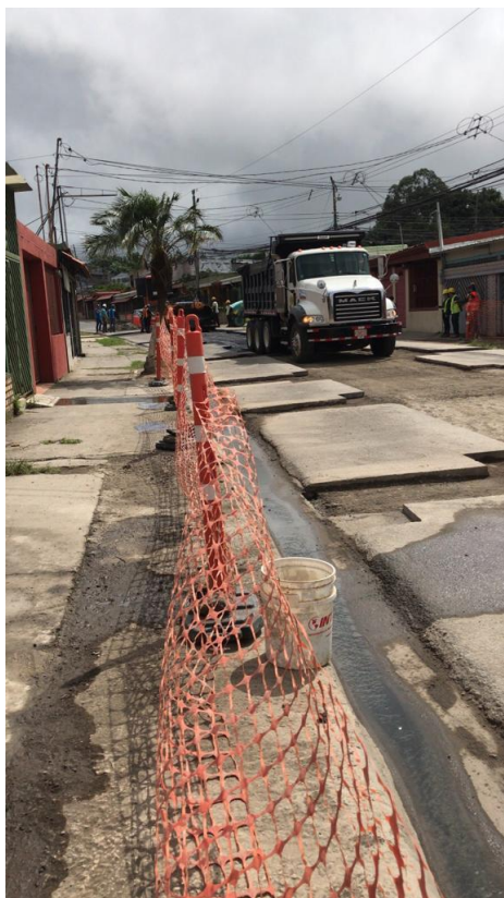
Ilustración 5. Colocación de mezcla asfáltica.
