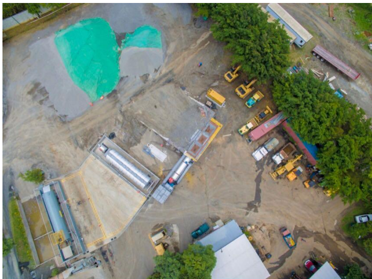
Ilustración 7. Planta de mezcla asfáltica PAVICEN.
