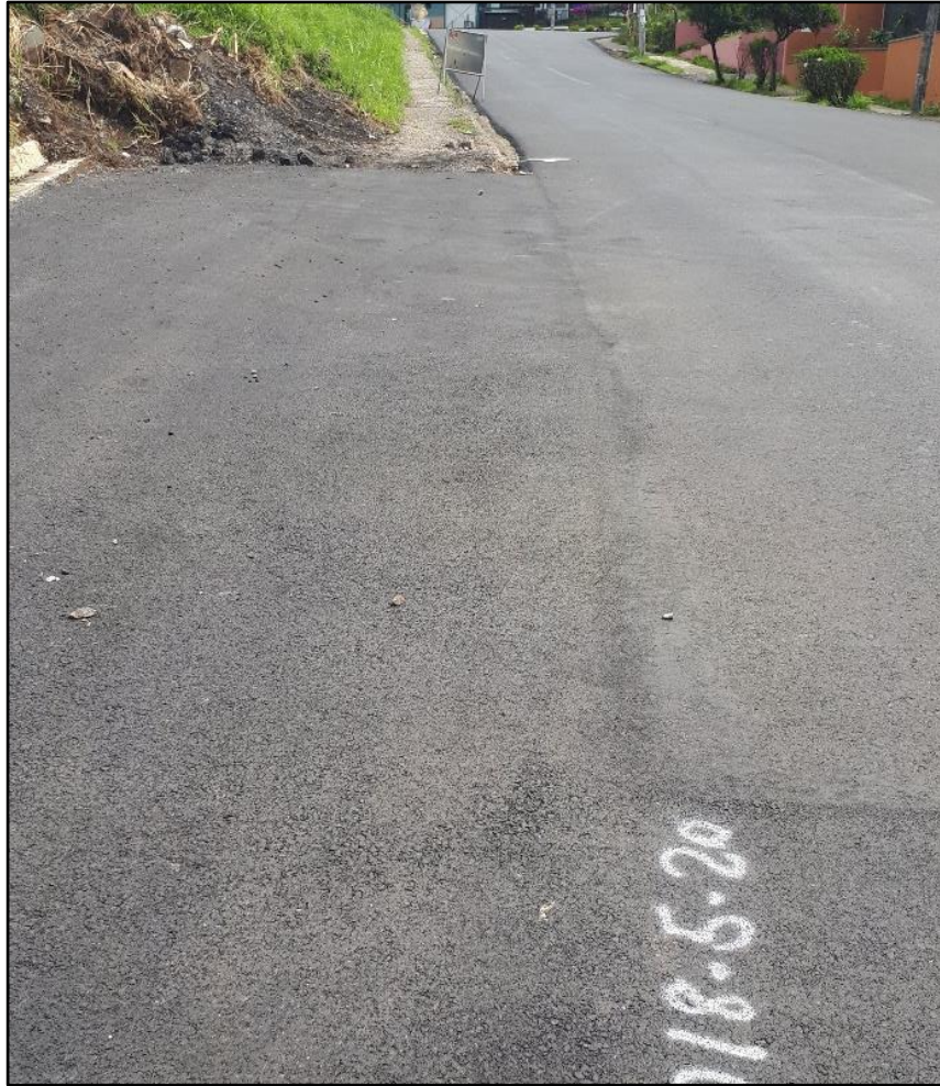
Figura I - 3 Juntas Transversales y longitudinales
