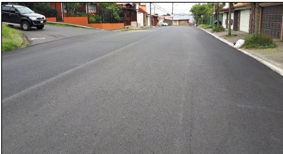
Figura K - 4 Sobrecapa asfáltica colocada
