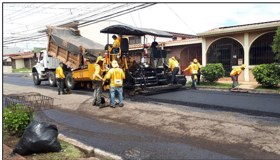
Figura I - 4 Colocación de Sobrecapa asfáltica
