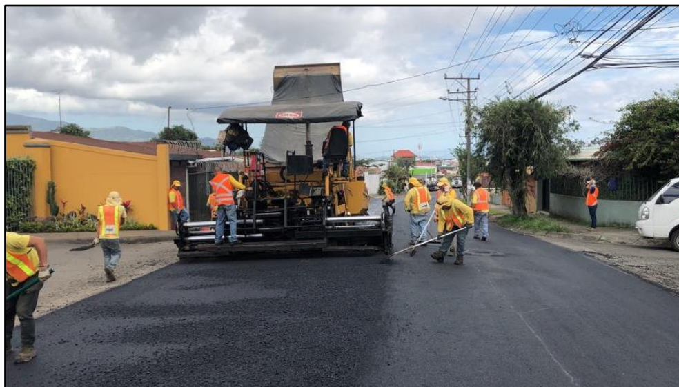
Figura K - 2 Colocación de Sobrecapa asfáltica
