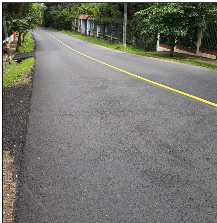
Figura J - 6 Sobrecapa asfáltica colocada
