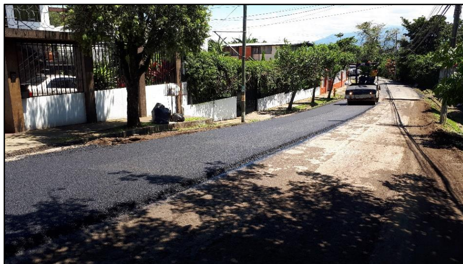
Figura J - 4 Colocación de Sobrecapa asfáltica
