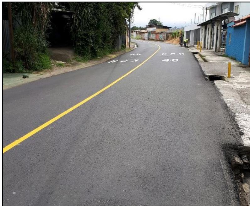
Figura I - 5 Sobrecapa asfáltica colocada
