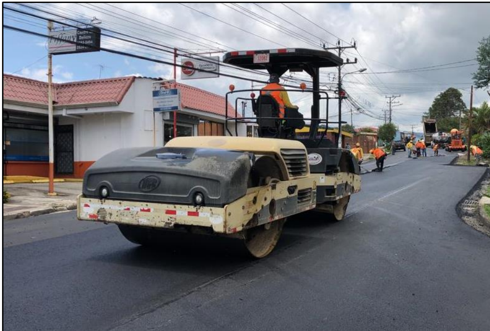
Figura K - 3 Colocación de Sobrecapa asfáltica
