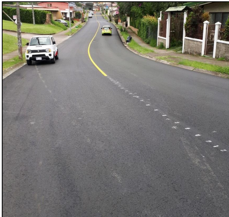
Figura J - 5 Sobrecapa asfáltica colocada
