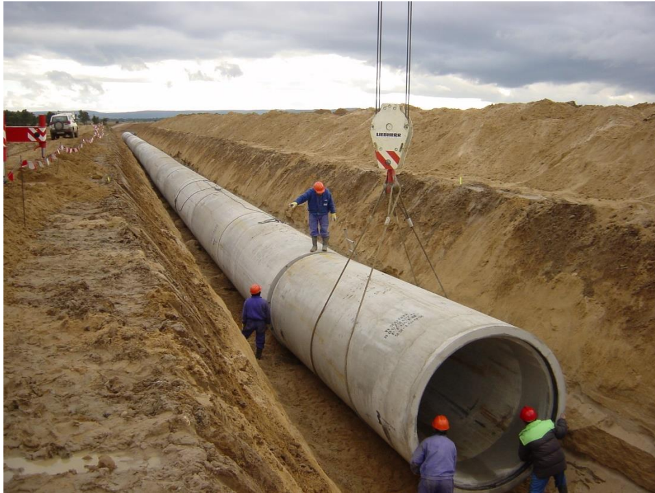
Ilustración 6. Instalación de tubería de concreto (Prefabricados Delta,2014)
