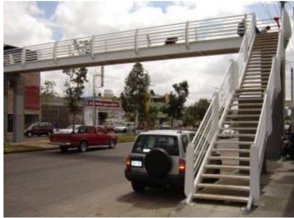
Figura 18. Escalones de polyconcreto para puente
