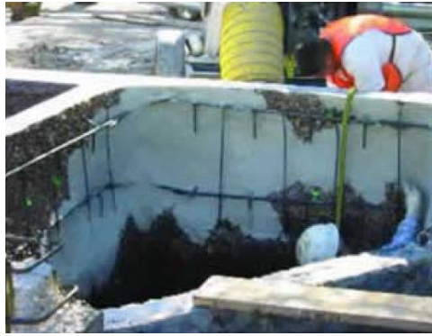
Figura 43. Aplicación de concreto polimérico y reparación de estructura Fuente: 2do congreso internacional de poliformas plásticas, Acapulco (2010)
