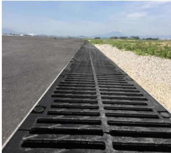
Figura 36. Canales de drenaje de concreto polimérico utilizados en proyecto
