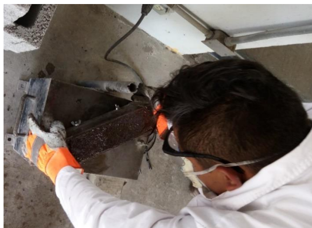
Figura 119. Proceso de vibrado de vigas de concreto polimérico
