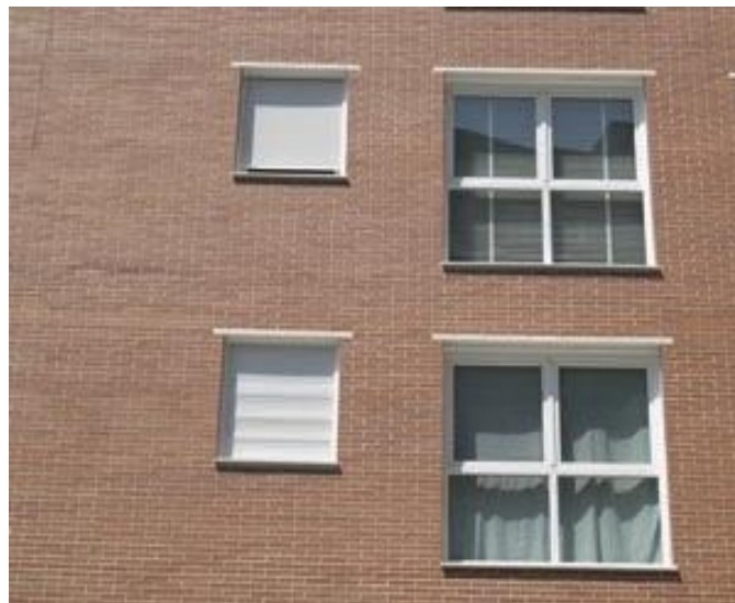
Figura 33. Aplicación de dinteles prefabricados de concreto polimérico
