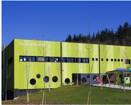
Figura 38. Facha de Ceip Zelaieta de concreto polimérico
