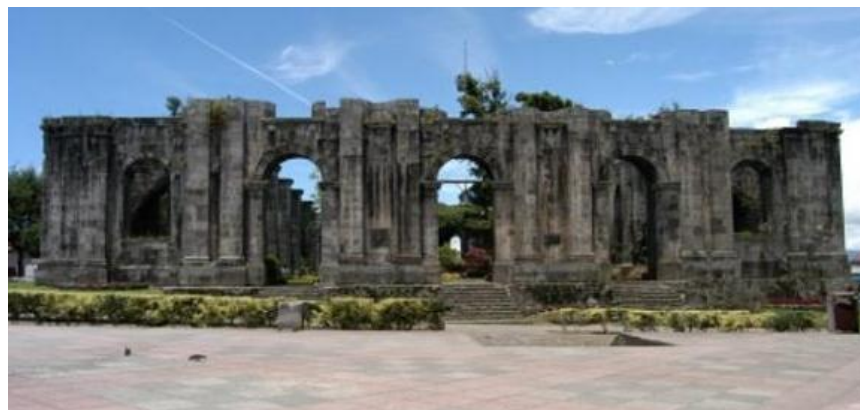
Figura 4.2. Fachada frontal del templo Santiago Apóstol en Cartago
