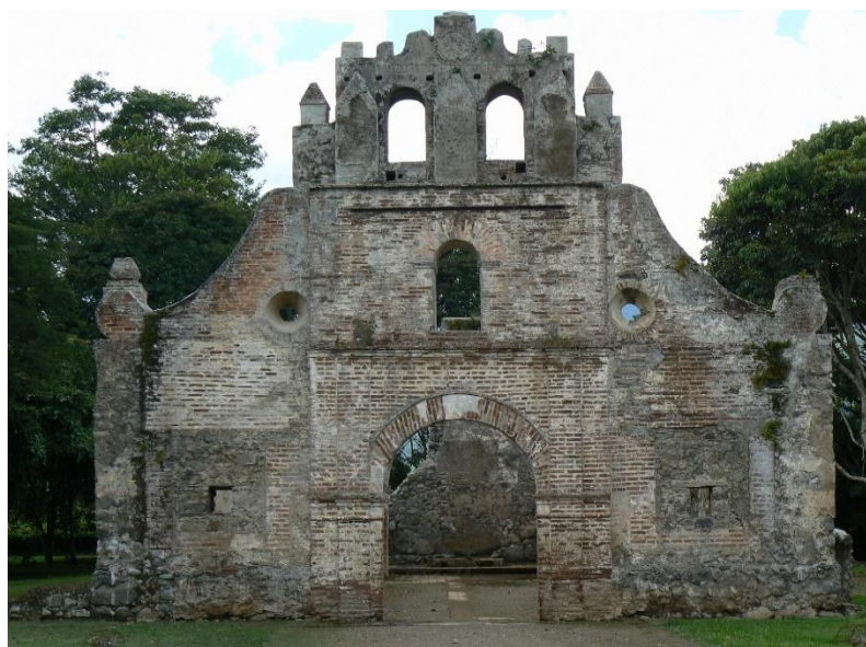
Figura 5.2. Fotografía de la fachada este o frontal
