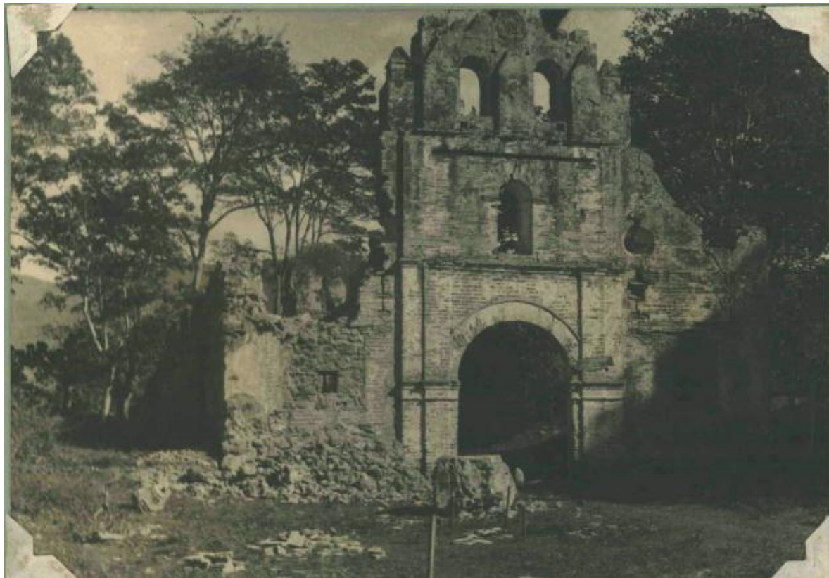
Figura 5.22. Fotografía de desplome de la fachada
