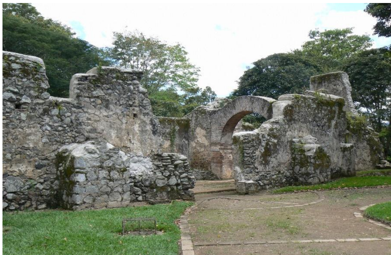
Figura 5.3. Fotografía de la fachada sur o lateral derecha
