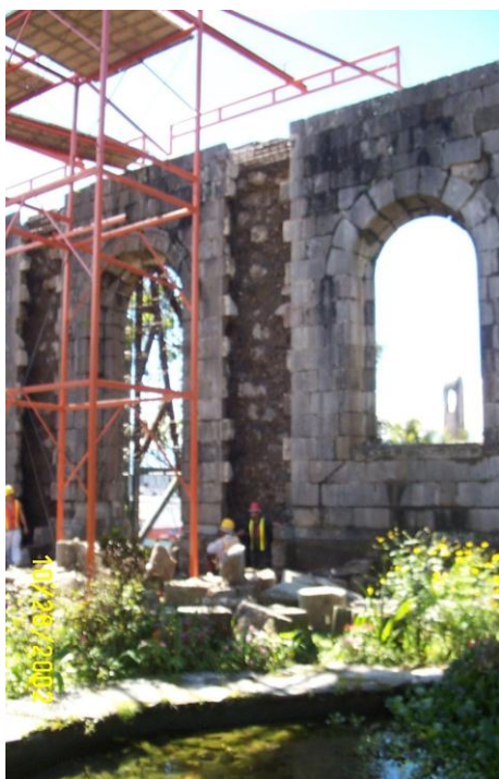
a) Fotografía interna del contrafuerte del templo Santiago Apóstol
