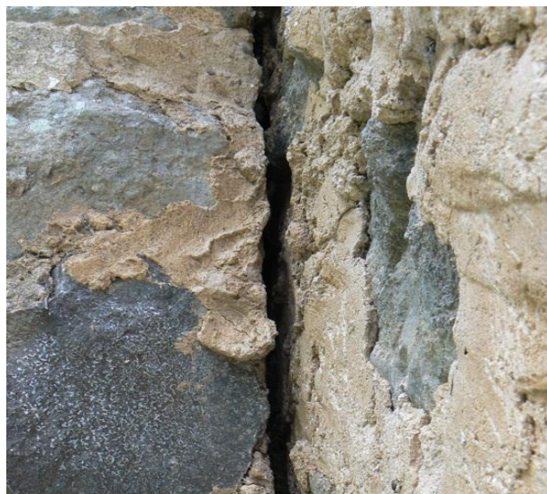
Figura 5.5. Fotografía de elementos usados en la pared
