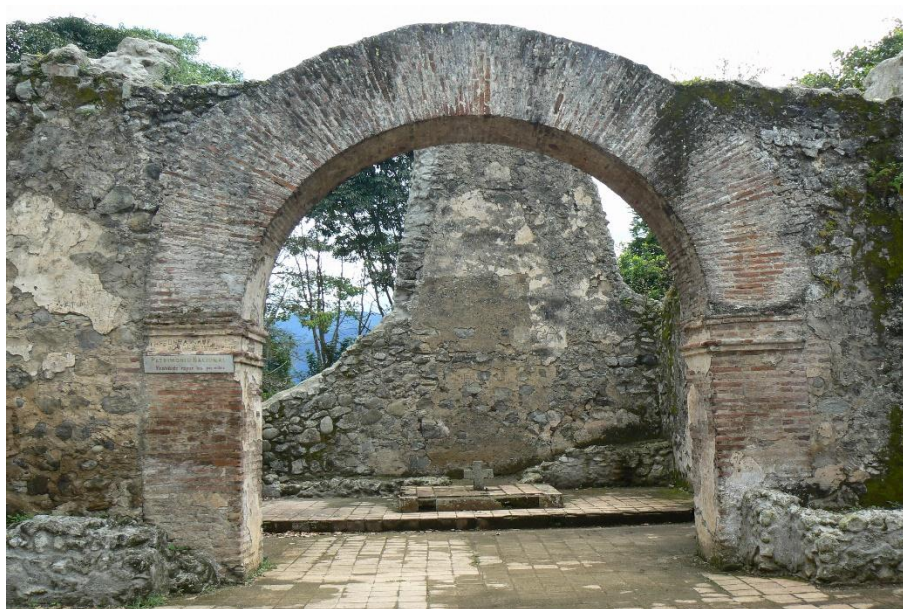
Figura 5.9. Fotografía de arco interno que separa la nave principal de la sacristía
