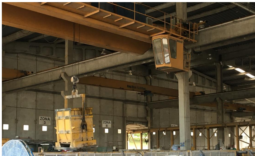
Ilustración 8 Tolva de concreto
