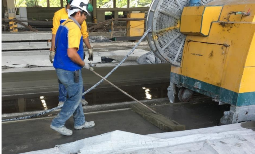
Ilustración 5 Limpieza y colocación de desmoldante
