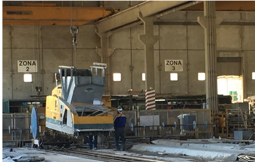
Ilustración 7 Movilización de máquina extrusora
