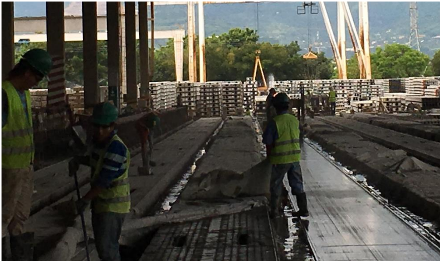
Ilustración 12 Colocación de plástico y lona para curado
