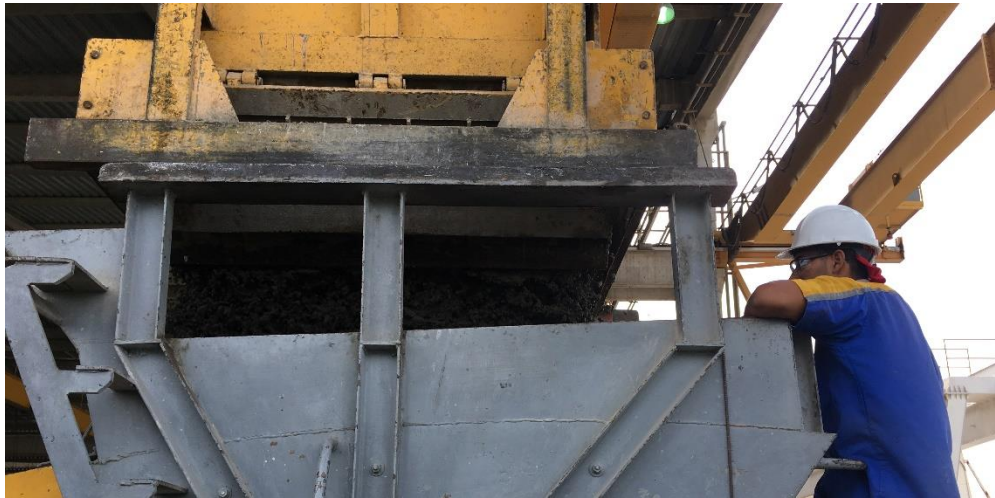
Ilustración 9 Verificación de calidad visual del concreto
