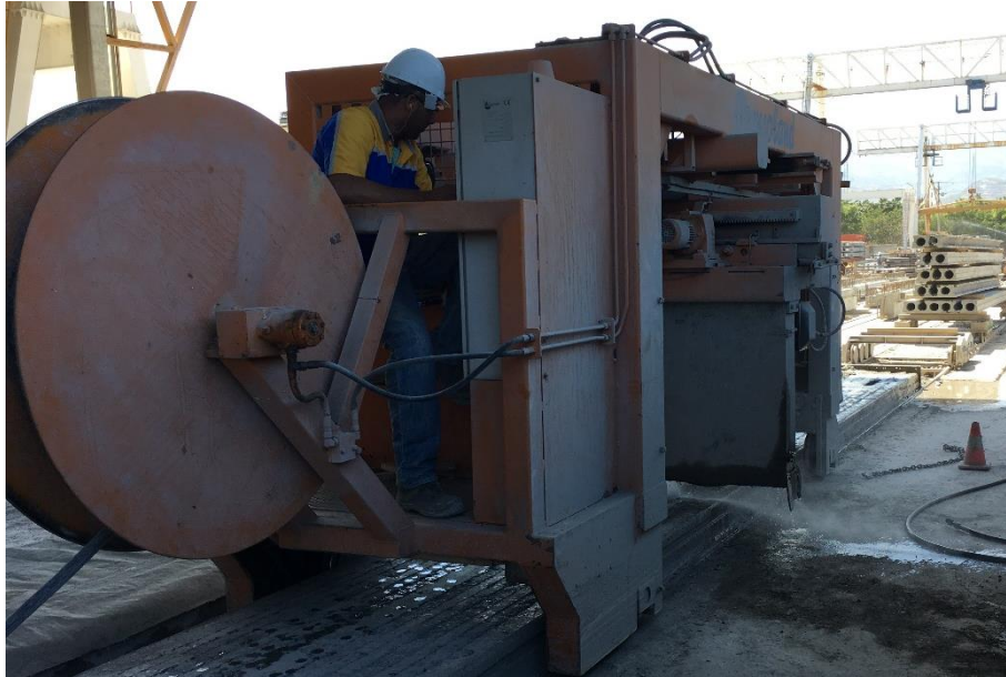
Ilustración 13 Proceso de corte de losa
