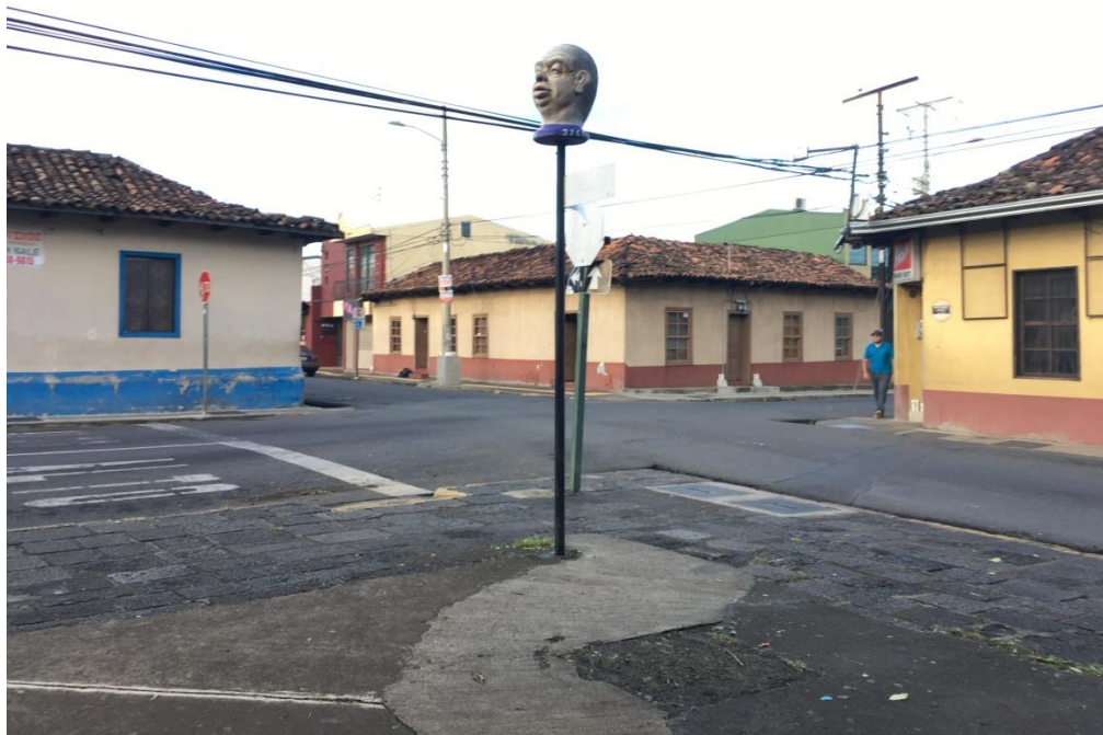
Figura 28. Deficiencias de intersección Fuente: Propiedad del autor (2017)
