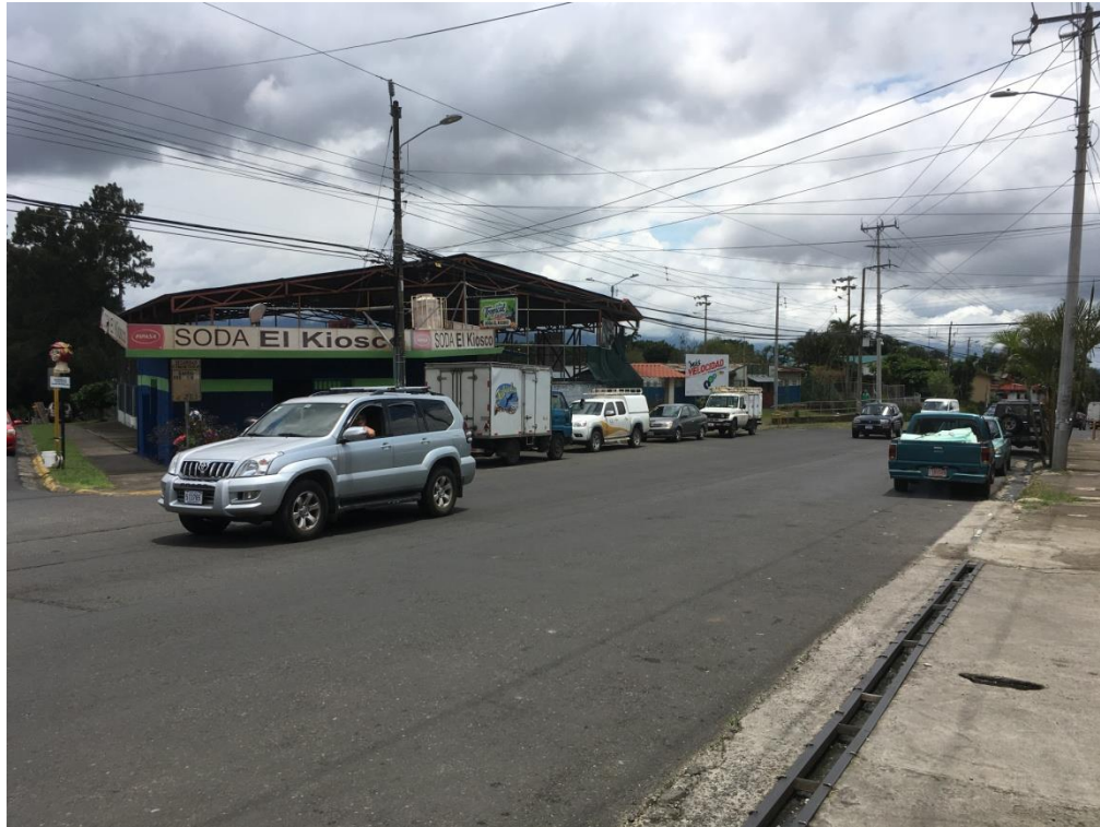
Figura 36. Deficiencias Intersección Fuente: Propiedad del autor (2017)
