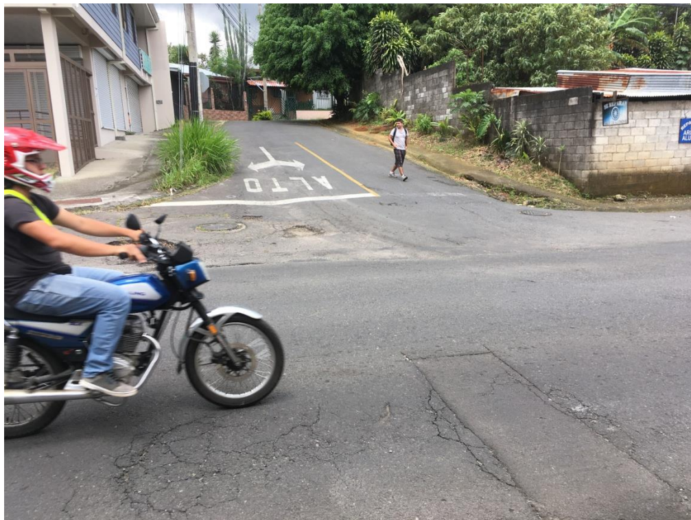
Figura 47. Deficiencias de intersección Fuente: Propiedad del autor (2017)
