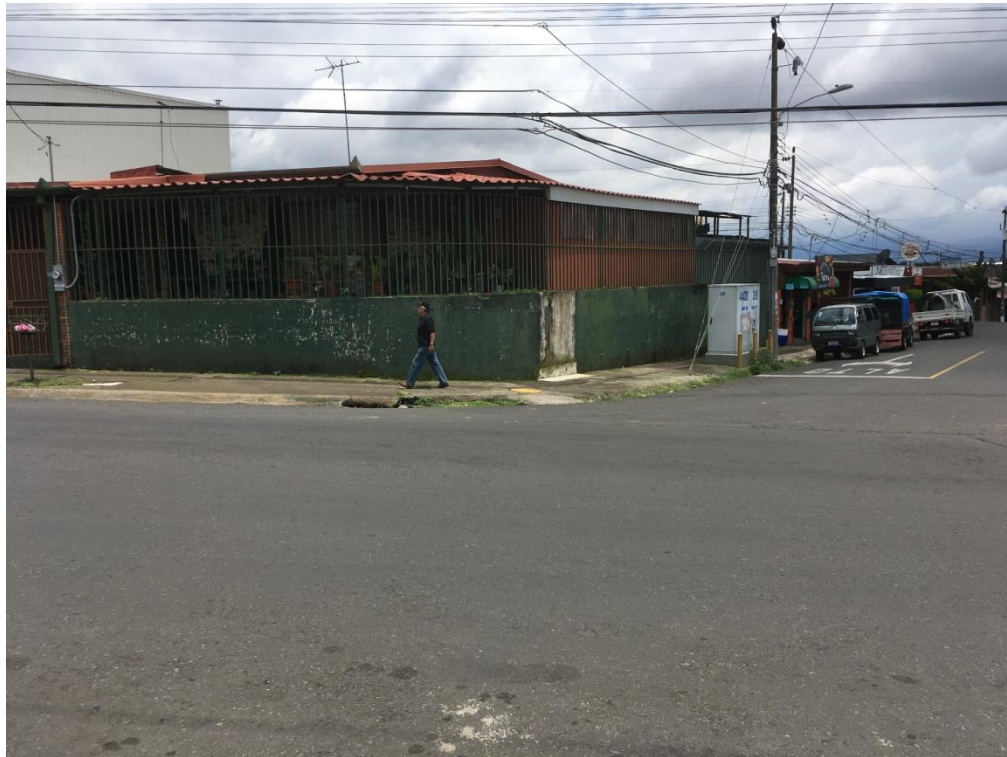
Figura 35. Deficiencias de intersección Fuente: Propiedad del autor (2017)
