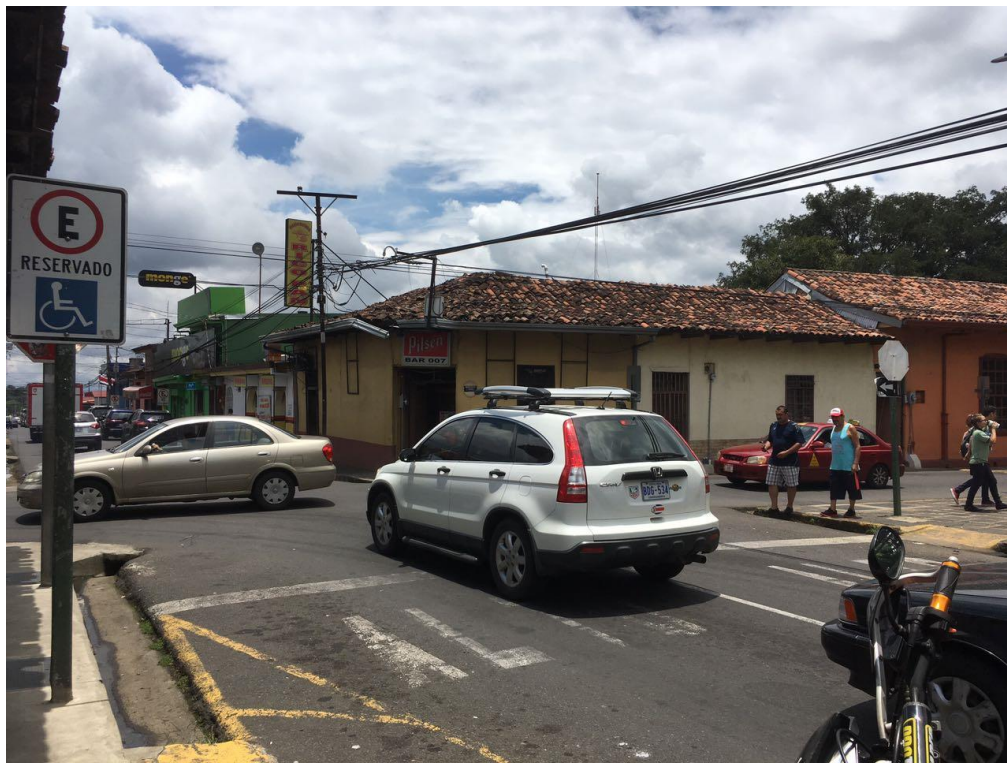
Figura 28. Deficiencias de intersección Fuente: Propiedad del autor (2017)
