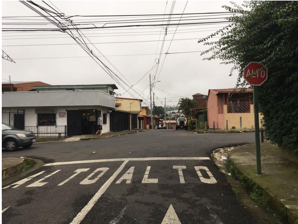
Figura 38. Deficiencias de intersección Fuente: Propiedad del autor (2017)
