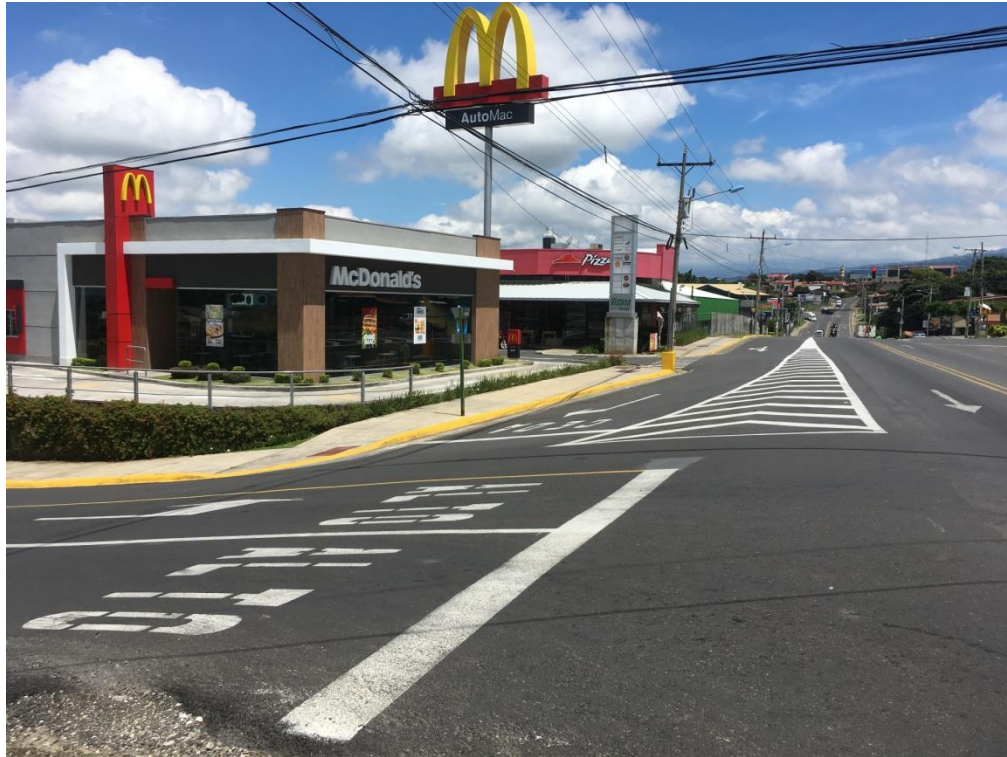
Figura 41. Deficiencias Intersección Fuente: Propiedad del autor (2017)
