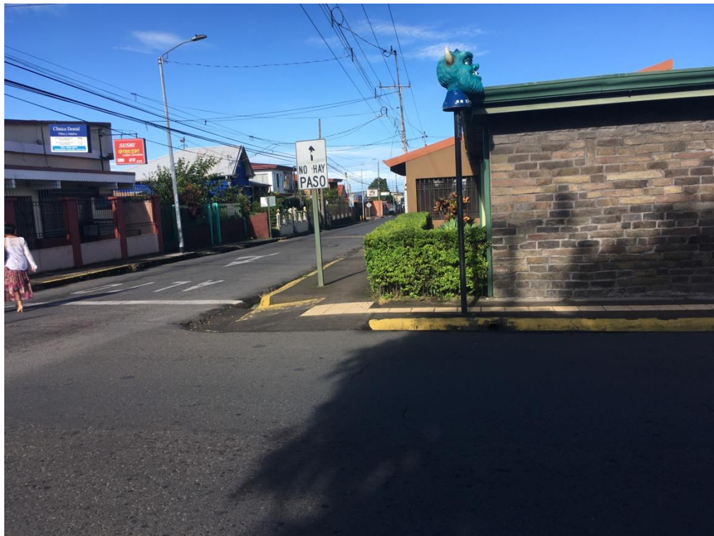
Figura 32. Deficiencias Intersección Fuente: Propiedad del autor (2017)
