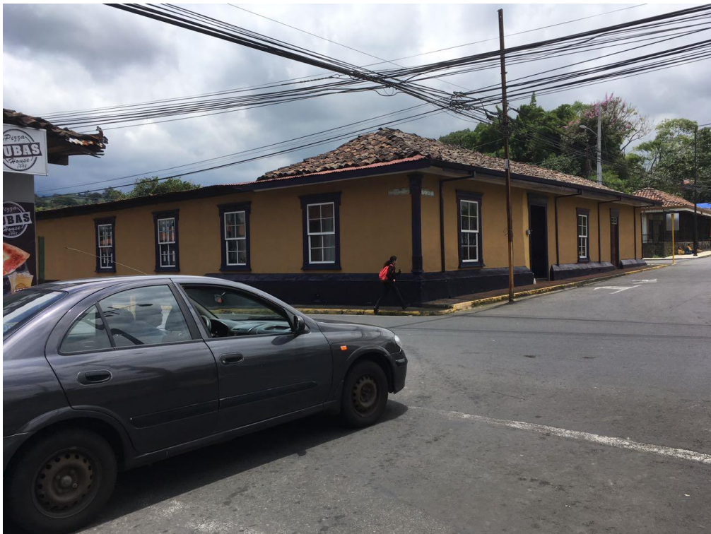
Figura 23. Deficiencias de intersección Fuente: Propiedad del autor (2017)
