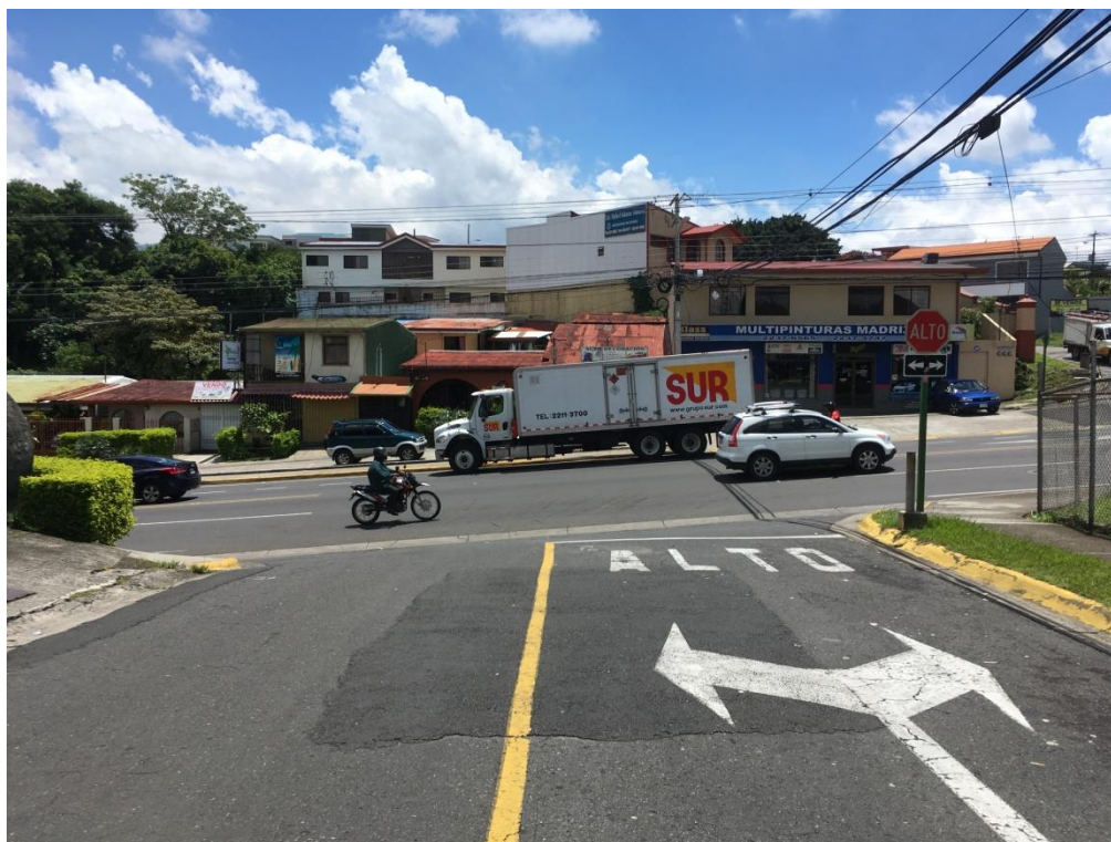
Figura 20. Deficiencias en intersección
