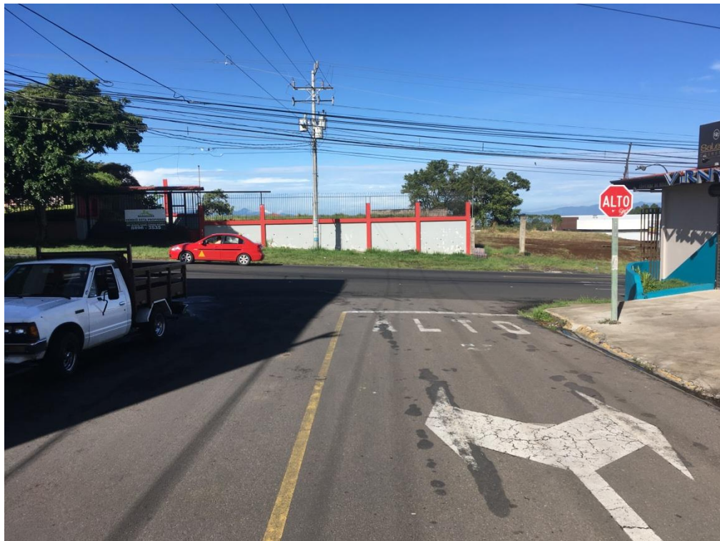
Figura 17. Deficiencias de intersección Fuente: Propiedad del autor (2017)
