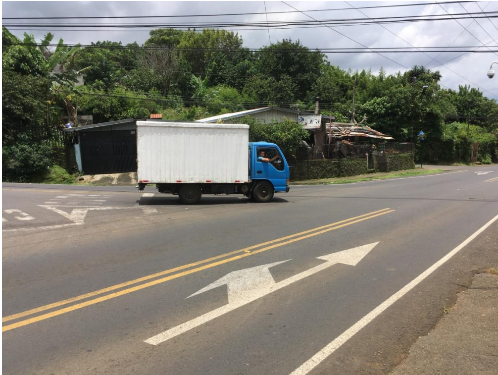
Figura 26. Deficiencias de intersección Fuente: Propiedad del autor (2017)
