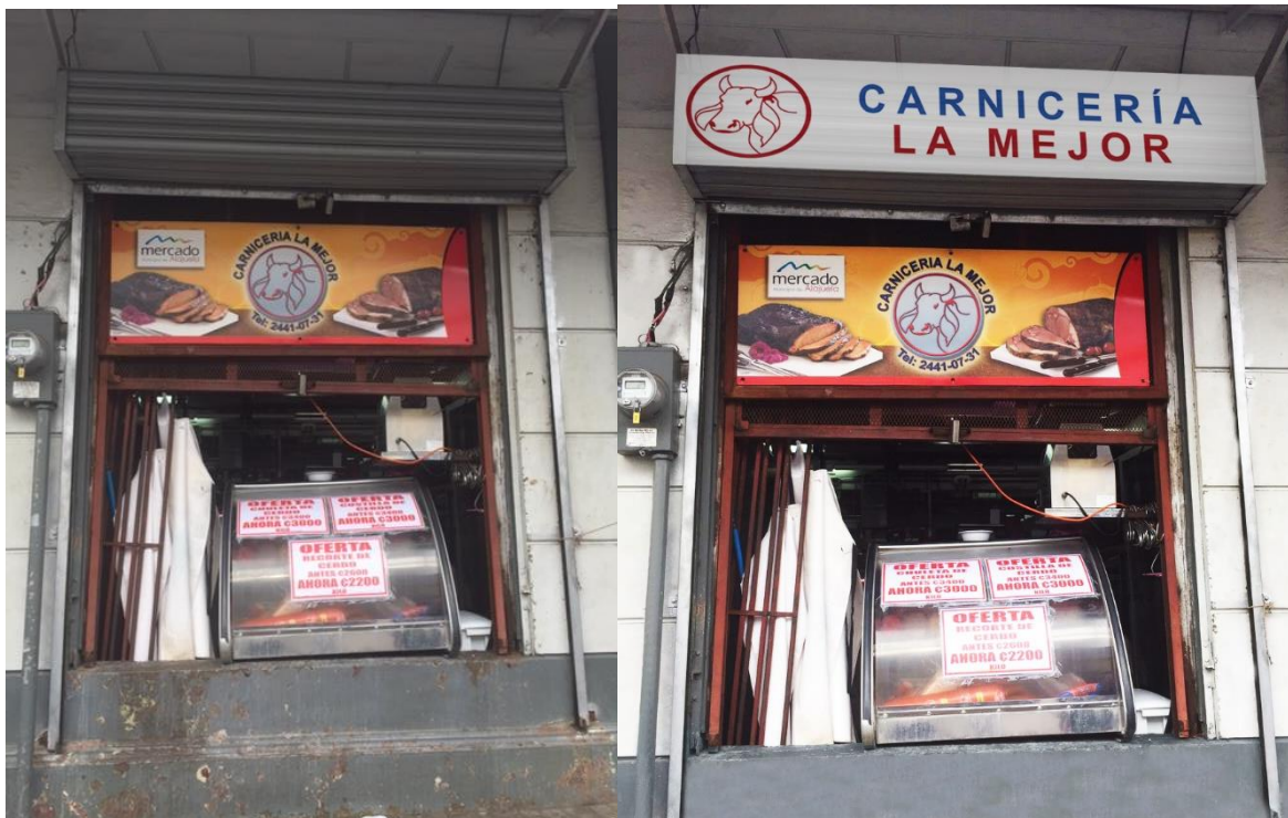
Figura 32: Cortinas metálicas #1. Estado actual y proyección
