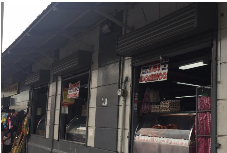
Figura 33: Cortinas metálicas #2. Estado actual
