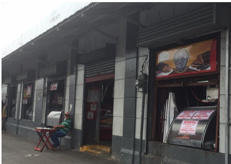
Figura 35: Cortinas metálicas #3. Estado actual
