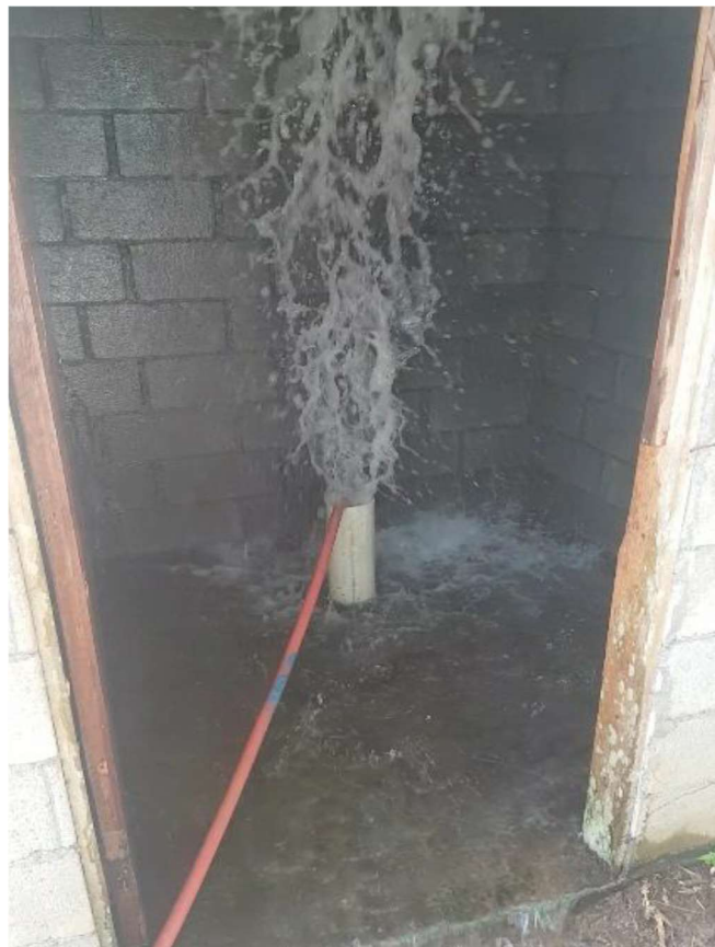
Ilustración 4: Fotografía de pozo publicada en Ojo de Agua durante la limpieza. Fuente: Castro y De la Torre, ingenieros consultores.
