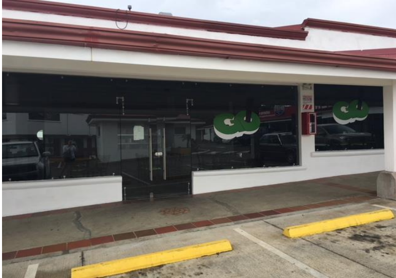
Imagen # 38: Fachada principal del Restaurante Go San José, Costa Rica Periodo: III Cuatrimestre, 2017
