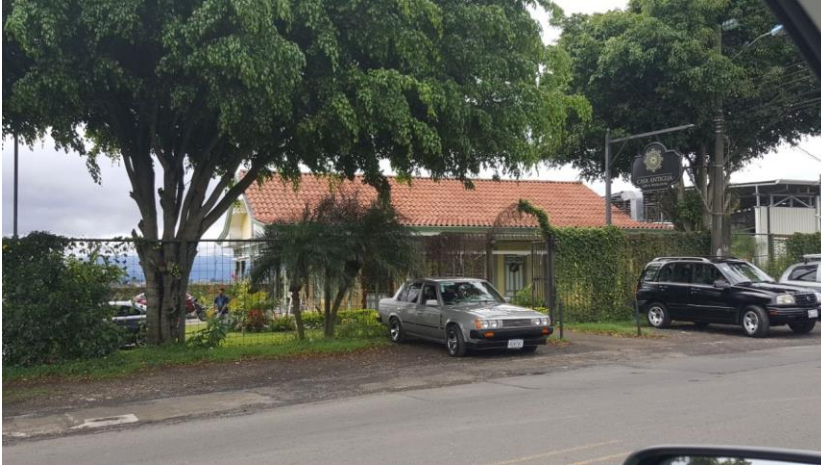
Imagen # 36: Fachada principal del Restaurante Casa Antigua San José, Costa Rica Periodo: III Cuatrimestre, 2017
