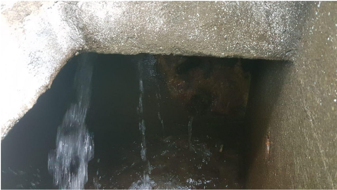
Anexo 5. Revisión de captaciones
