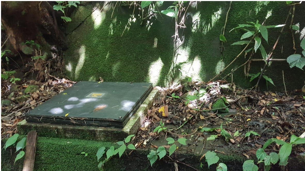
Anexo 6. Revisión de captaciones
