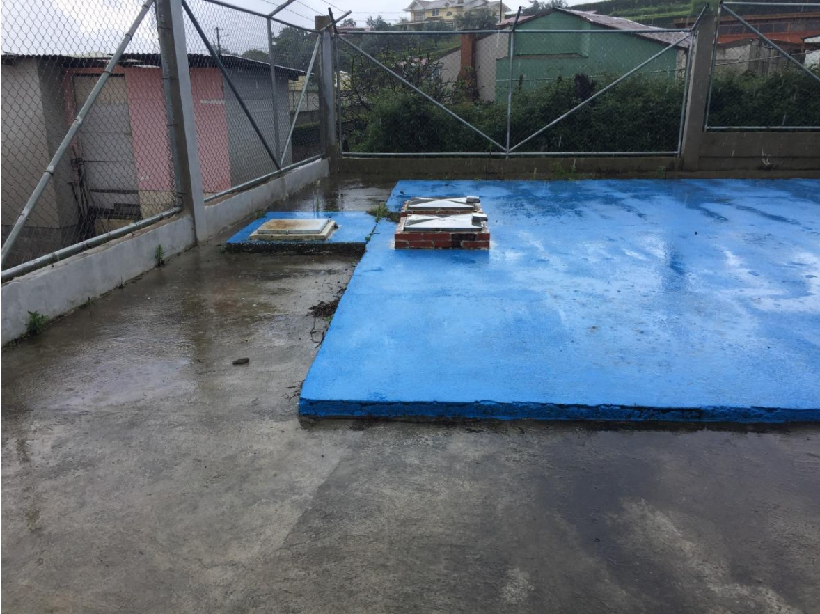
Anexo 12. Tanque Los Gemelos.
