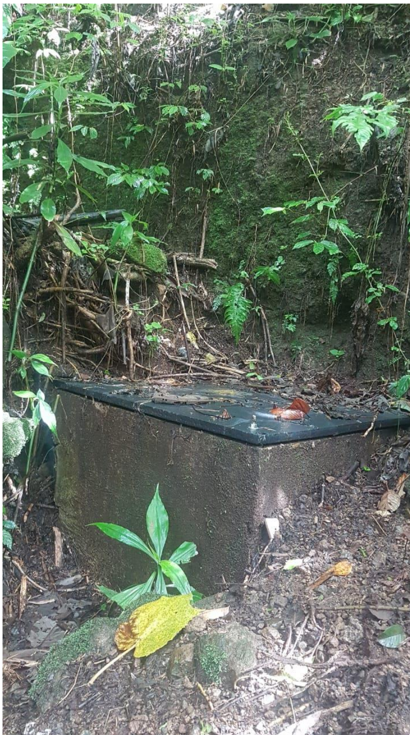
Anexo 7. Revisión de captaciones
