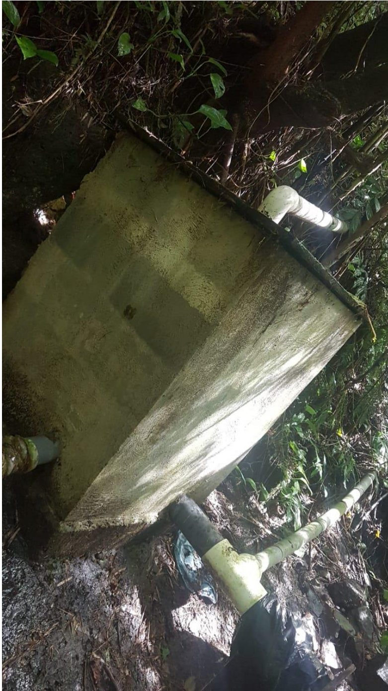
Anexo 8. Revisión de captaciones
