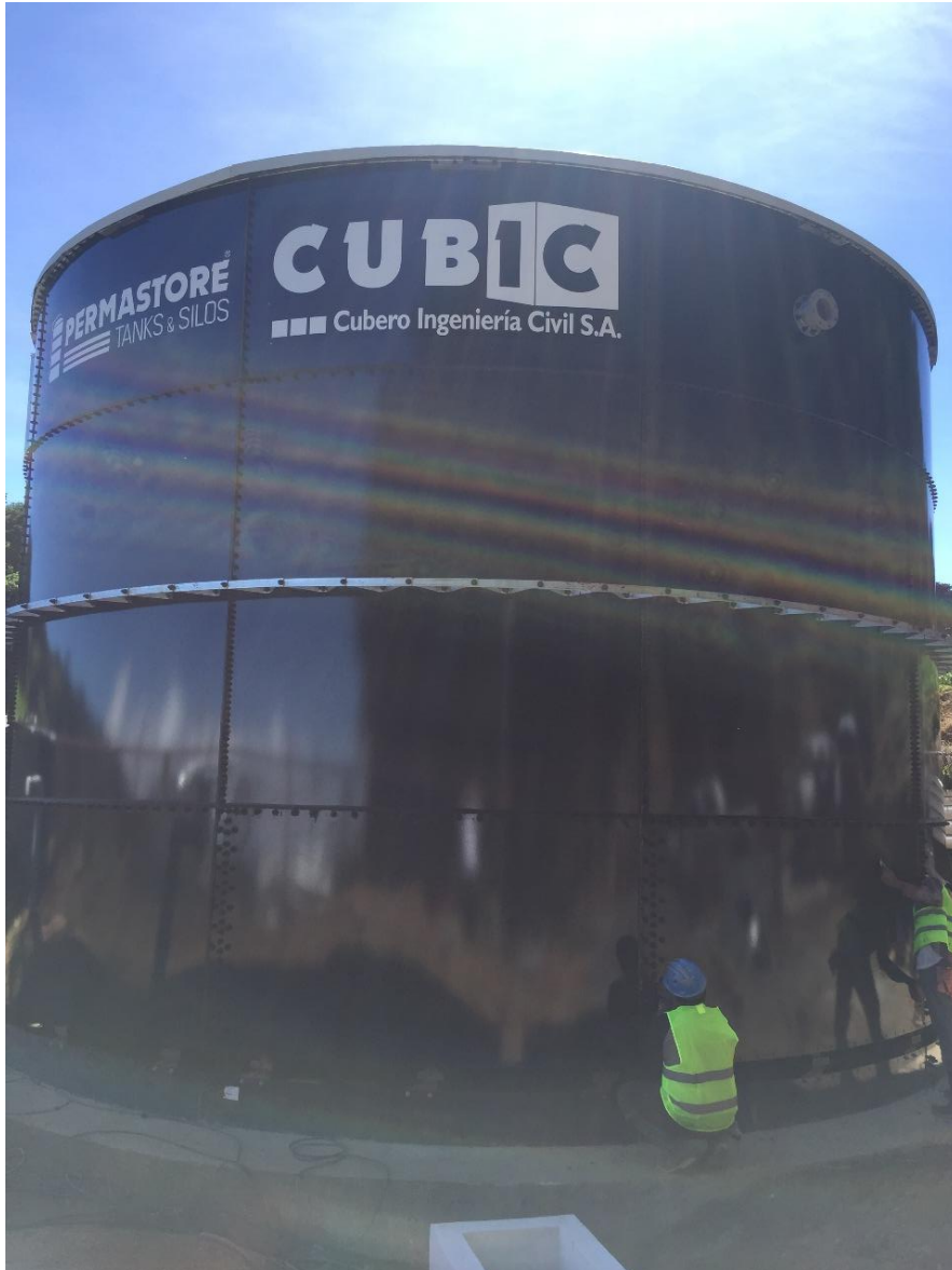
Anexo 18. Tanque Virgilio
