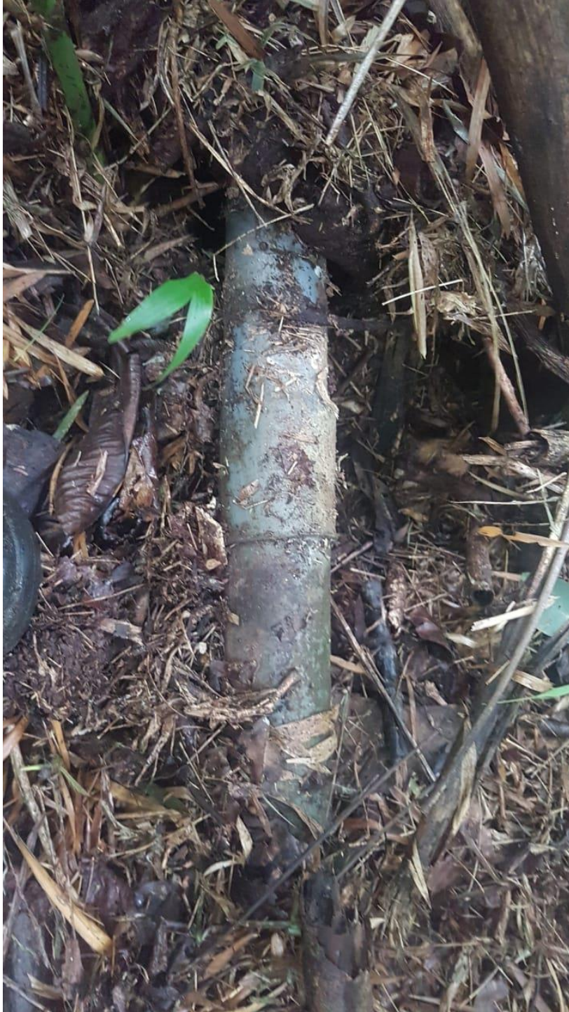
Anexo 10. Revisión de tubería. (Empalme PVC-HG)
