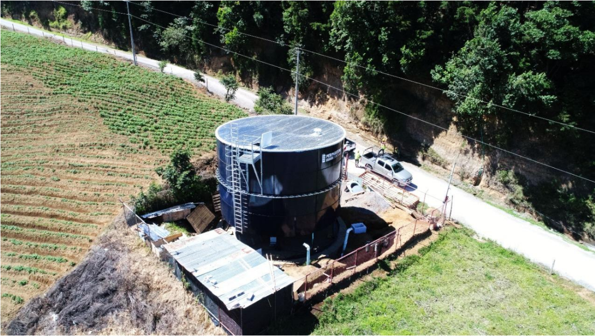
Anexo 19. Tanque Virgilio
