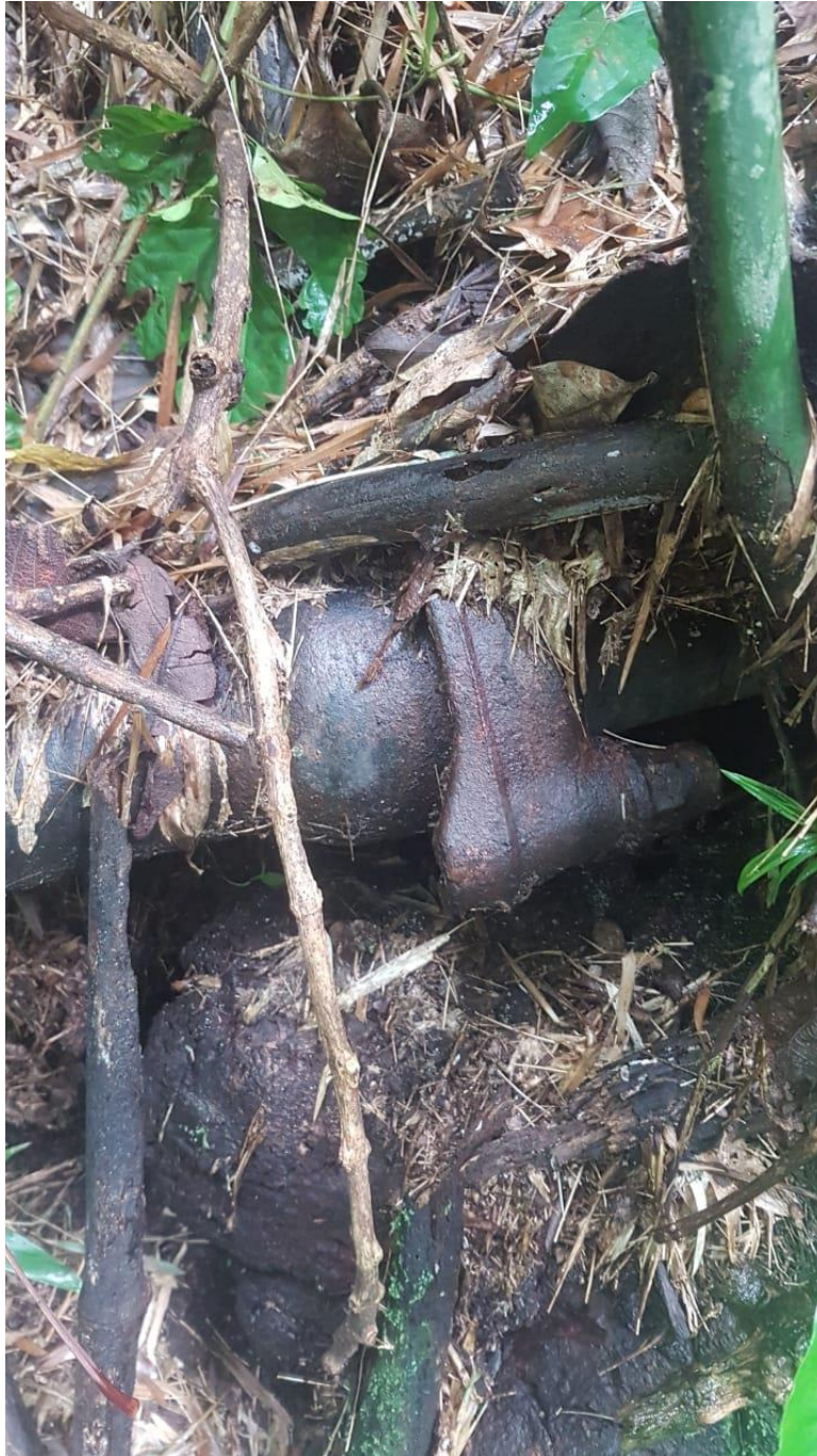
Anexo 9. Revisión de Tubería (Tubería vieja HG)
