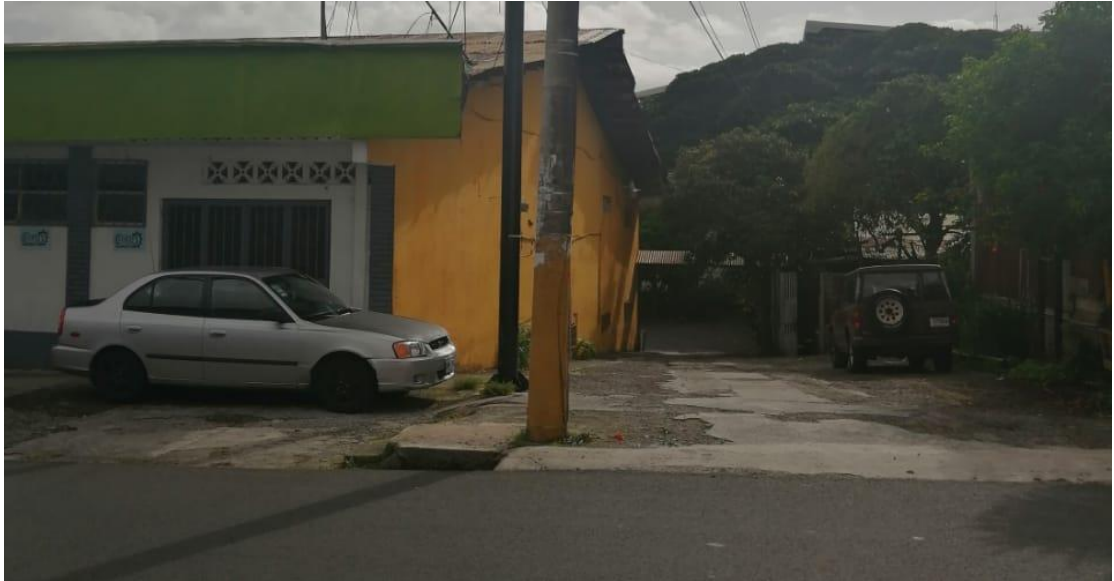
Anexo 4: Fotografía N°2 Fachada Principal, Construcción Actual
