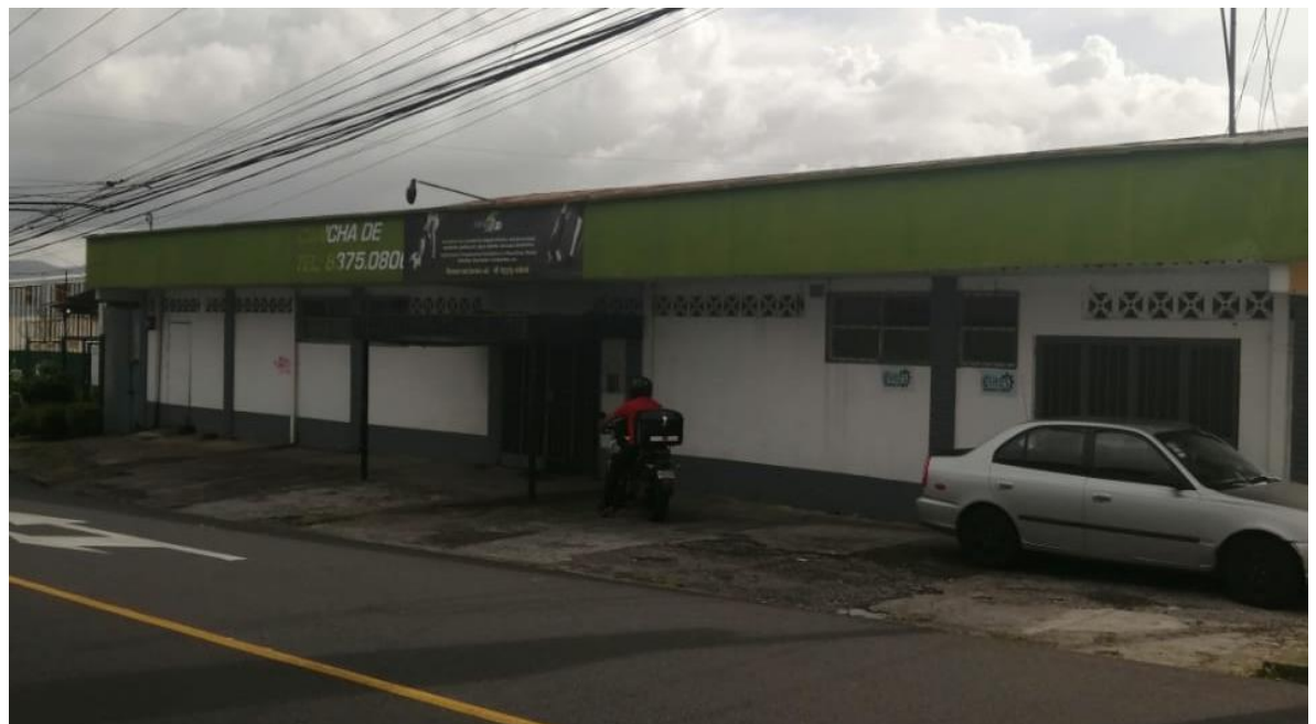
Anexo 3: Fotografía N°1 Fachada Principal, Construcción Actual
