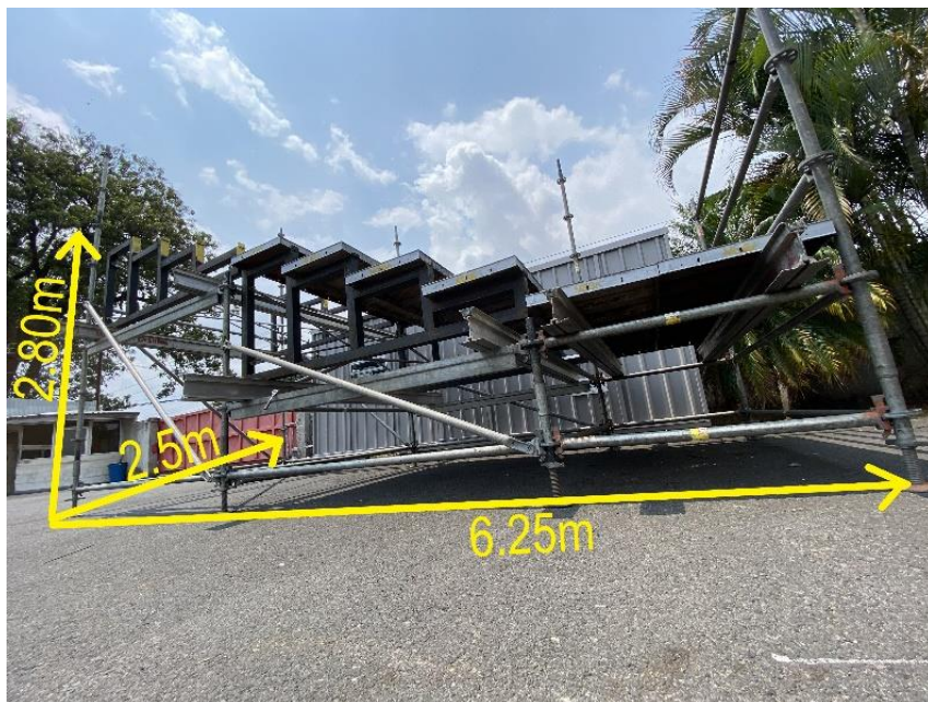
Figura 89. Dimensiones de gradería a construir.
