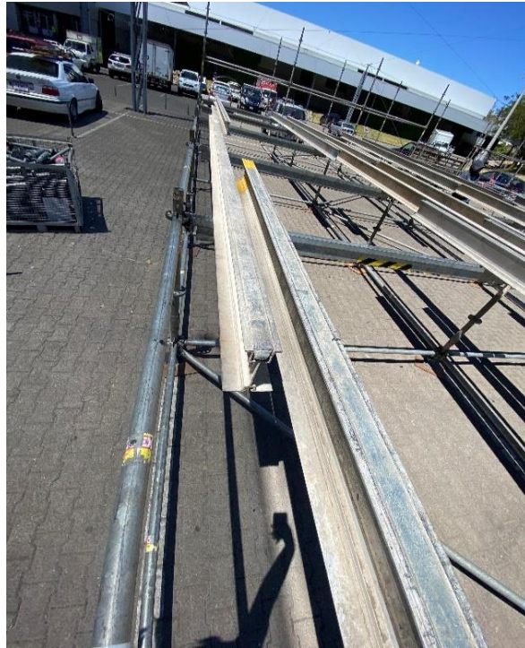
Figura 46. Viga de aluminio sentada sobre viga de carga.
