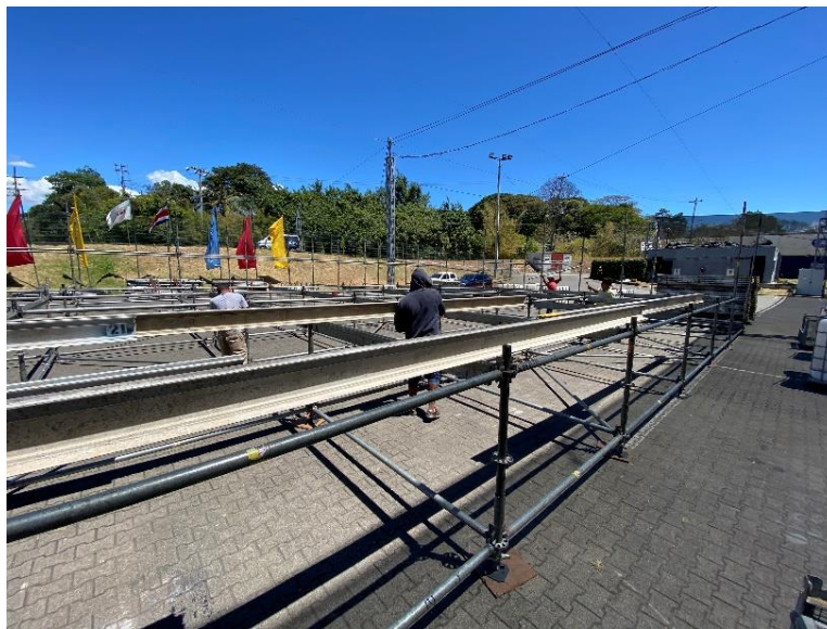
Figura 47. Viga de aluminio sentada sobre viga de carga.
