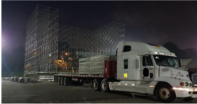
Figura 33. Distancia correcta para descarga del equipo.
