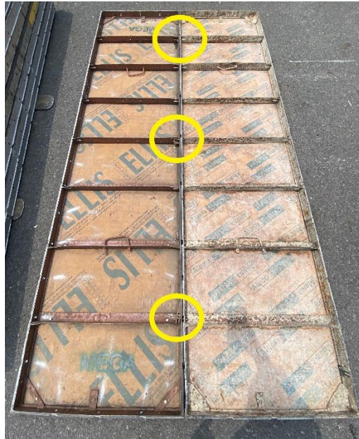
Figura 49. Colocación correcta de paneles y cuñas.
