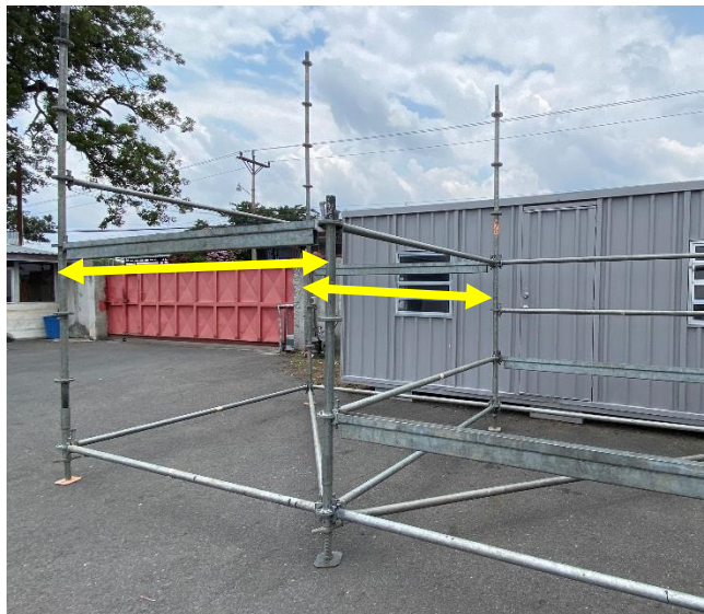
Figura 99. Colocación de Y de viga de carga bloque 3.
