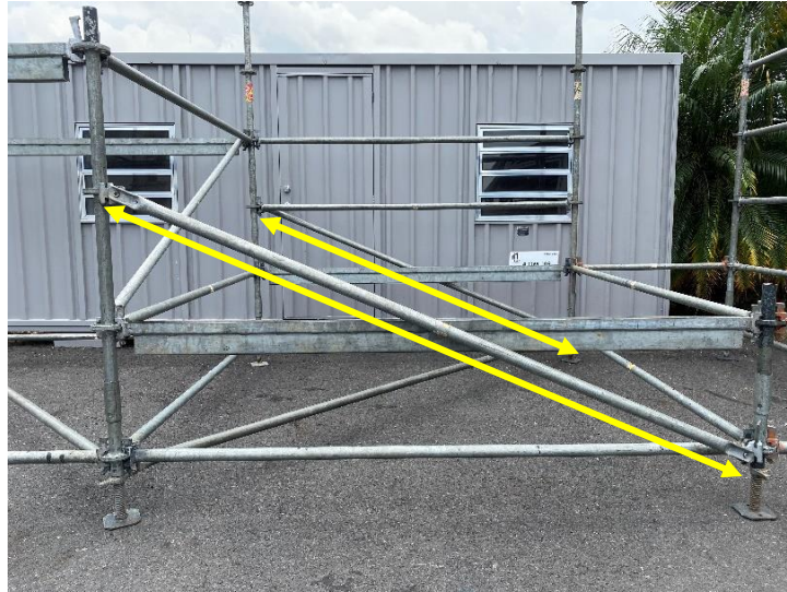
Figura 100. Colocación de Y de diagonales V en bloque 2.
