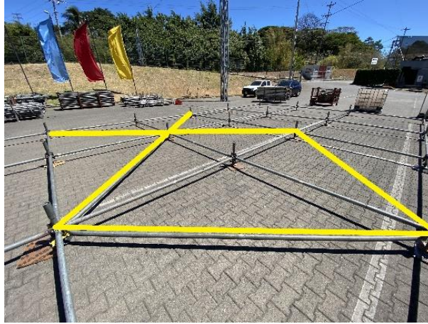
Figura 40. Patrón a seguir de tubos diagonales H
