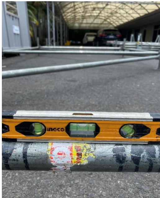
Figura 94. Nivelación de elementos.
