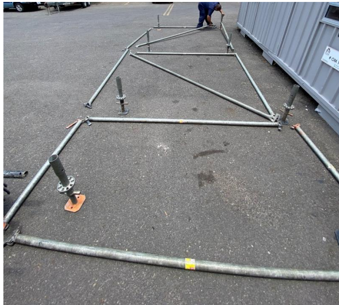
Figura 92. Distribución de tubos horizontales y diagonales H.
