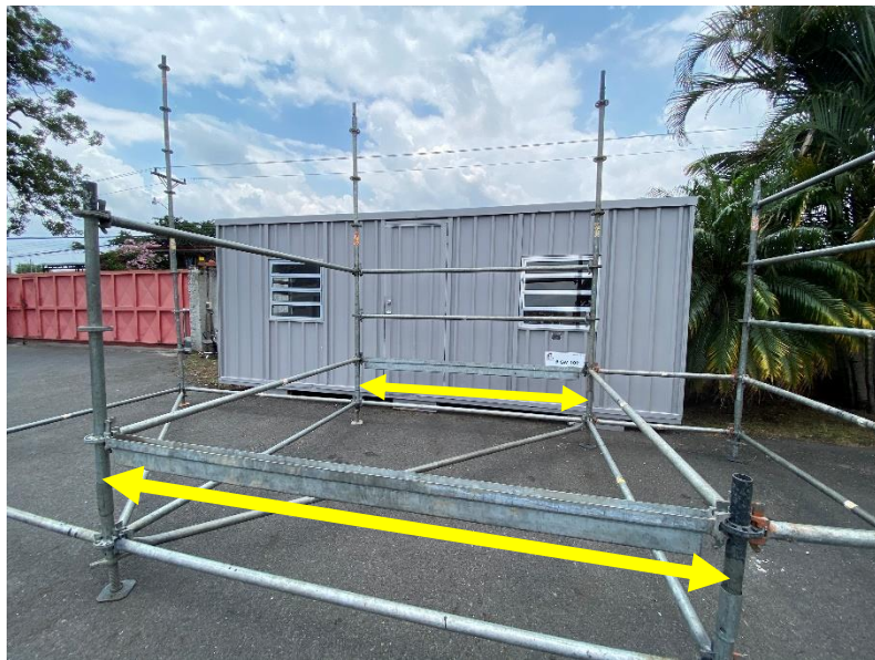
Figura 98. Colocación de Y de viga de carga bloque 2.
