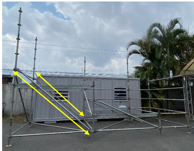
Figura 101. Colocación de Y de diagonales V en bloque 3.
