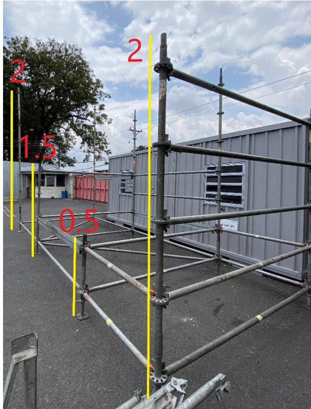
Figura 95. Alturas de tubos verticales para gradería.
