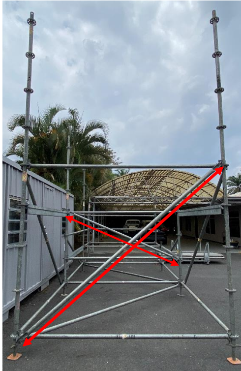
Figura 102. Colocación de diagonales V en el eje X para bloque 3.
