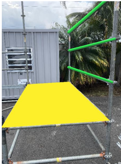
Figura 97. Pasillo y baranda frontal.
