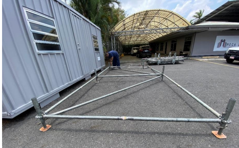
Figura 93. Elevación de tubos al primer nivel.
