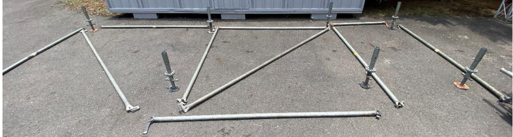
Figura 35. Distribución de tubos horizontales y diagonales.
