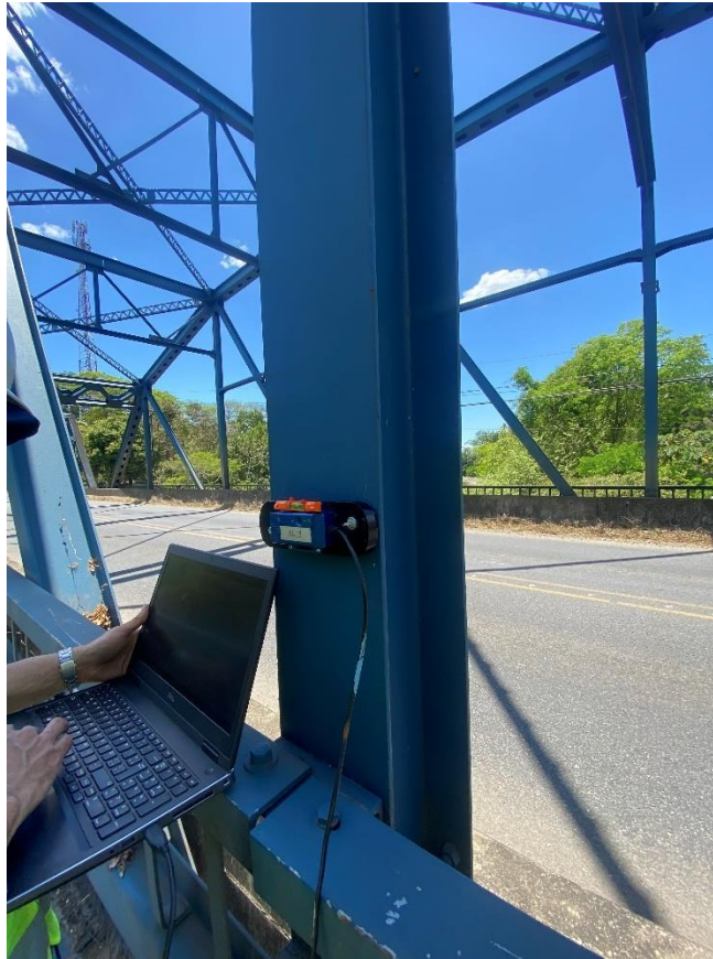
Figura 7. Colocación del sensor en la superestructura
