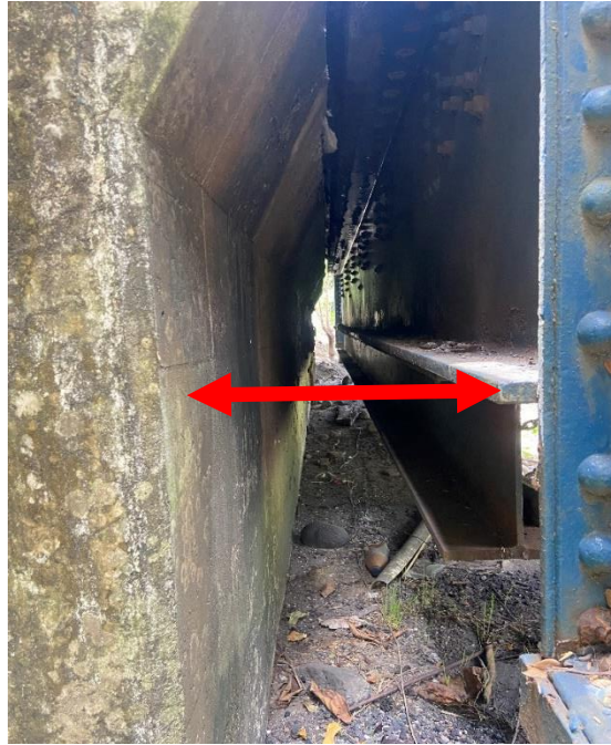
Figura 17. Distancia medida entre el patín inferior de viga diafragma y bastión
