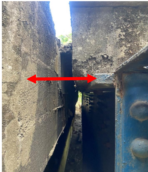
Figura 15. Distancia medida entre bastión y patín superior de viga diafragma
