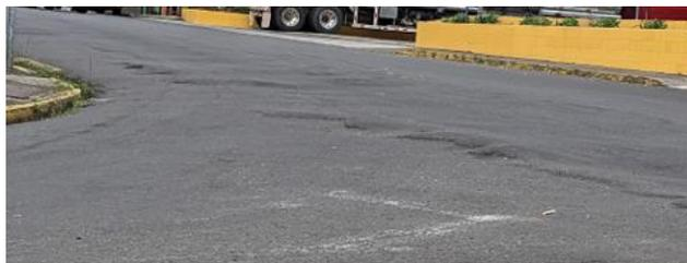
*Nota.* Se observa el ahuellamiento y la deficiente demarcación. Fuente propia.
