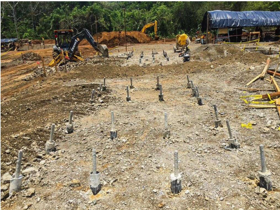
Figura 32. Proyecto de micropilotes.
