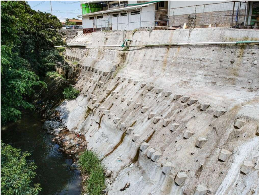
Figura 31. Proyecto de concreto lanzado y anclajes.
