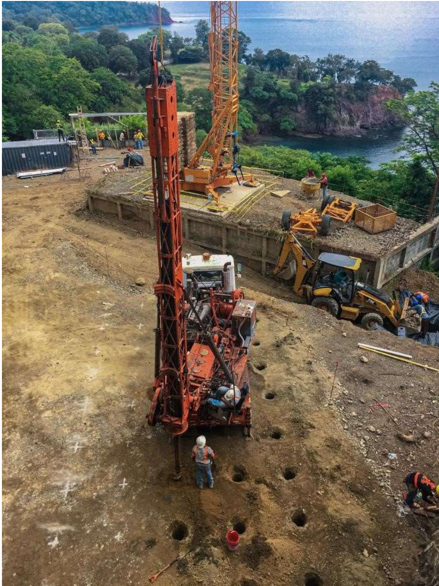
Figura 35. Perforación de pilotes en Tamarindo.
