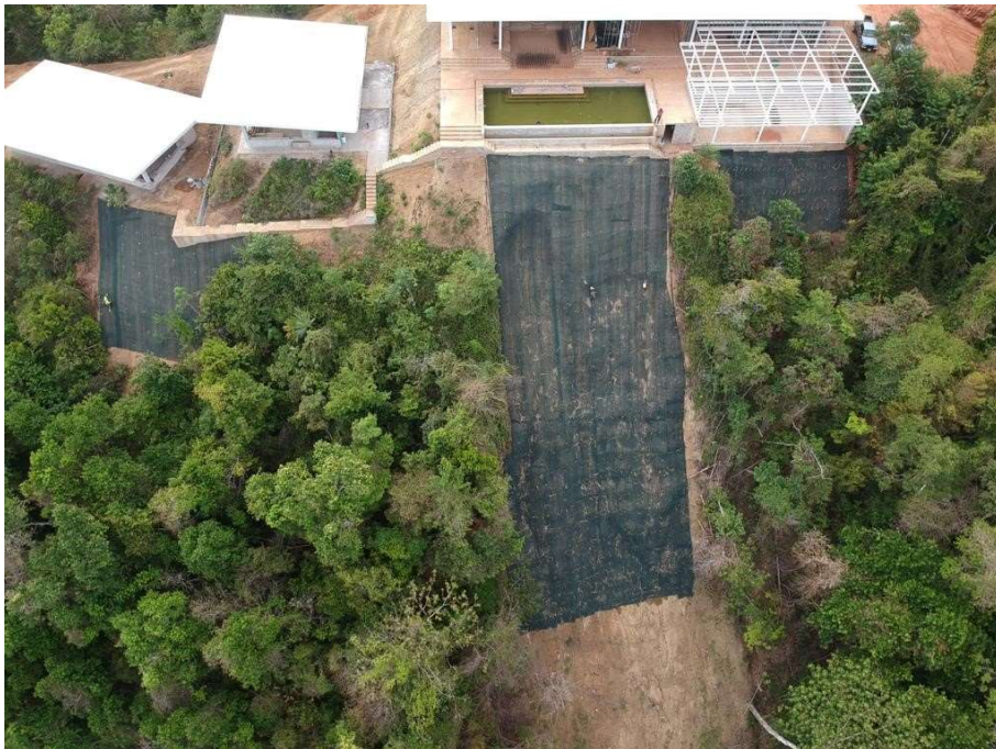
Figura 34. Reforzamiento de talud en Jacó.
