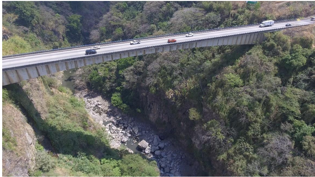
Figura 02: Vista lateral del puente. Fuente: Conavi. https://saep.conavi.go.cr/SAEP_CONAVI_Web/publico/pagInformacionPuente.xhtml?c=MTIINg==
