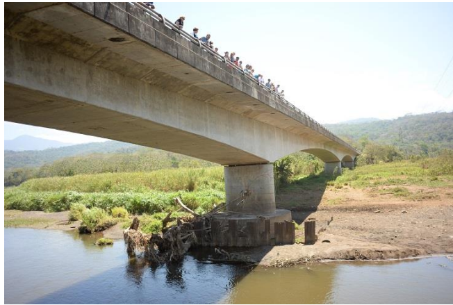
Ilustración 6 Viga de tipo cajón
