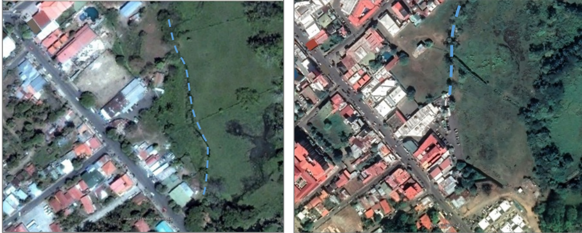
Figura 17. Entubado de cauce de dominio público para construcción de estacionamiento. Fotografía satelital comparativa 2012 - 2021
