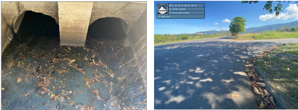
Figura 18. Hoja, sedimentos, aguas residuales y basura en cajas de registro y cunetas del alcantarillado pluvial existente
