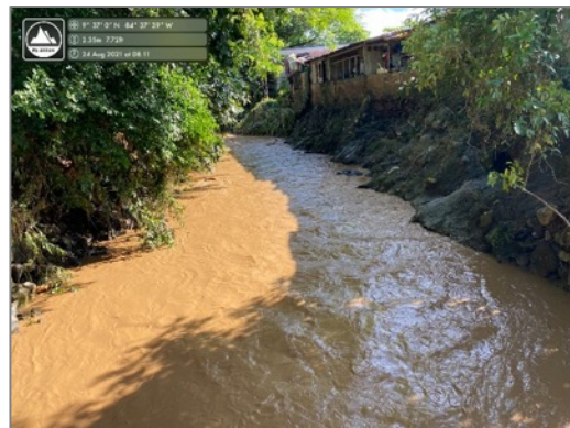
Figura 14. Estrangulamiento del Río Copey por viviendas dentro de la zona de protección, aguas arriba del cruce con la ruta Nacional N°34
