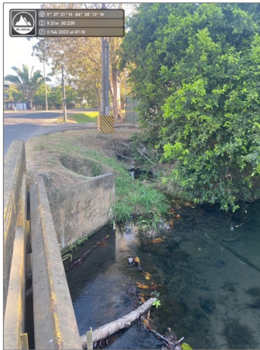
Figura 57. Desfogue de alcantarillado pluvial (cuneta paralela a Calle Bulevar Jacó) a la Quebrada Doña María
