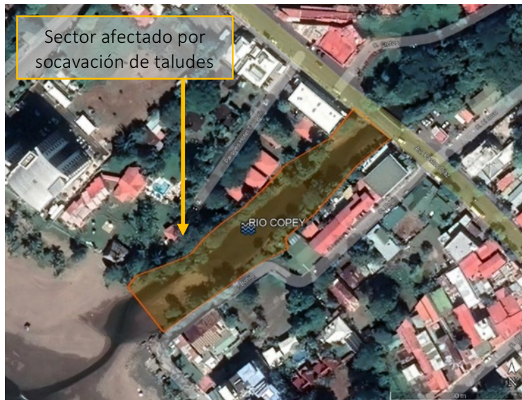
Figura 26. Sector del Río Copey, colindante con Calle Bohío en la desembocadura al mar, afectado por socavación de las márgenes
