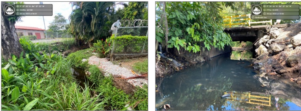
Figura 15. Estrangulamiento de afluente del Río Copey y Quebrada Lisa, por viviendas y puente respectivamente
