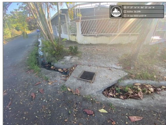
Figura 19. Aguas residuales en alcantarillado pluvial (cunetas) Urbanización Jaco Sol. Enero 2021
