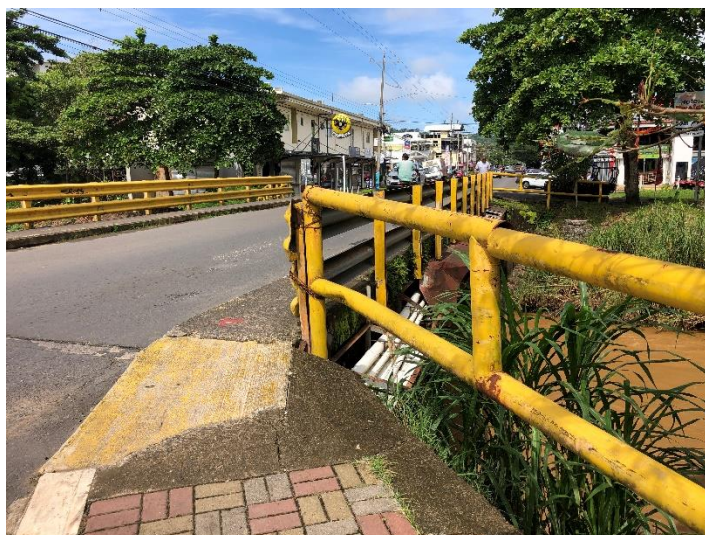
Ilustración 17 Barandas de acceso
