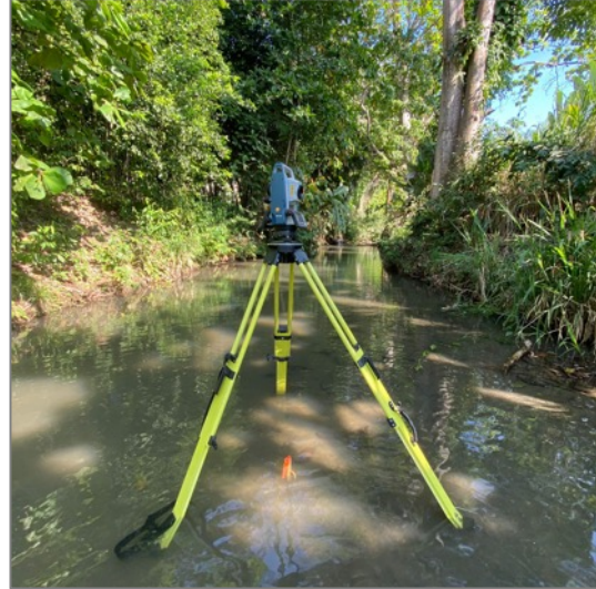
Figura 85. Levantamiento topográfico con estación total de secciones transversales Quebrada Lisa, Enero 2022
