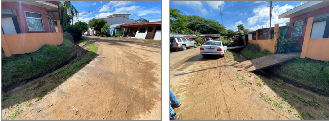
Figura 8. Arrastre de sedimentos al alcantarillado pluvial y calle municipal en el sector Barrio El INVU durante eventos de precipitación extrema de Agosto 2021
