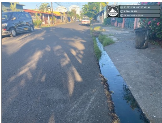
Figura 19. Aguas residuales en alcantarillado pluvial (cunetas) Urbanización Jaco Sol. Enero 2021
