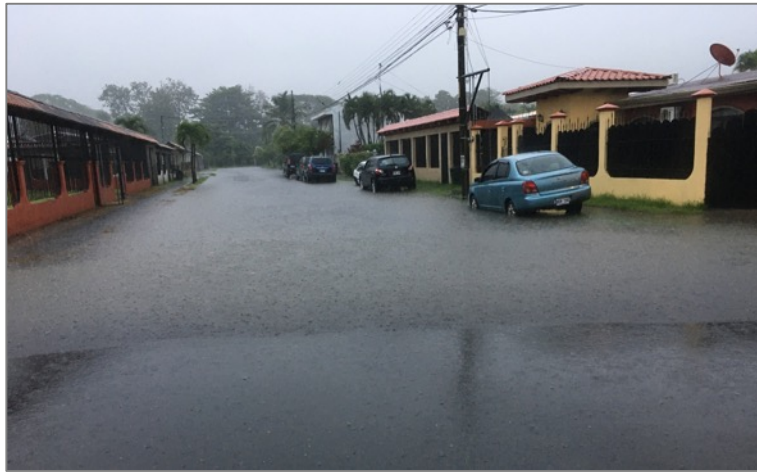
Figura 2. Ausencia de alcantarillado pluvial e inundación del derecho de vía, Sector Jaco Sol, 2021
