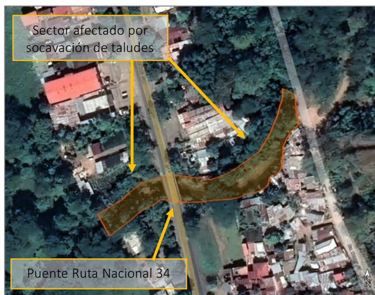
Figura 25. Sector del Río Copey, colindante con Barrio Copey, afectado por socavación de las márgenes
