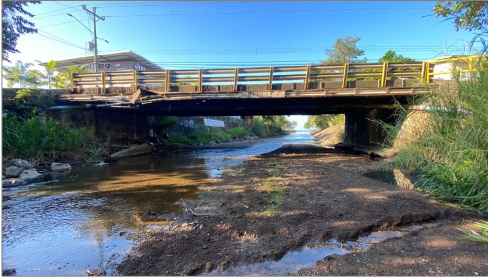
Figura 71. Puente sobre Río Copey, Avenida Pastor Díaz, tramo evaluado
