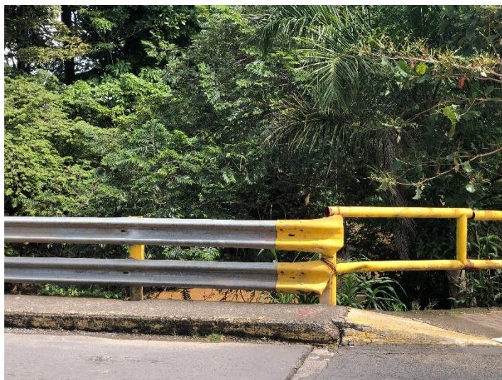
Ilustración 18 Aceras y baranda de acceso
