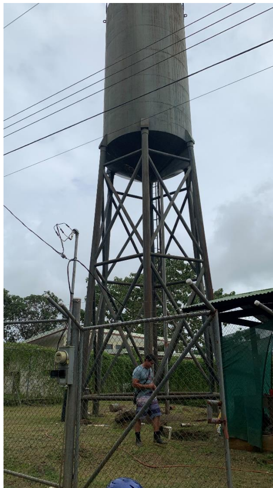
Tanque de almacenamiento de Las Tres Nazarenas
