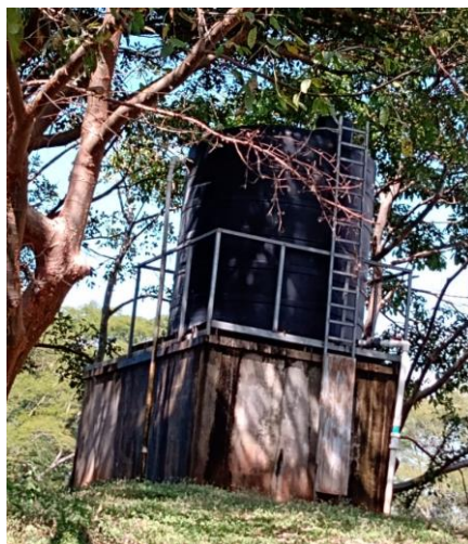
Ilustración 18 Tanque de almacenamiento #3 Fuente ASADA Lagunillas y Alto de Capulín., 14 de diciembre de 2022
