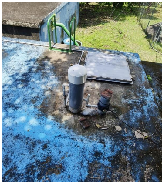
Ilustración 25 Sistema de Desinfección del agua Fuente Propia, 28 de setiembre de 2022
