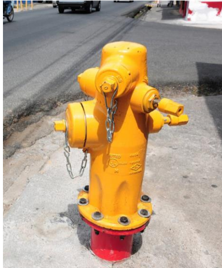
Ilustración 10 Hidrante Fuente: La Nación, 2015
