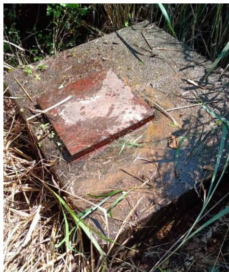
Ilustración 20 Tanque quiebra Gradiente Fuente ASADA Lagunillas y Alto de Capulín., 14 de diciembre de 2022
