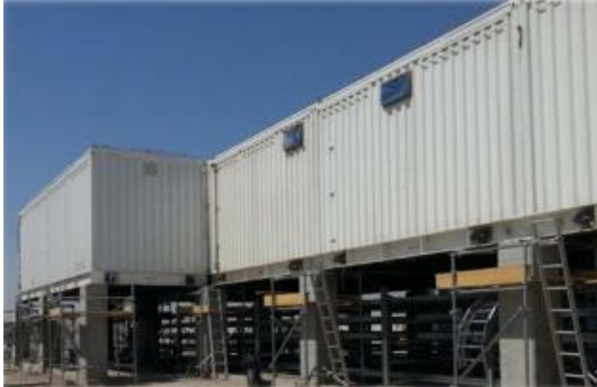
Figura 8: Vista de Pilotes de Concreto Para Colocación y Anclaje de un RIE.
