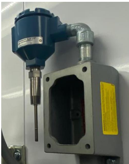
Figura 24: Sensor de Temperatura Rosemount 214C
