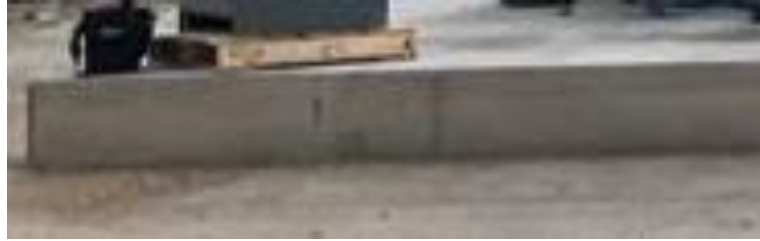
Figura 27: Base de Concreto
