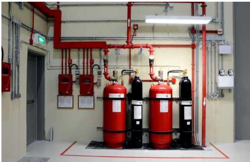
Figura 22:Partes de Sistema de Supresión de Incendios.
