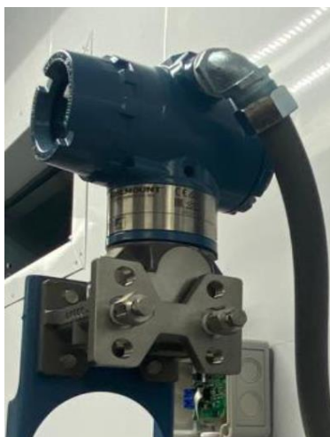
Figura 25: Transmisor de Presión Rosemount 3051
