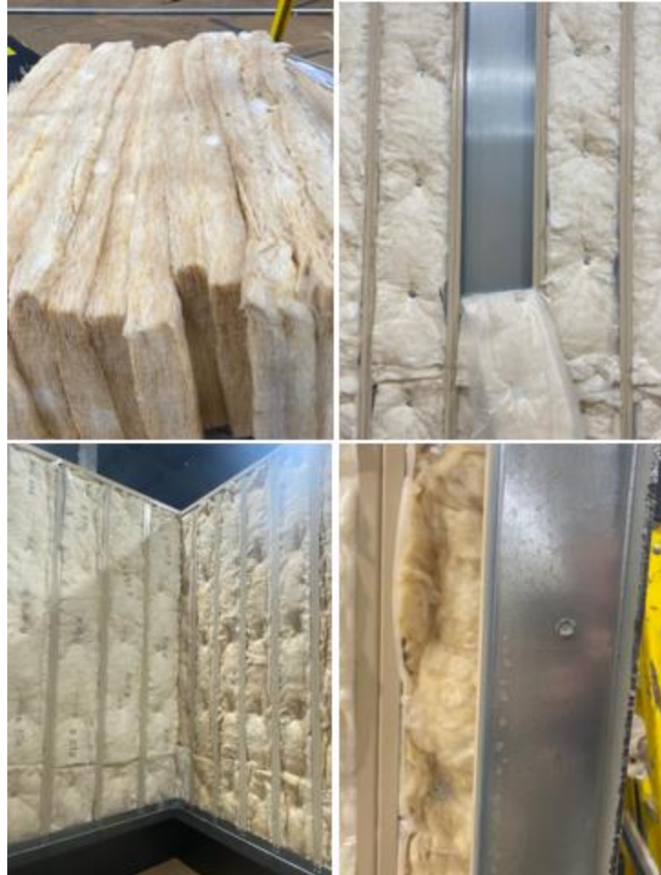
Figura 40:Detalle de Instalación de Fibra de Vidrio Como Aislante
