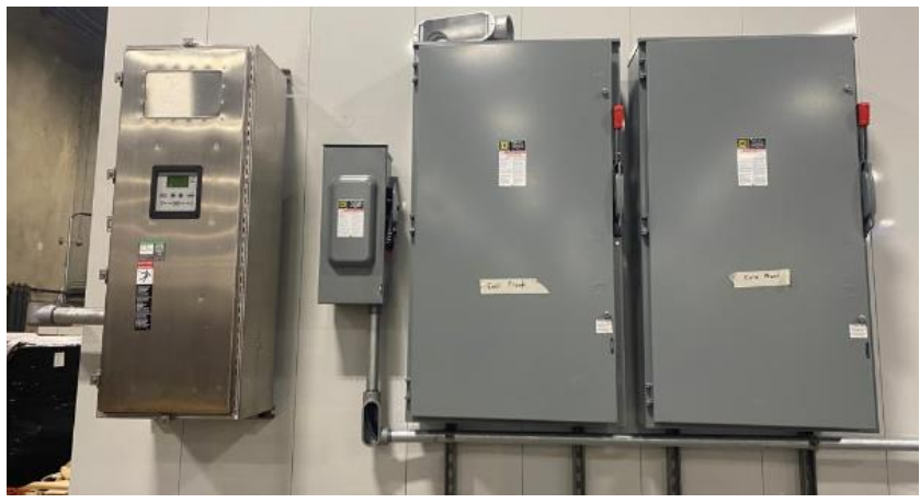
Figura 48:ATS y Desconectores
