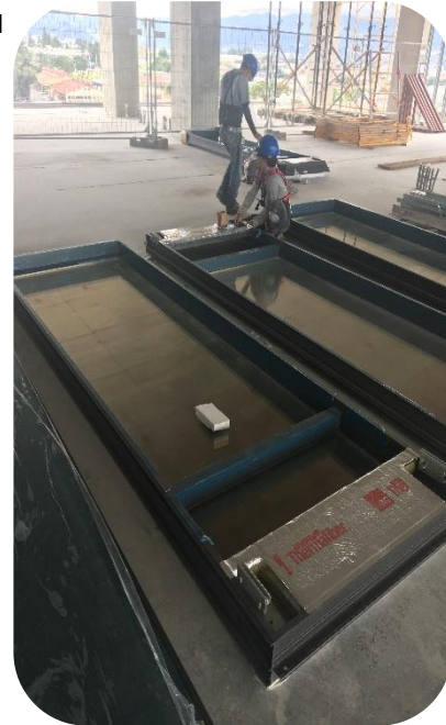
Ilustración 24. Inspección de paneles.
