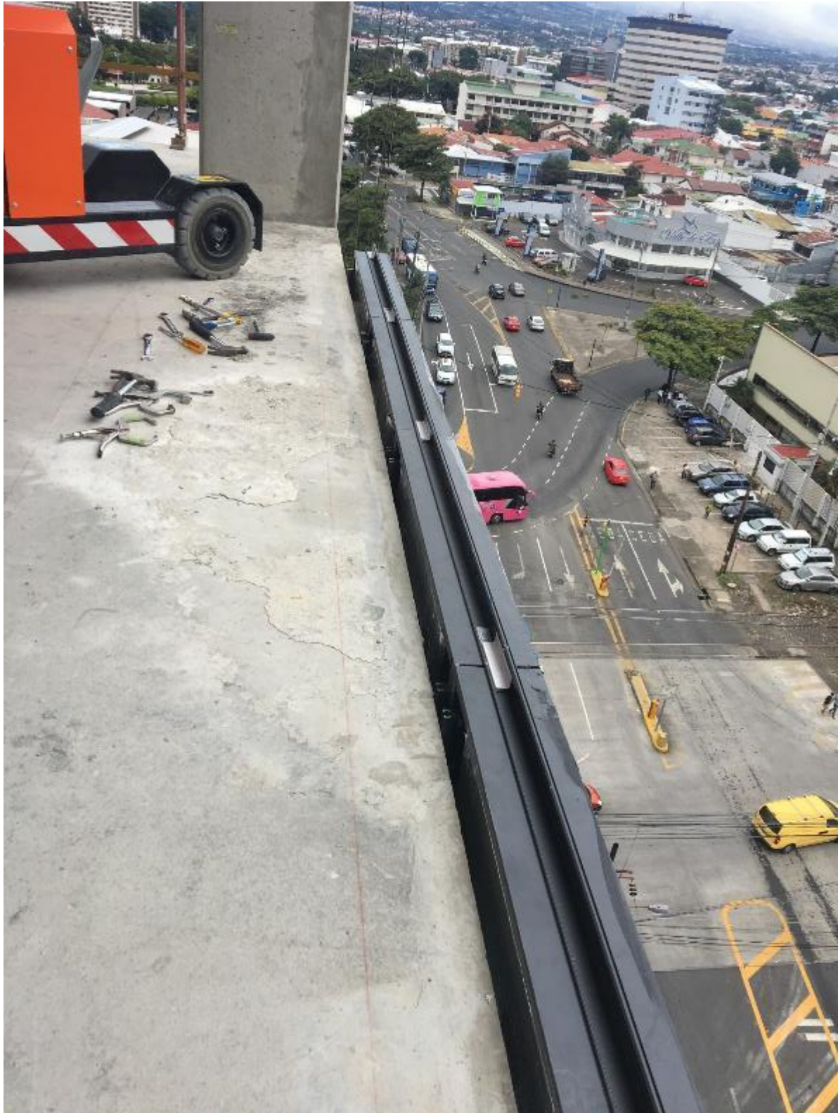
Ilustración 66. Inspección sobre plomos y nivelación. Fuente: Propia (2019)
