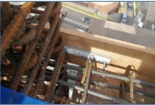
Ilustración 42. Encofrado 2. Fuente: Extralum (2019)
