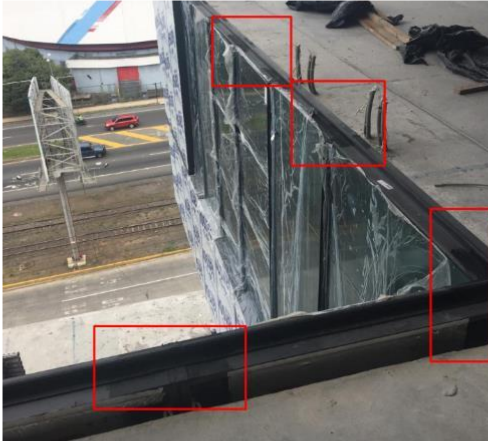
Ilustración 13. Recubrimiento membrana y silicón. Fuente: Propia (2019)
