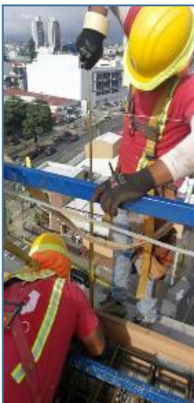
Ilustración 36. Instalación. Fuente: Extralum (2019)
