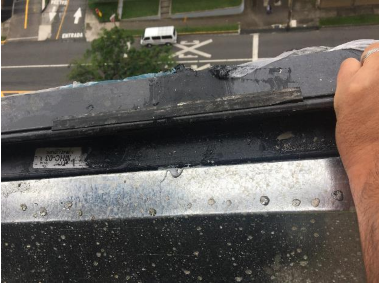
Ilustración 65. Inspección sobre protección silicón. Fuente: Propia (2019)
