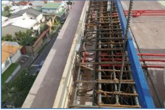
Ilustración 41. Encofrado. Fuente: Extralum (2019)
