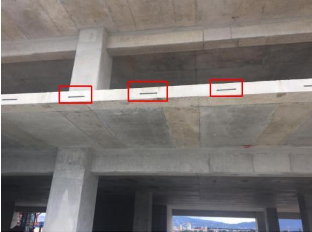
Ilustración 10. Previstas para anclar el sistema a la superestructura. Fuente: Propia (2019)
