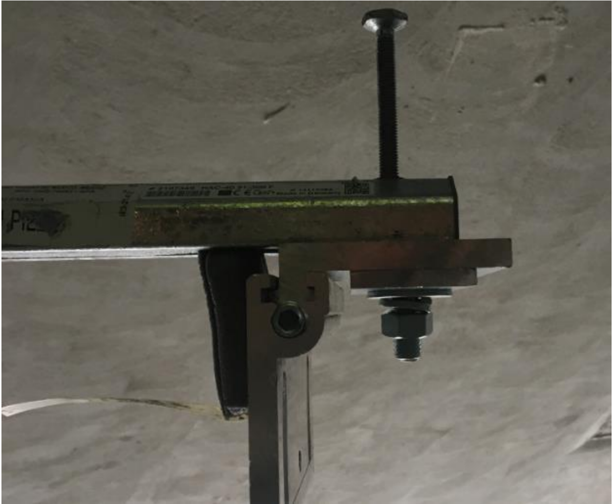
Ilustración 15. Anclaje HAC-40 91/300 F con elementos anclas y tornillo. Fuente: Propia (2019)
