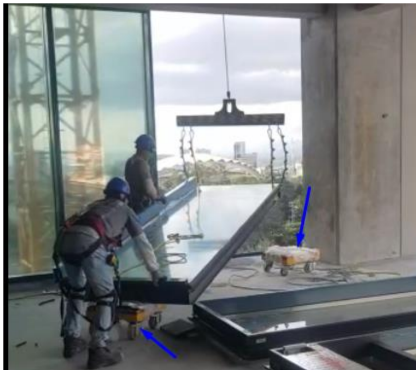
Ilustración 28. Señalados con flechas azules, los carritos de apoyo para el izado de paneles.
