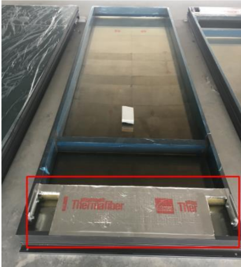
Ilustración 24. Lana mineral colocada en panel. Fuente: Propia (2019)
