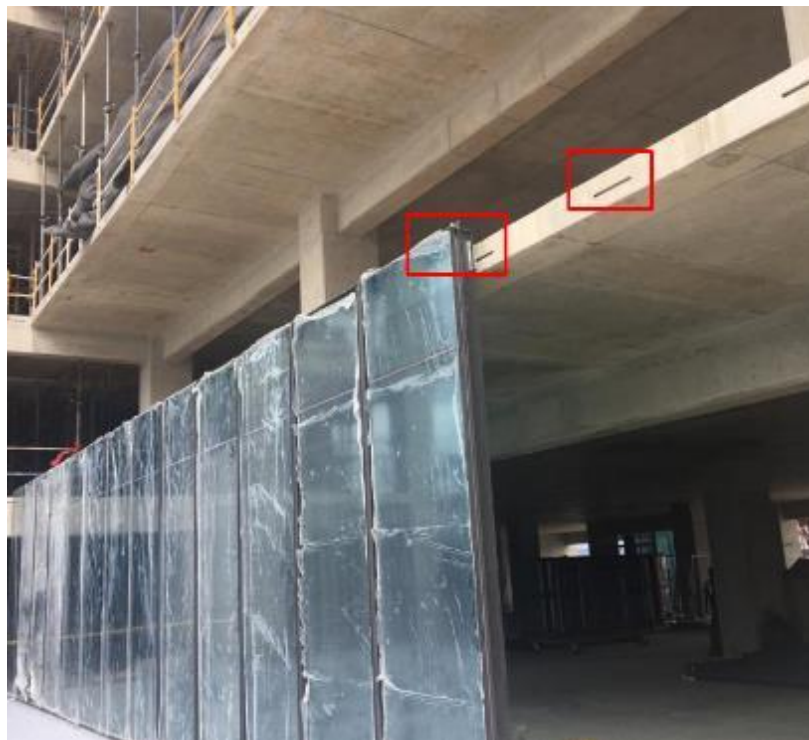
Ilustración 9. Sistema de anclaje fachada unitizado. Fuente: Propia (2019)
