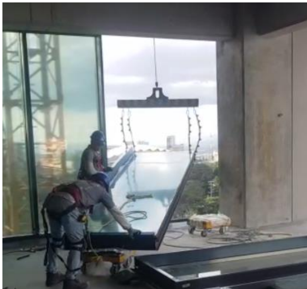
Ilustración 22. Levantamiento de paneles.
