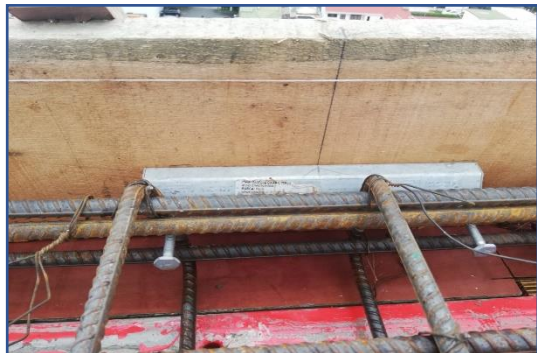
Ilustración 12. Colocación anclaje en encofrado.
