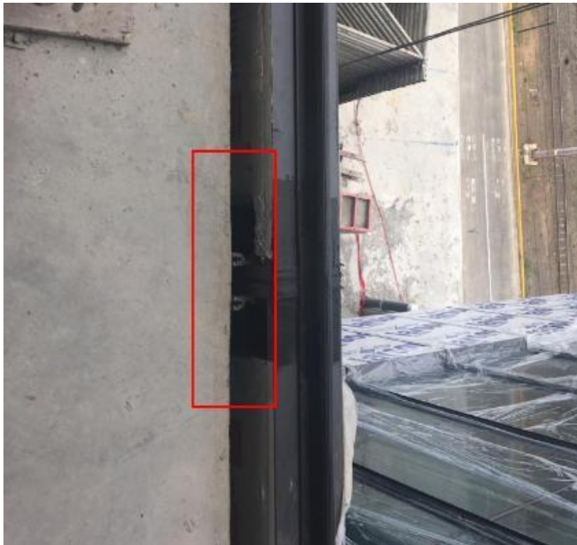
Ilustración 12. Anclajes panel a superestructura. Fuente: Propia (2019)
