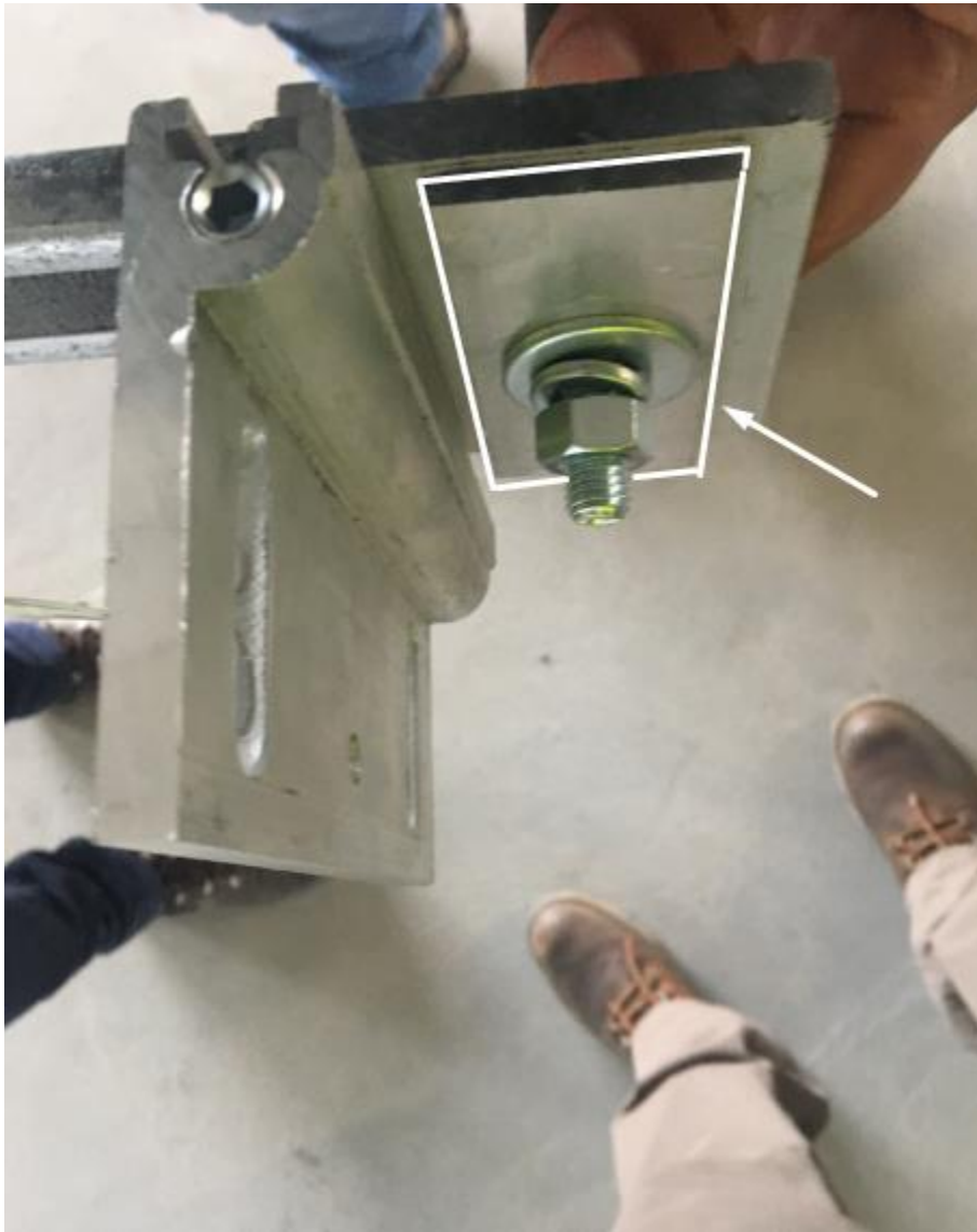
Ilustración 21. Refuerzo Ancla colocado en conjunto con ancla macho y ancla hembra. Fuente: Propia (2019)
