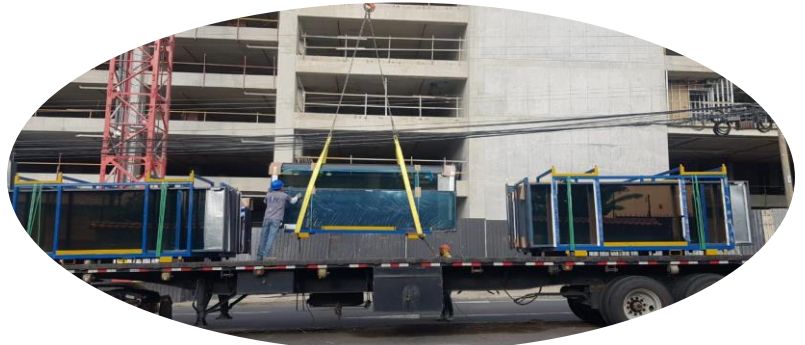
Ilustración 5. Descarga en obra.
