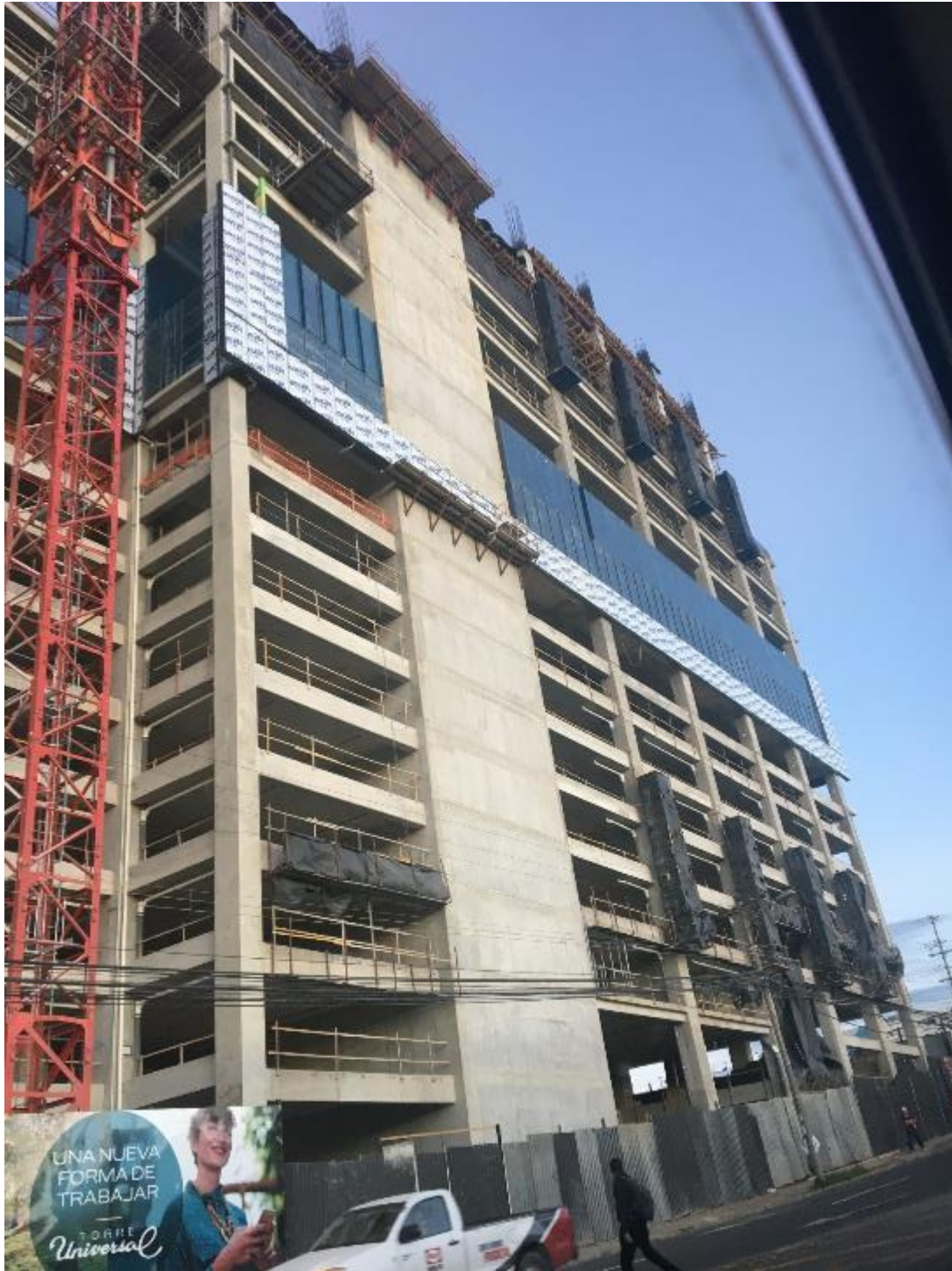
Ilustración 67. Etapas tempranas de la instalación. Fuente: Propia (2019)
