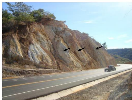
Figura 20: Talud en terreno afectado por alteración hidrotermal
