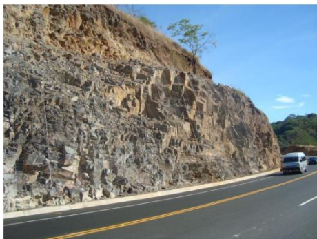
Figura 21: Macizo rocoso fracturado
