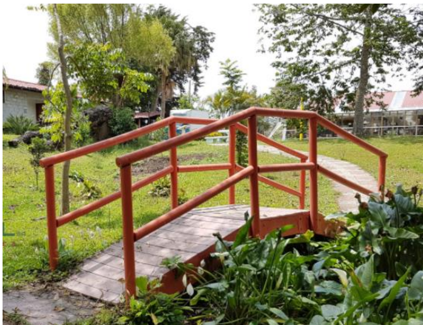
Figura 26. Puentes en puntos de riesgo
