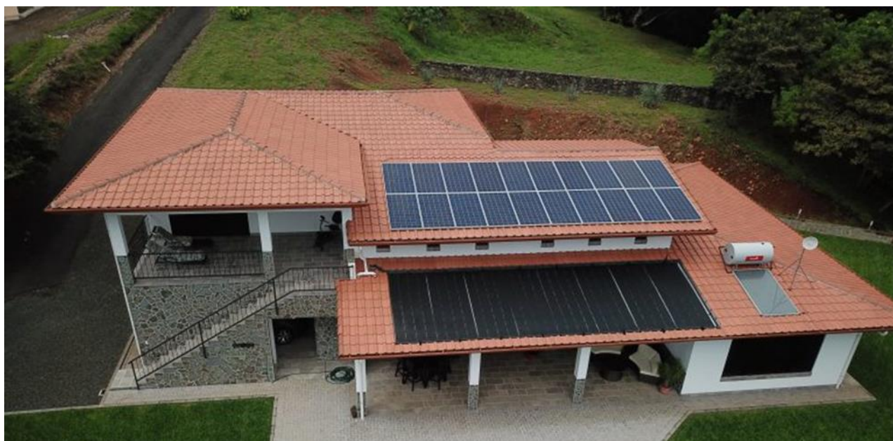
Figura 28. Paneles solares, imagen de referencia
