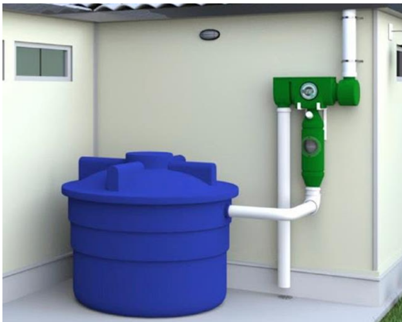
Figura 24. Sistema de captación de aguas de lluvia
