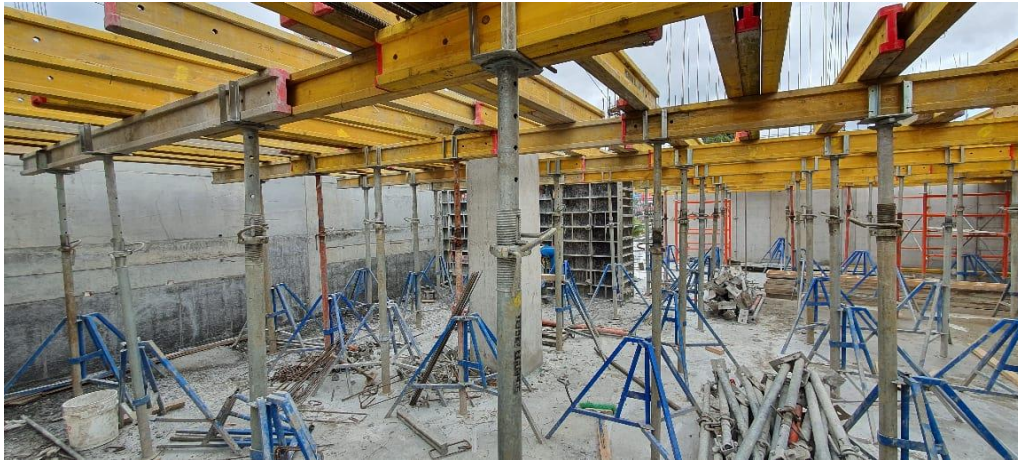
Figura 16: Instalación vigas de madera para losa del nivel +12,75.
