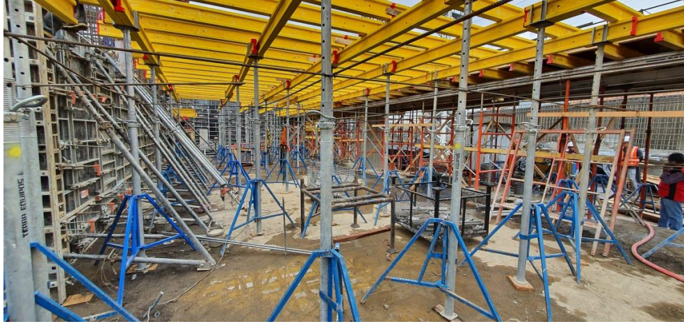
Figura 15: Puntales de carga para nivel +3,50.
