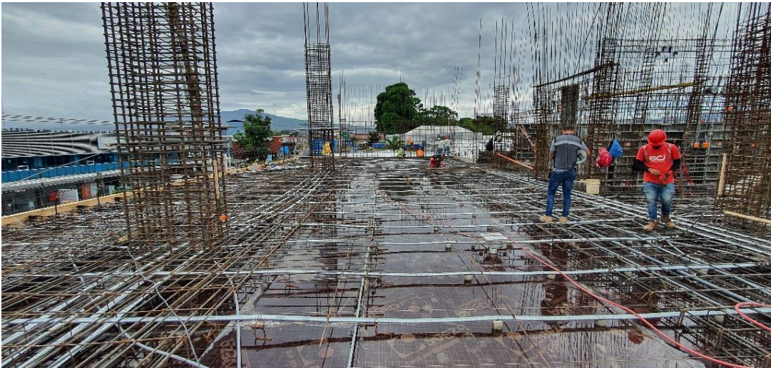
Figura 32: Limpieza de losa del nivel +8,25.
