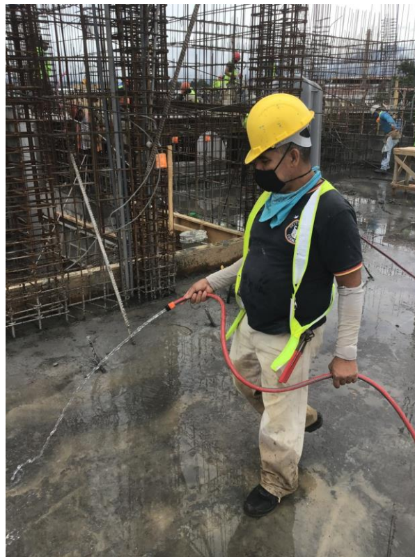
Figura 37: Curado de losa del nivel +14,25.
