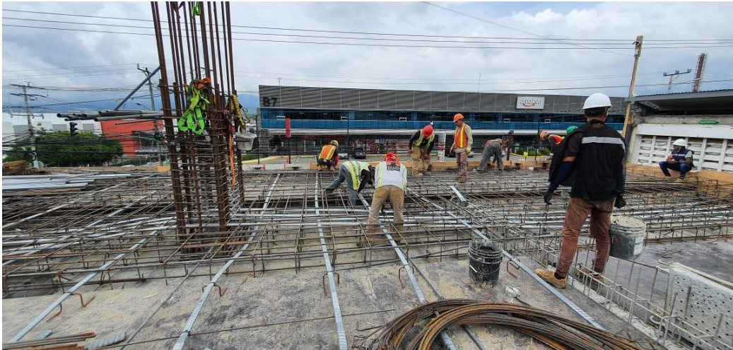
Figura 26: Colocación de torones del nivel +5,25.
