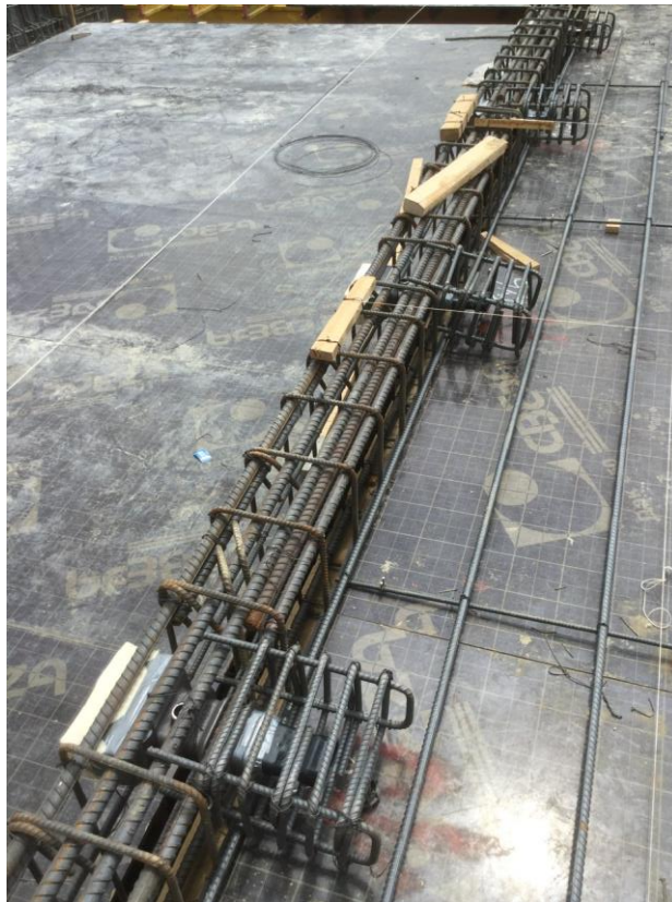
Figura 21: Instalación anclajes activos del nivel 0+00.
