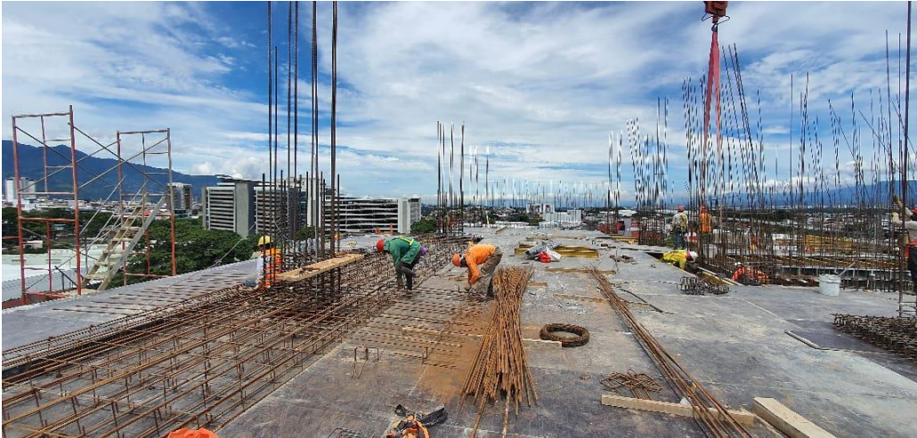
Figura 20: Instalación armadura losa eje E del nivel +18,70.
