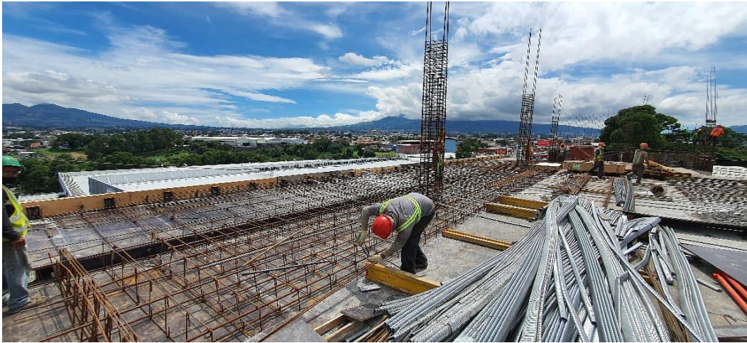
Figura 18: Instalación encofrado perimetral del nivel +18,70.
