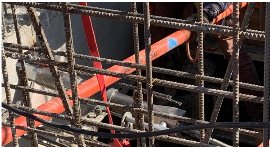
Figura 38: Tensado con gato hidráulico de losa en nivel 0+00.
