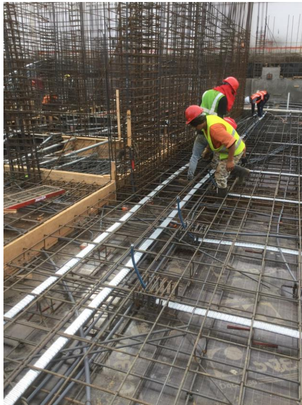
Figura 29: Revisión de altura de torones del nivel 0+00.
