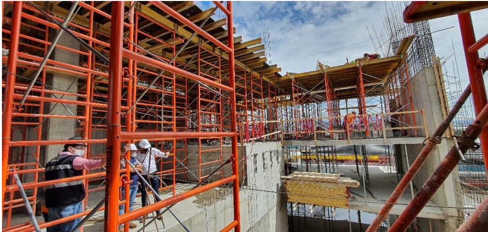
Figura 13: Andamios de carga en doble altura para nivel +18,70.
