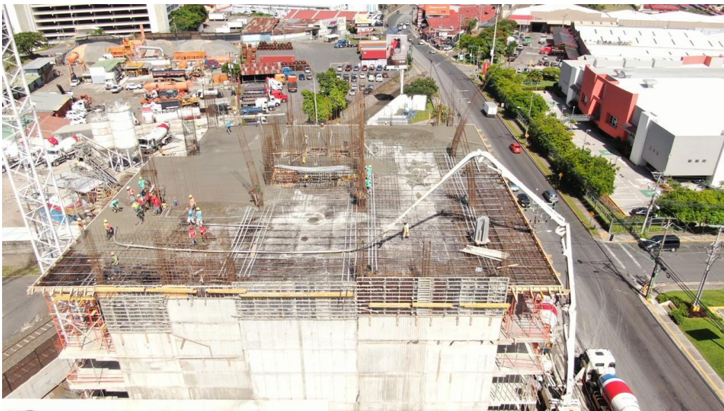
Figura 36: Captura aérea colada de losa del nivel +18,70.
