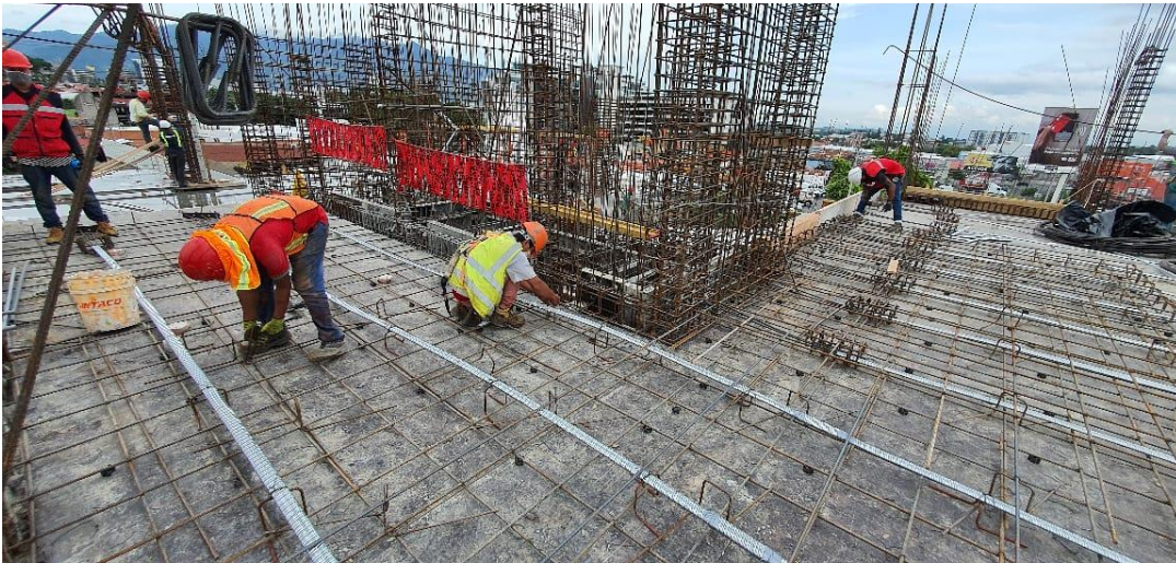
Figura 22: Colocación caballetes para torones del nivel +11,25.
