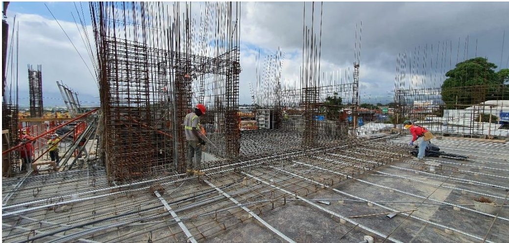
Figura 28: Colocación armadura superior nivel del nivel +12,75.
