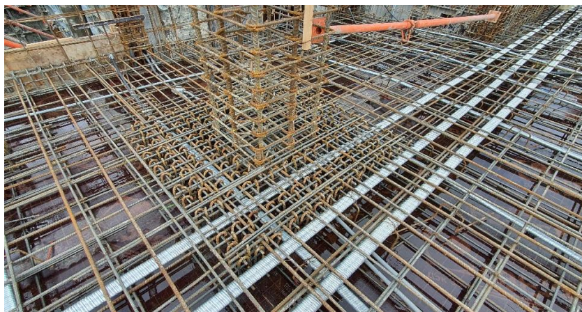
Figura 25: Representación nivel complejidad de ganchos en columnas con torones.
