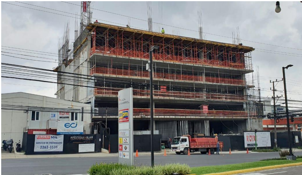
Figura 39: Apuntalamiento de losas del nivel +11,25, +14,25, +18,70.
