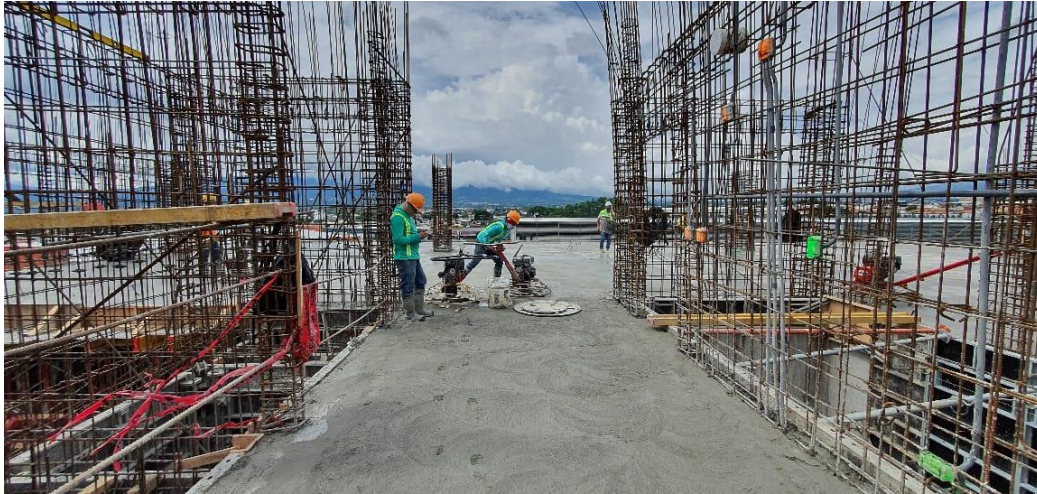
Figura 35: Lujado de losa del nivel +14,25.
