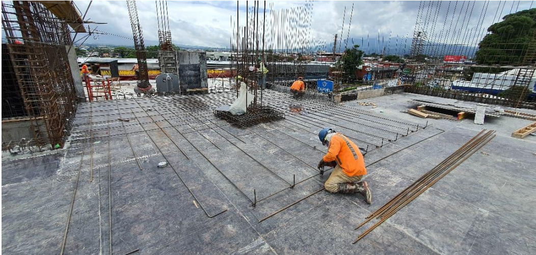
Figura 19: Instalación armadura inferior del nivel +12,75.
