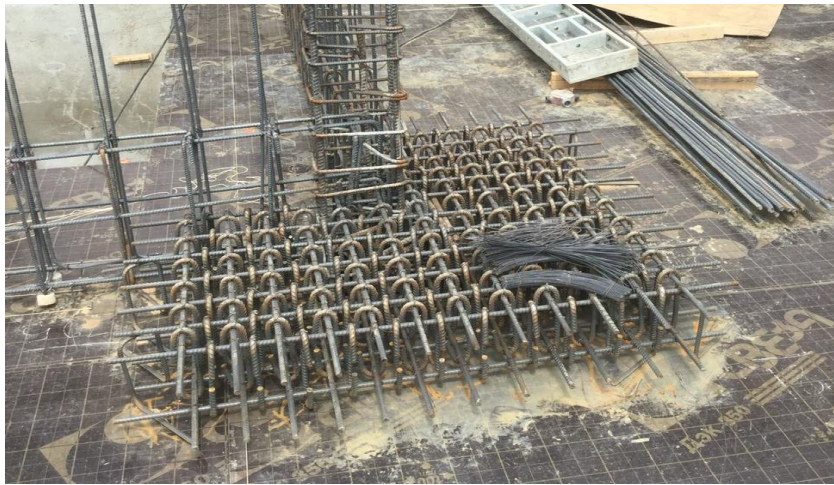
Figura 24: Armadura en columna de ganchos sobre el nivel 0+00.
