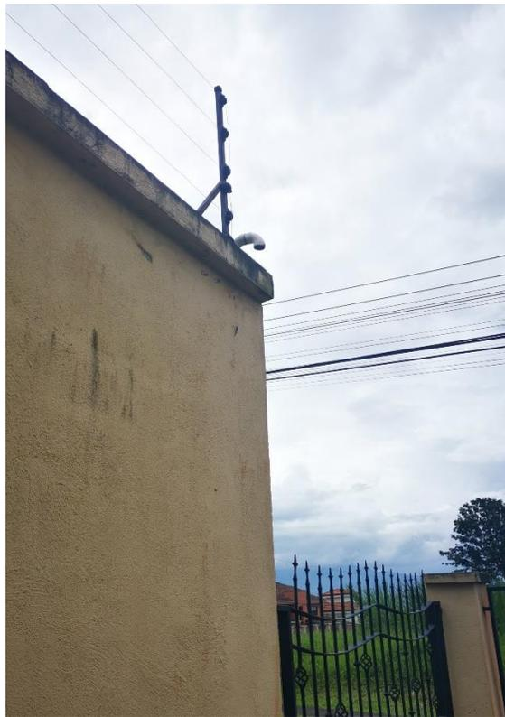
**Ilustración No° 19:** Ejemplo de tubería de ventilación del tanque séptico colocada en la parte superior de una tapia aladaña.
