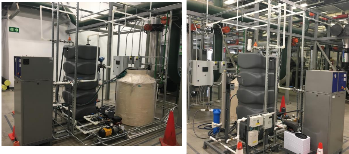
Ilustración 20 Imagen final de distribución e instalación
