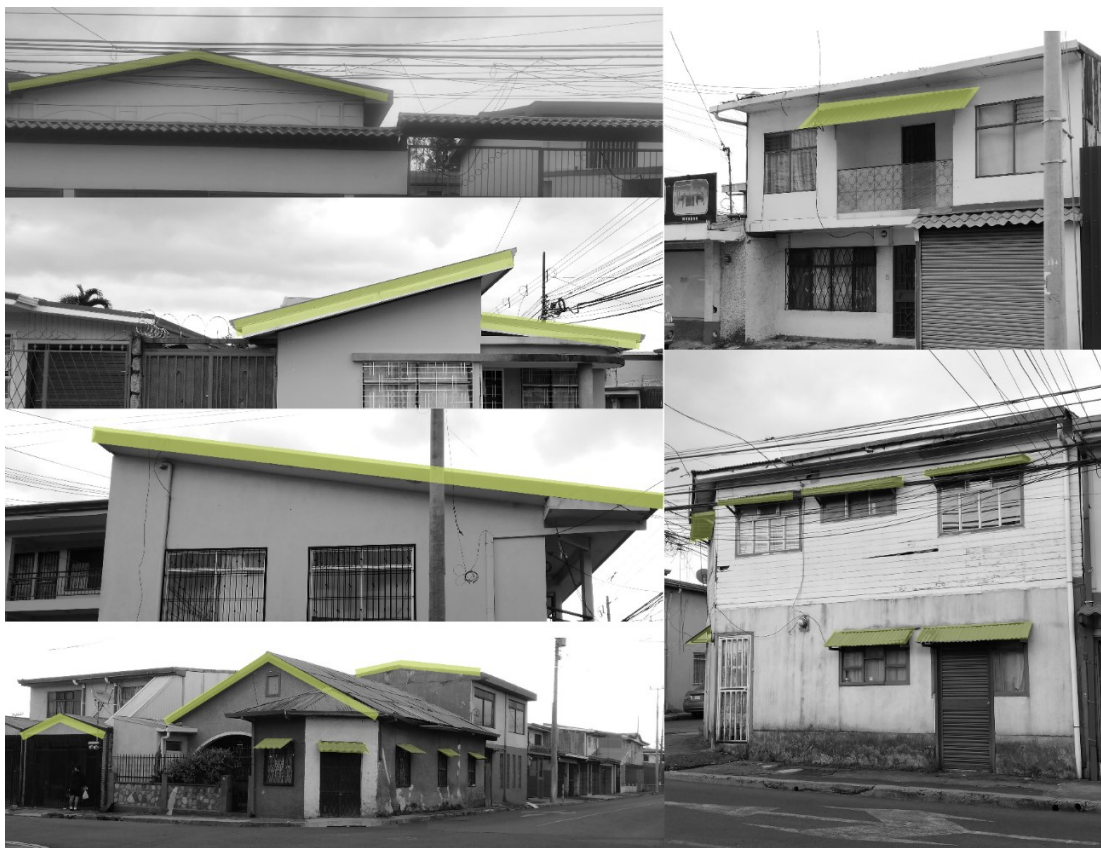
Figura 14 Tipología de cubiertas en la vivienda, Guadalupe
