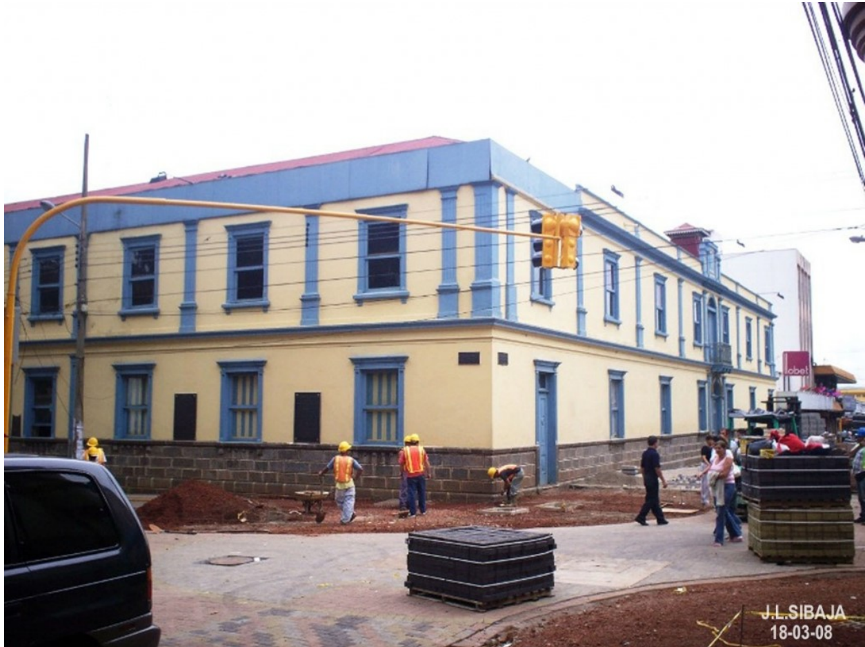
Figura 9: Obras frente a la casa de la cultura en av. dos y calle central
