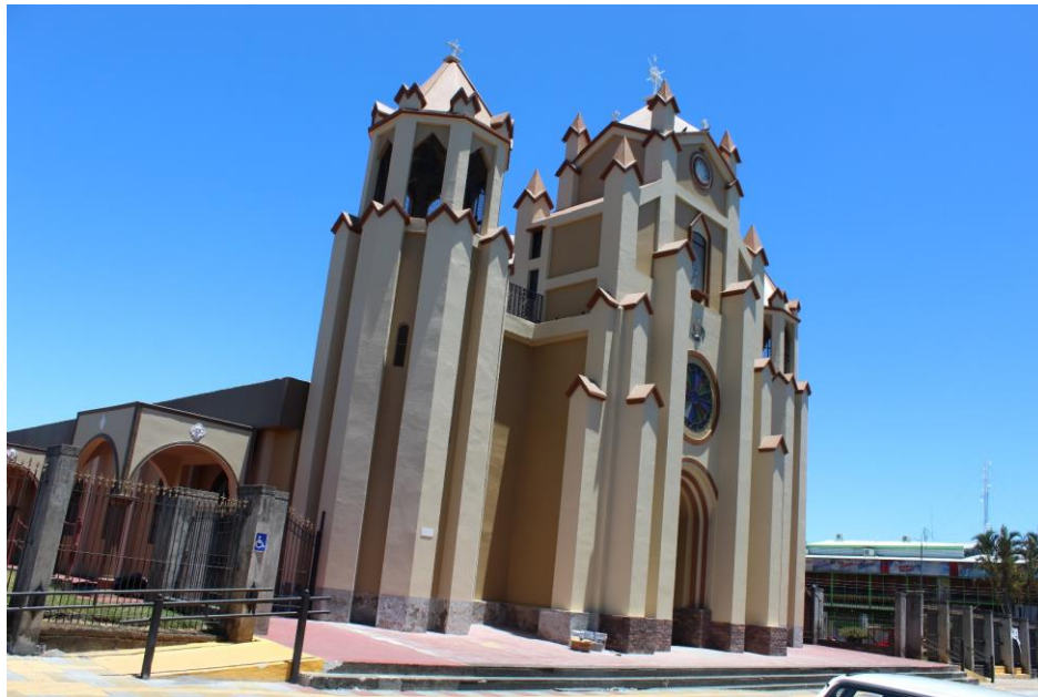
Figura 32. Iglesia de Santa Bárbara de Heredia.
