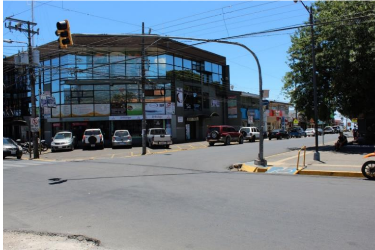
Figura 40. Edificación de tres niveles
