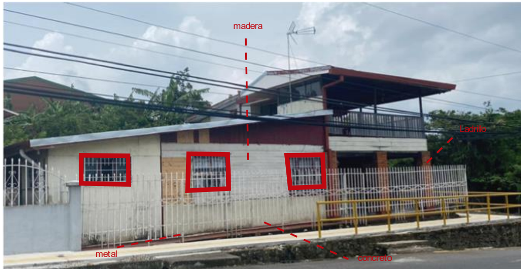
Figura 55. Materialidad y ventanería cerca del lote a intervenir , cantón de San Isidro de Heredia
