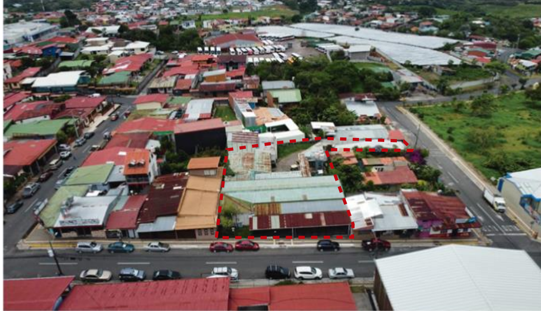
Figura 52. Lote por intervenir, cantón de San Isidro de Heredia
