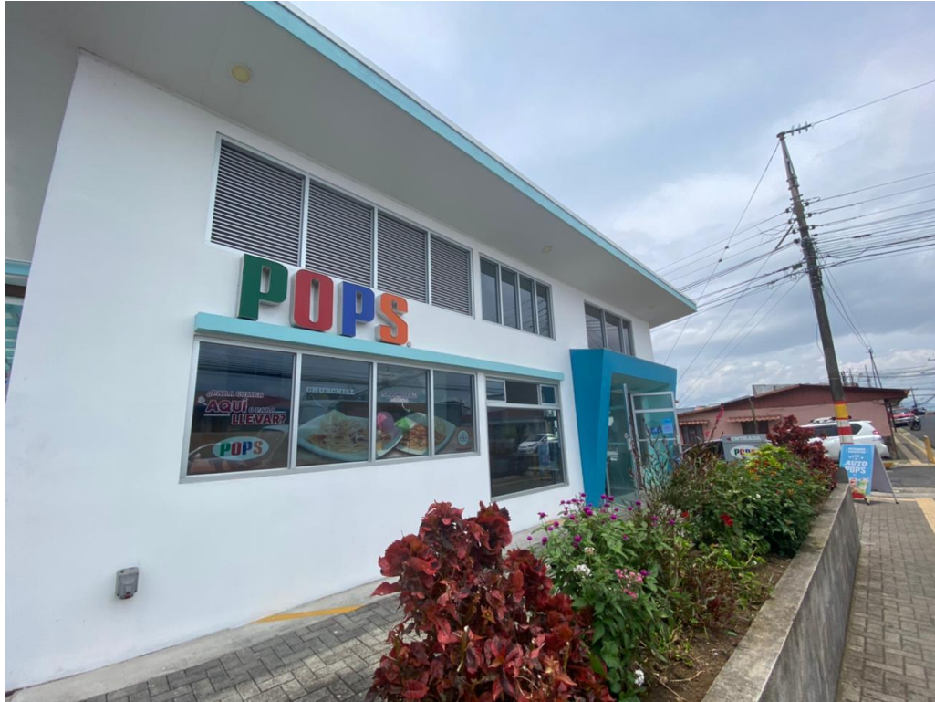
Figura 28. Edificio Comercial Pops, cantón de San Isidro de Heredia
