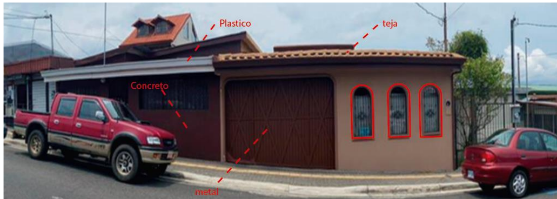
Figura 56. Materialidad y ventanería cerca del lote a intervenir , cantón de San Isidro de Heredia
