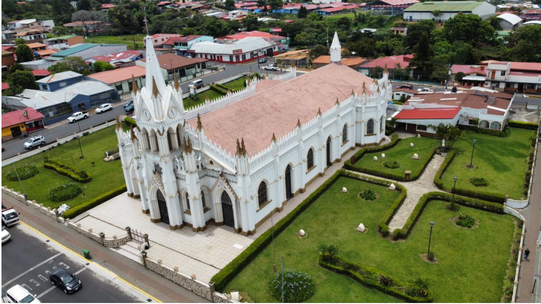
Figura 26. Iglesia Católica San Isidro Labrador, cantón de San Isidro de Heredia
