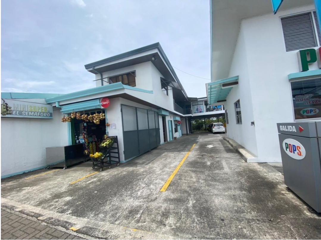
Figura 30. Edificio Comercial minisúper, cantón de San Isidro de Heredia
