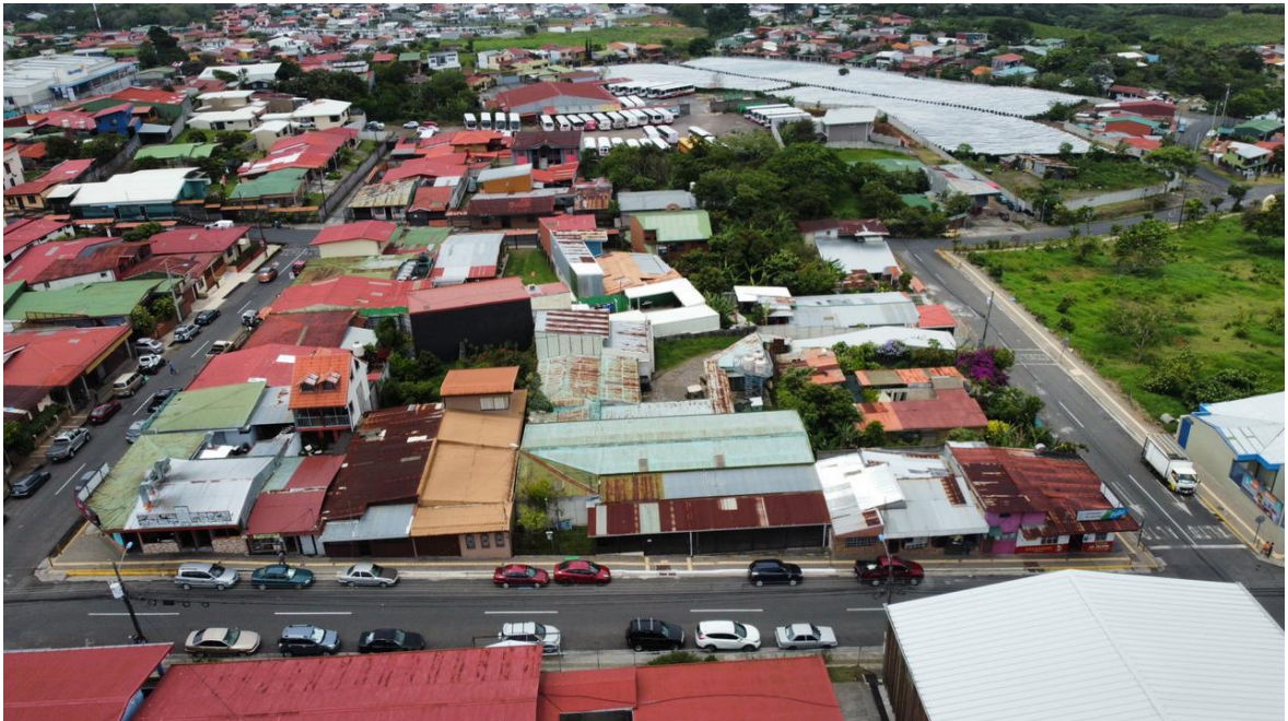
Figura 68. Vistas panorámicas alrededor del sitio a intervenir
