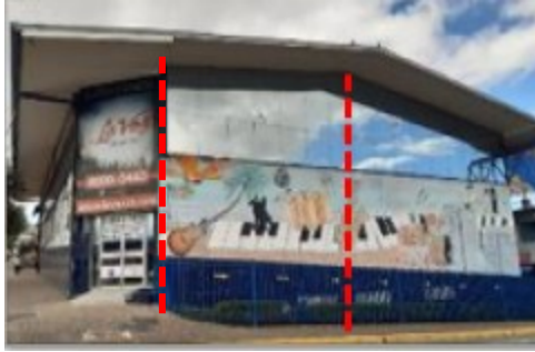
Figura 60 Edificio la voz
