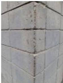
Figura 65. Bloque de concreto
