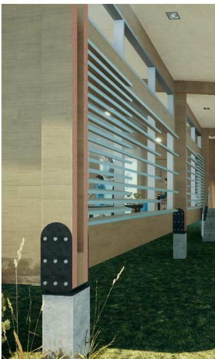
*Nota 32. Imagen identificativa de sistema de cimientos en hormigón y sistema de columnas contenidas por medio de placas de hierro negro atornilladas a la viga. Fuente: Propia*
