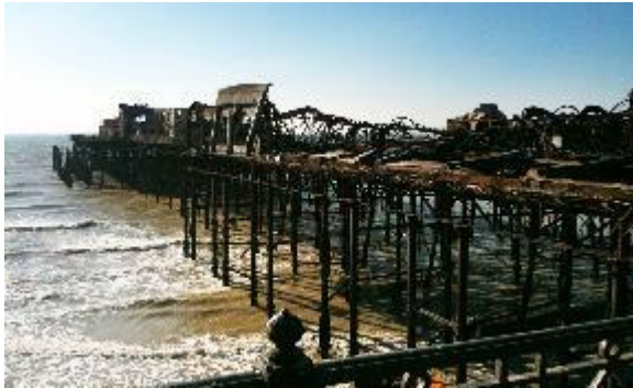
Figura 267. Muelle de Hostings antes de ser renovado
