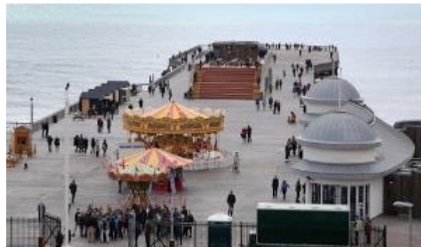
Figura 268. Muelle de Hostings antes de ser renovado
