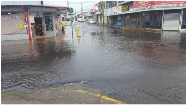
Figura 440. Afectación de las lluvias
