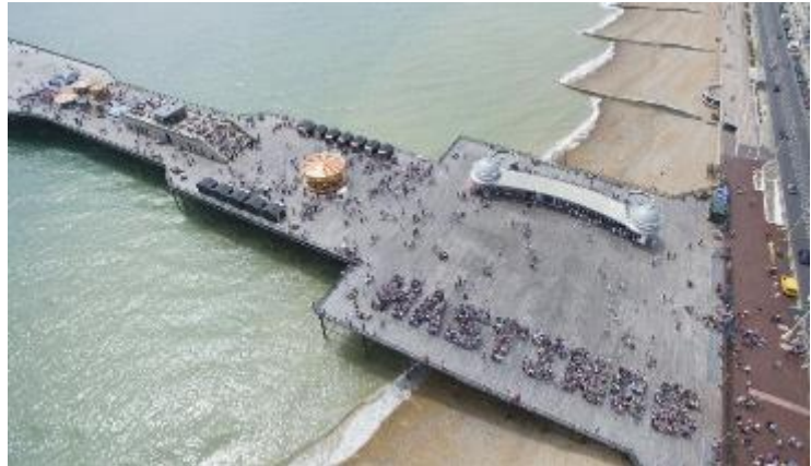
Figura 266. Muelle Hastings renovado , Fuente: Plataforma Arquitectónica (2017).
