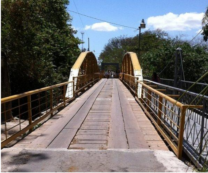
Figura 44. Puente Real Fuente: La Voz de Guanacaste (2018)
