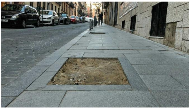
Figura 160. Ausencia de infraestructura complementaria Fuente: El diario (2019)
