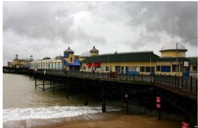
Figura 272. Funcionalidad antigua del muelle de Hastings Fuente: BBC (2010).
