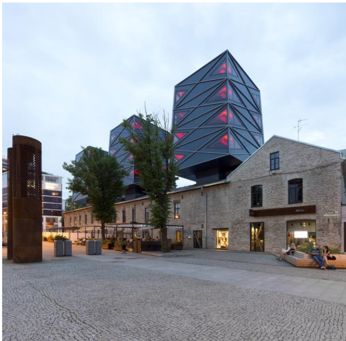
Figura 64. Apropiación del espacio, reconstrucción del antiguo taller de carpintería, Tallin, Estonia Fuente: Archdaily (2018)
