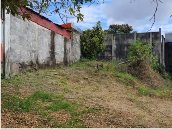
Figura 12. Vista hacia el sur de invasión constructiva al terreno para las instalaciones de la ALM SRH. [fotografía]
