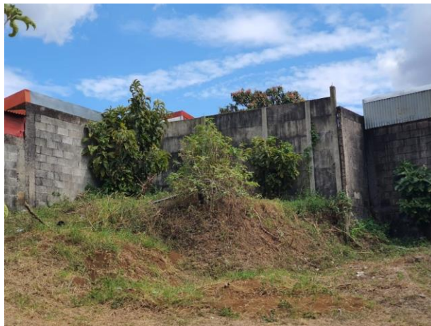
Figura 11. Vista hacia el sureste de invasión constructiva al terreno para las instalaciones de la ALM SRH. [fotografía]
