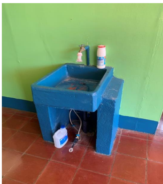
Figura No. 26. Instalación y adaptación lavamanos. Fuente: Elaboración propia.
