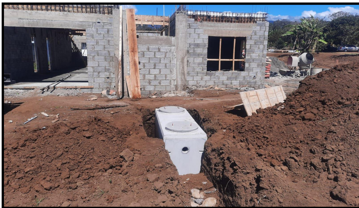
Figura 20: Colocación del MT-1600S en un proyecto habitacional.
