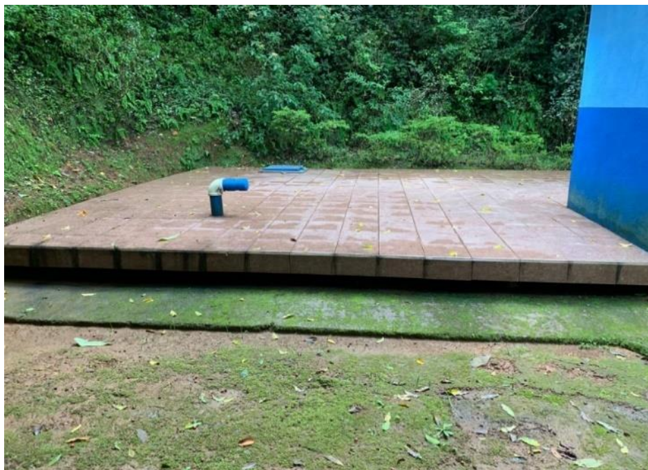
Figura 25 Estructura Tanque de Almacenamiento 100m 3
