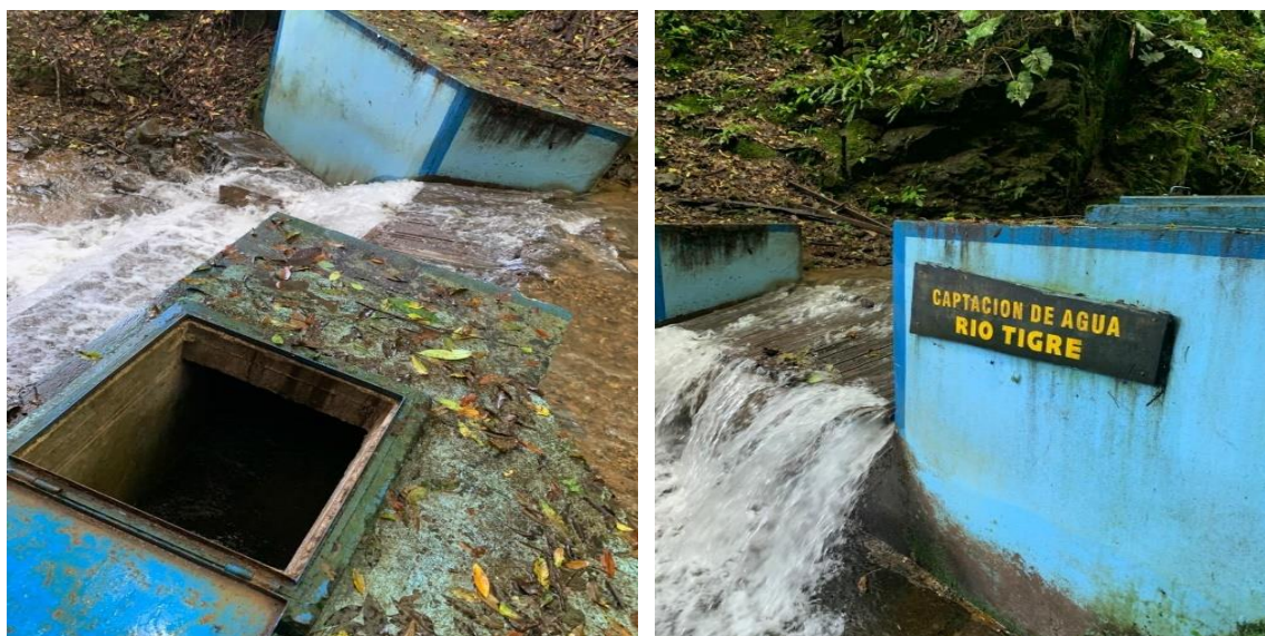
Figura 14 Estructura de captación Río Tigre
