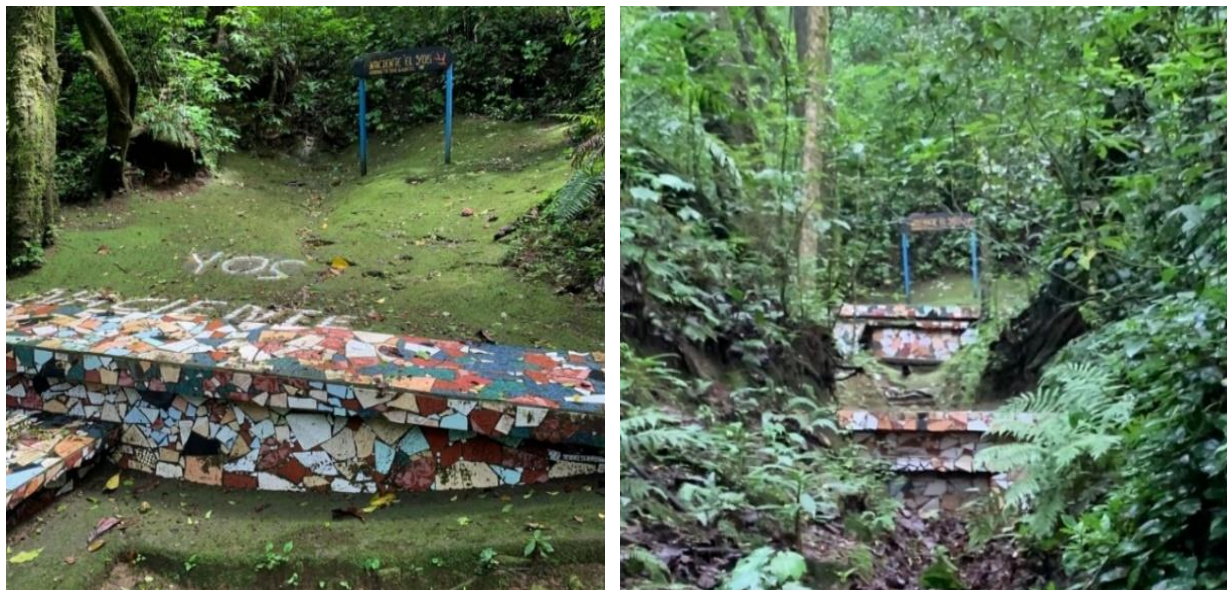
Figura 16 Estructura de captación Yos
