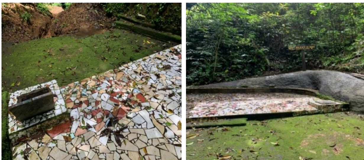
Figura 15 Estructura de captación La Muni
