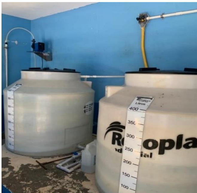
Figura 28 Estructura Caseta Cloración Planta Las Brisas Fuente: Propia, 2022
