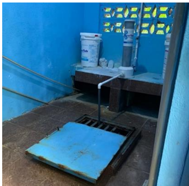
Figura 27 Estructura Caseta Cloración Planta Tarbaca
