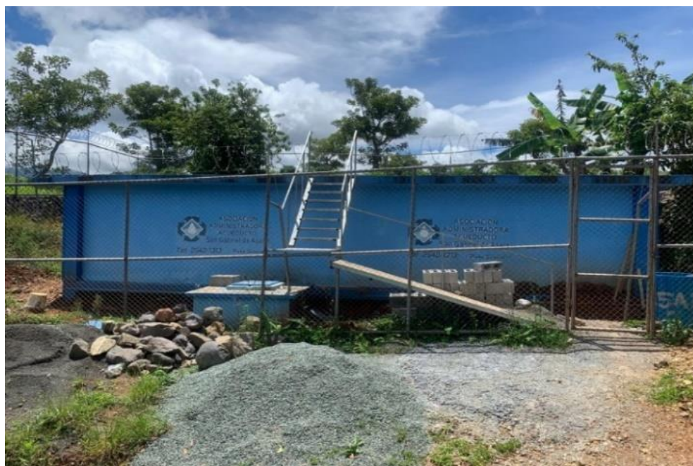
Figura 22 Estructura Tanque de Almacenamiento 300m 3
