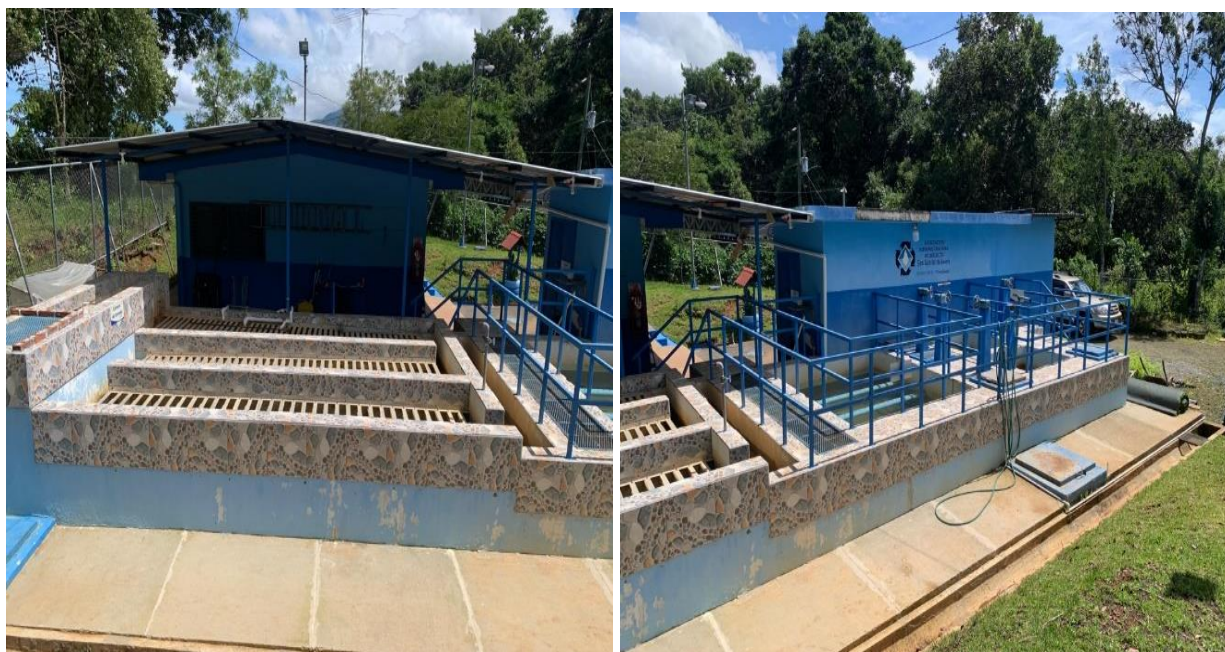
Figura 20 Estructura Planta Las Brisas
