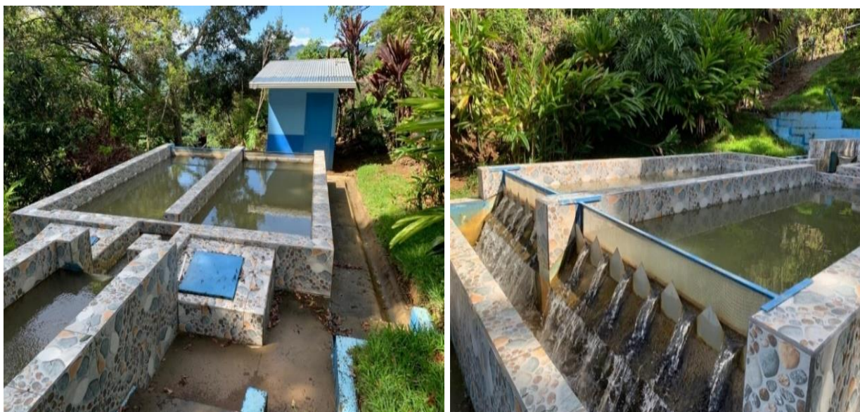
Figura 21 Estructura Desarenador El Tigre
