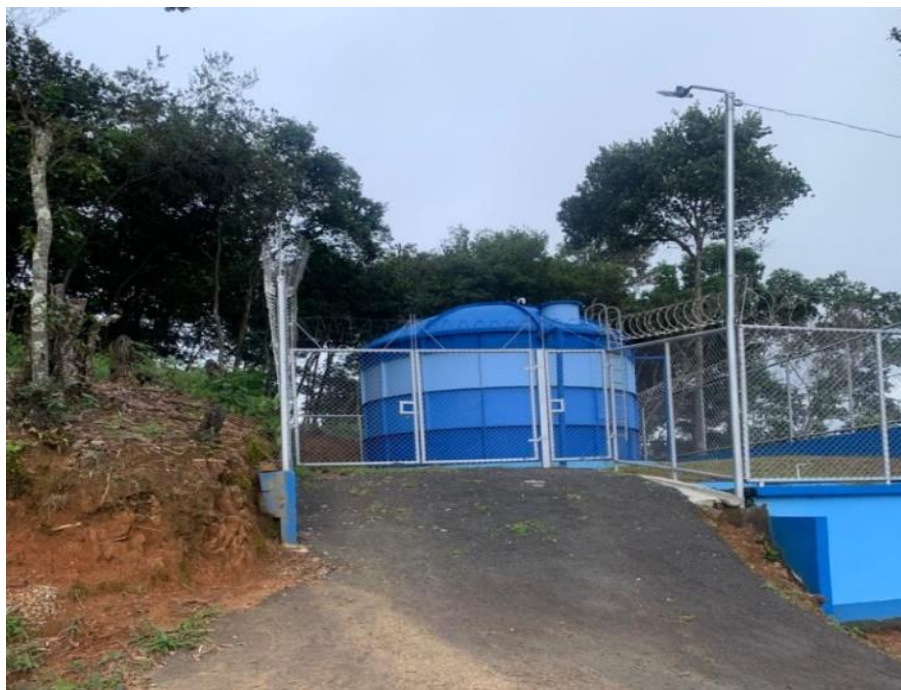
Figura 24 Estructura Tanque de Almacenamiento 100m 3
