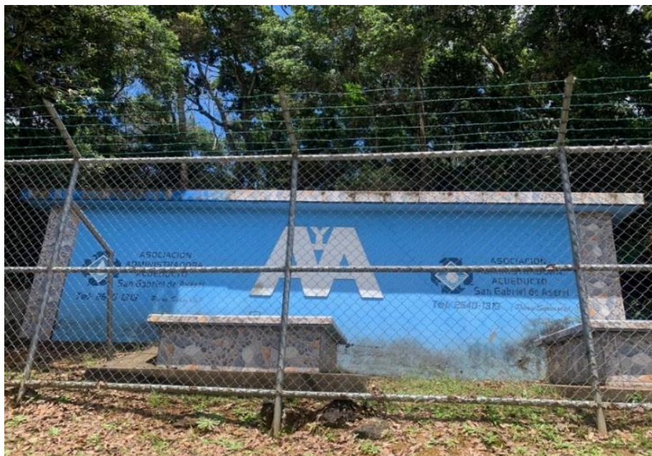
Figura 23 Estructura Tanque de Almacenamiento 150m 3
