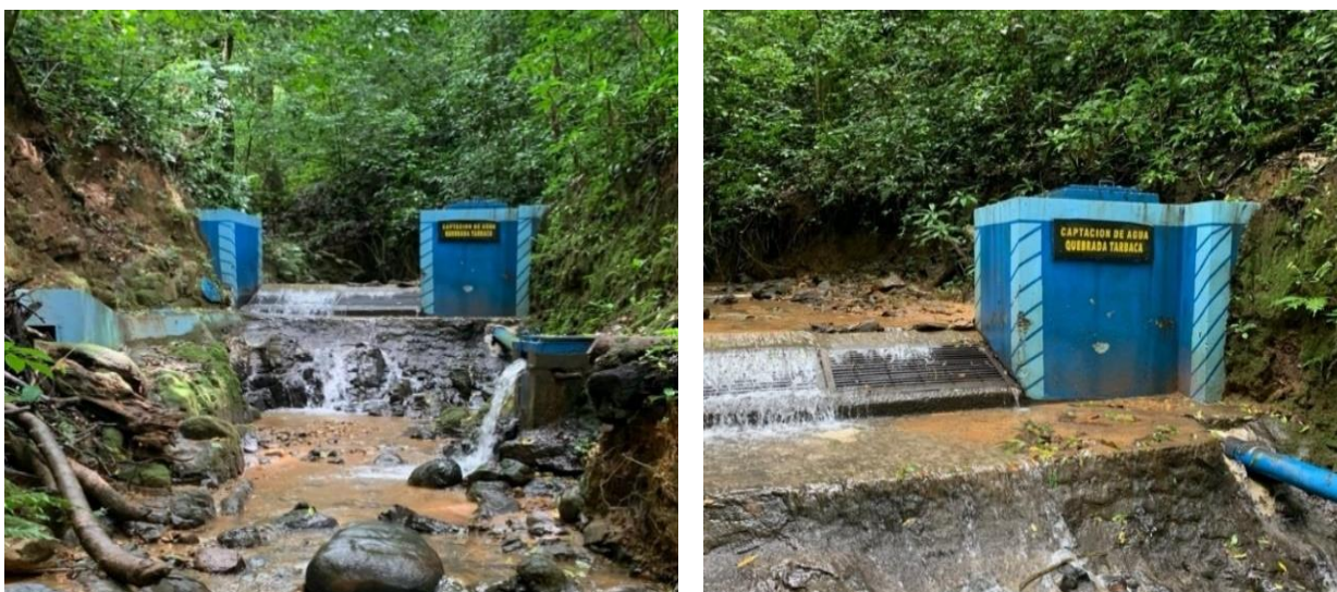
Figura 18 Estructura de captación Quebrada Tarbaca
