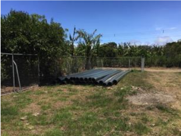
Evidencia 1. Condición general de las áreas afectadas, 04/03/2016.
