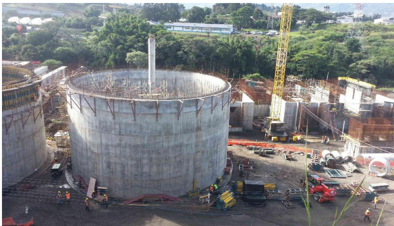
Figura N° 2: Etapa de construcción
