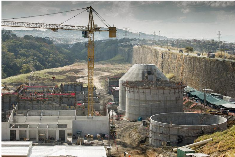
Figura N° 1: Etapa de construcción
