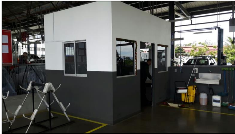
Figura 19 Construcción del área de oficina
