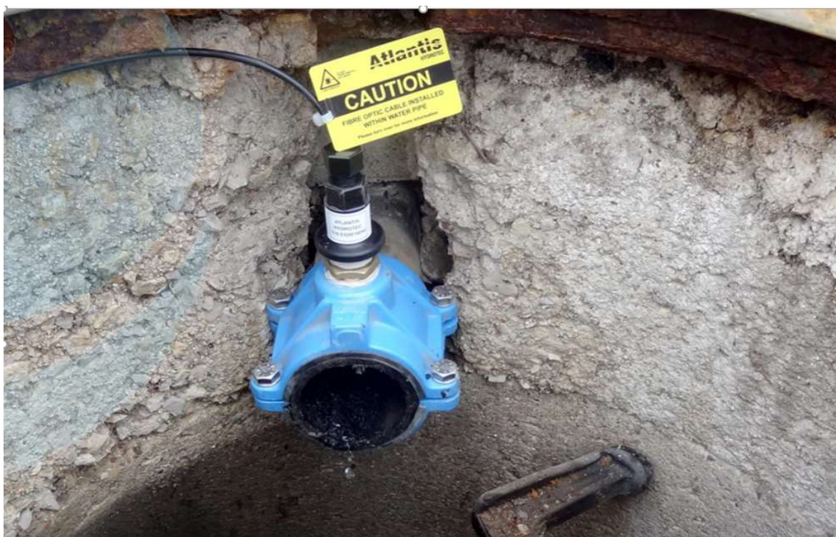
Ilustración 24: Cable de fibra óptica instalado dentro de tubería de Agua Potable
