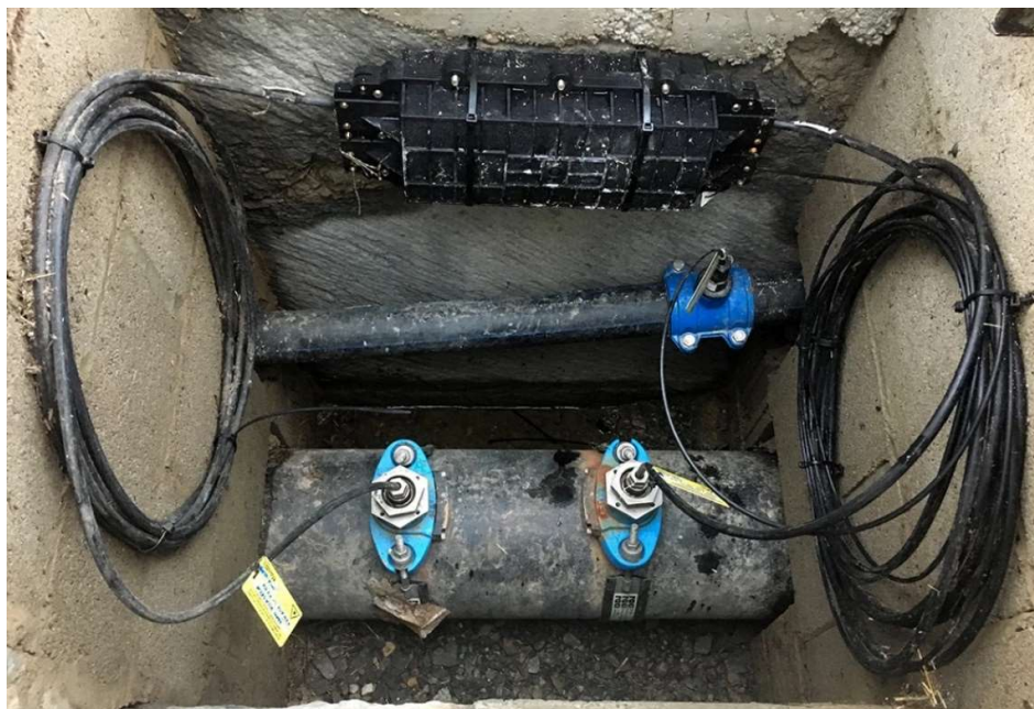
Ilustración 25: Caja de registro, donde se visualiza sistema de fibra optca.
