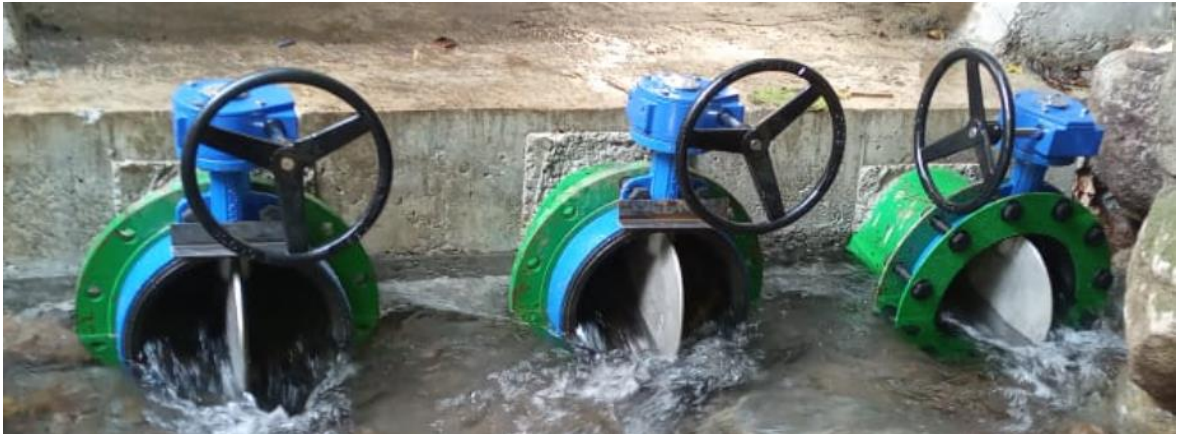
Figura. 32. Válvula mariposa con perilla.
