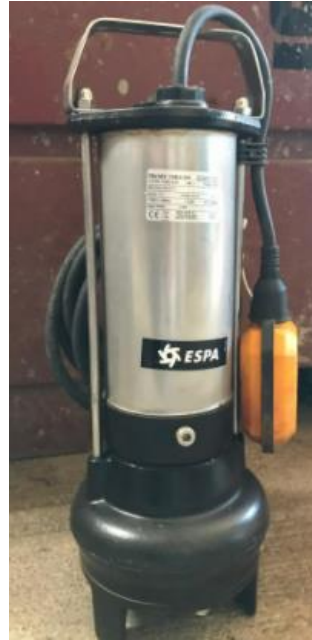
Figura. 44. Bomba de lodos encargada de impulsarlos al exterior.
