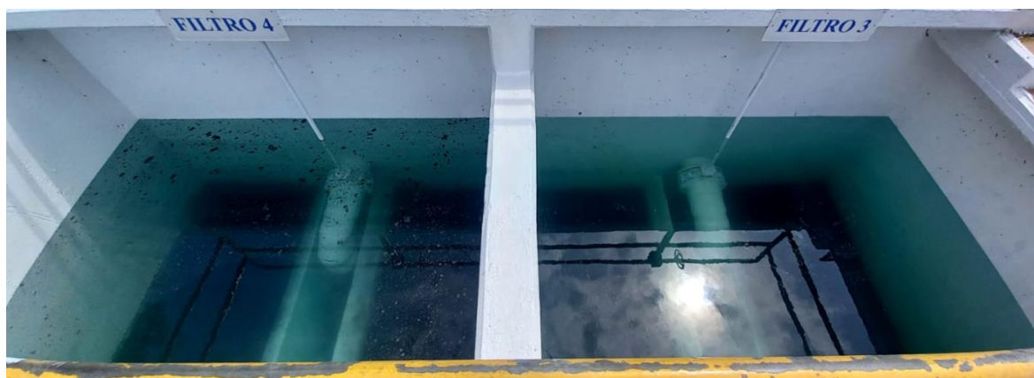
Figura. 27. Filtros para purificación de agua tipo cepis.
