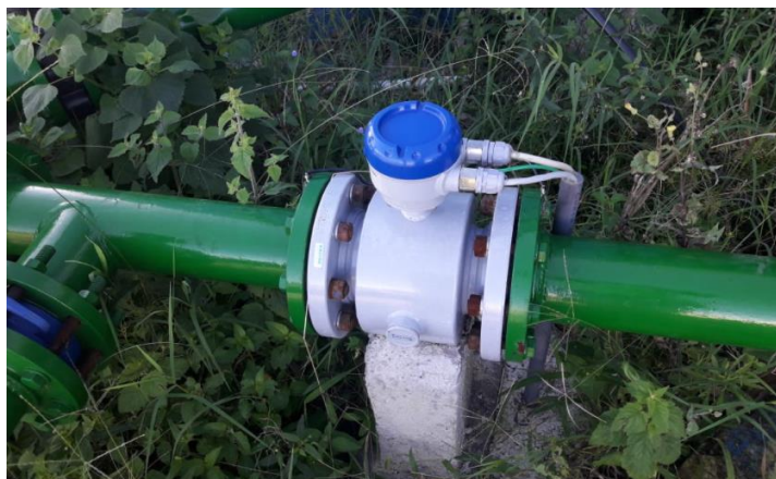
Figura. 12. Macromedidor Instalado.
