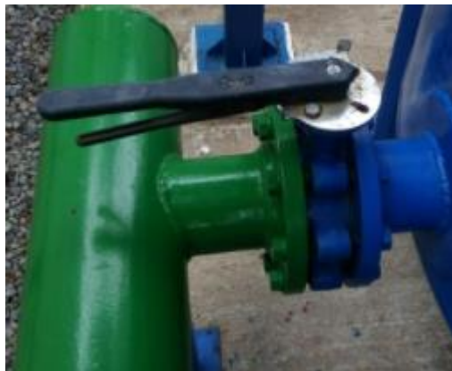
Figura. 31. Válvula mariposa con agarradera.
