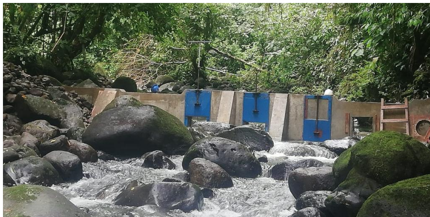
Figura. 6. Captación de agua (Toma).
