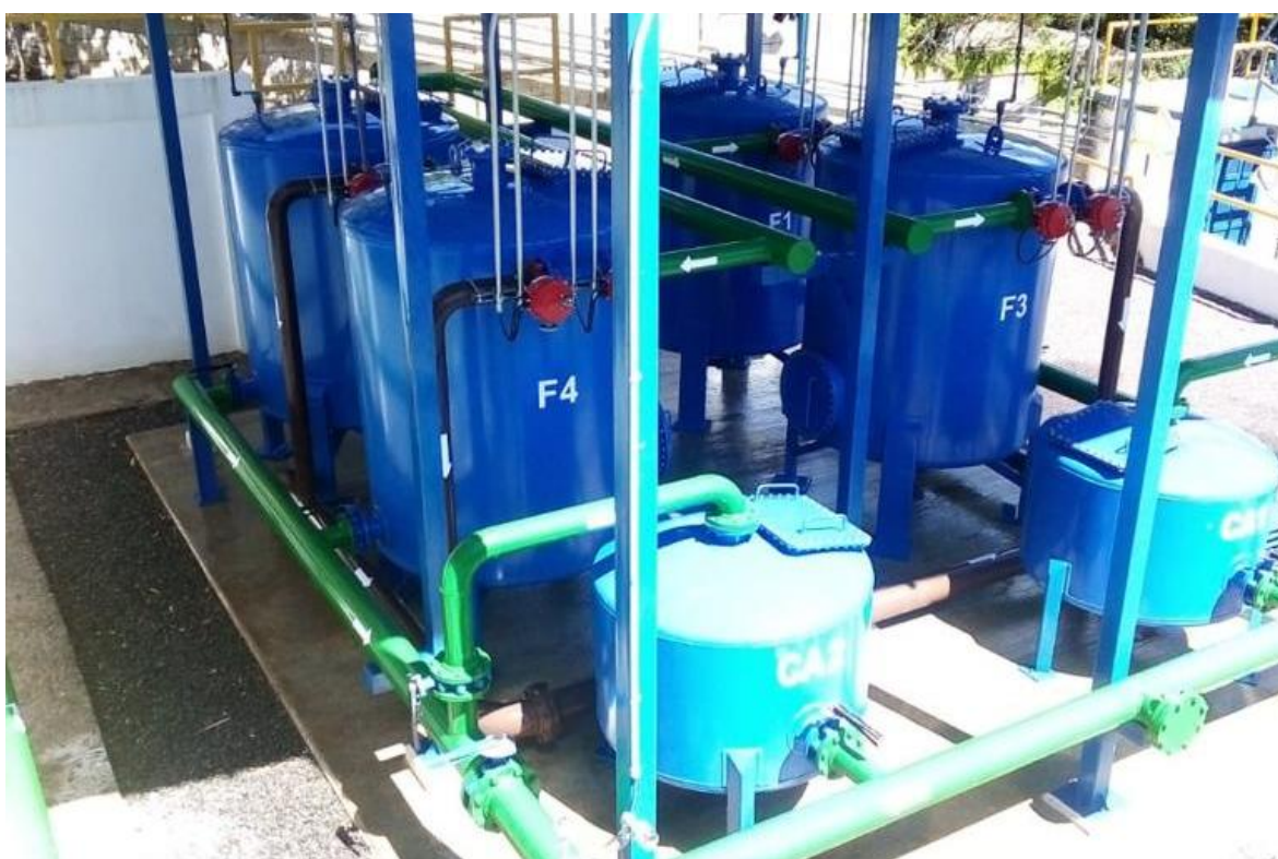
Figura. 28. Filtros rápidos bajo presión.
