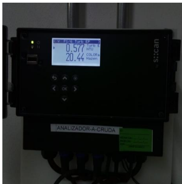
Figura. 13. Analizador de turbidez de entrada.
