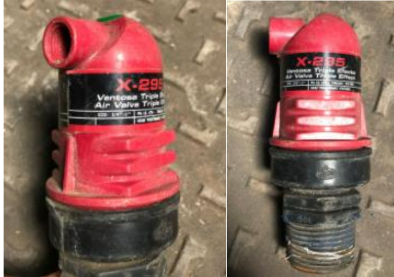
Figura. 30. Válvula de aire o triple acción.
