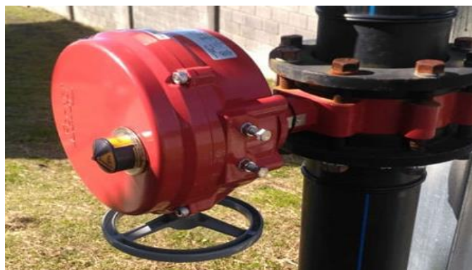
Figura. 34. Válvula motoriza en funcionamiento.
