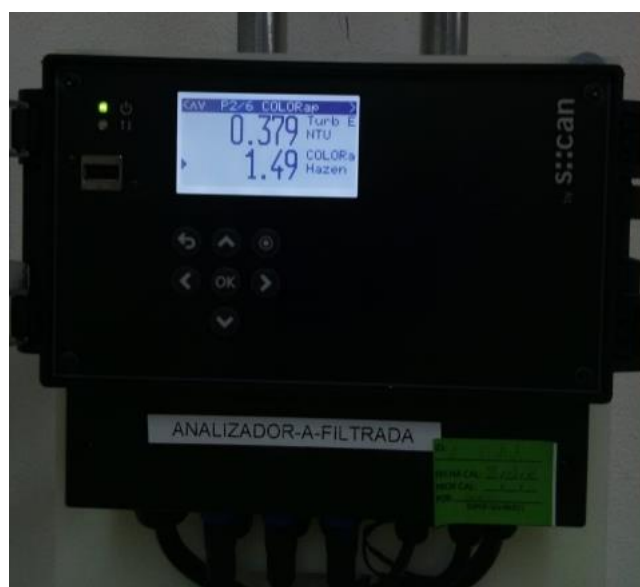
Figura. 14. Analizador de turbidez de salida.
