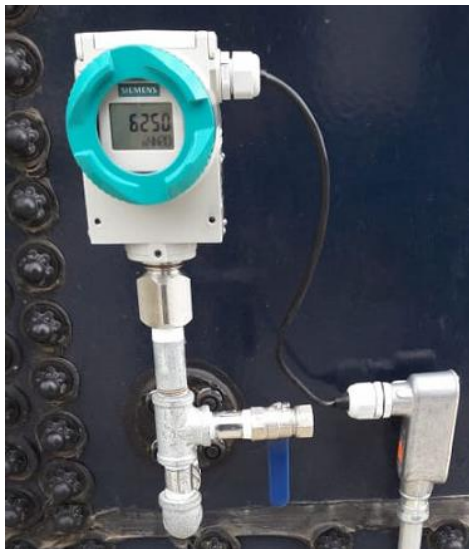
Figura. 46. Manómetros digitales.
