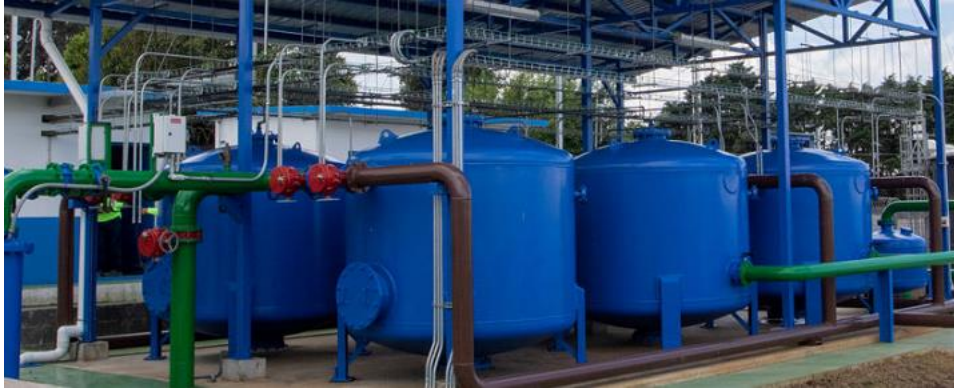
Figura. 29. Filtro rápido bajo presión para la purificación del agua.
