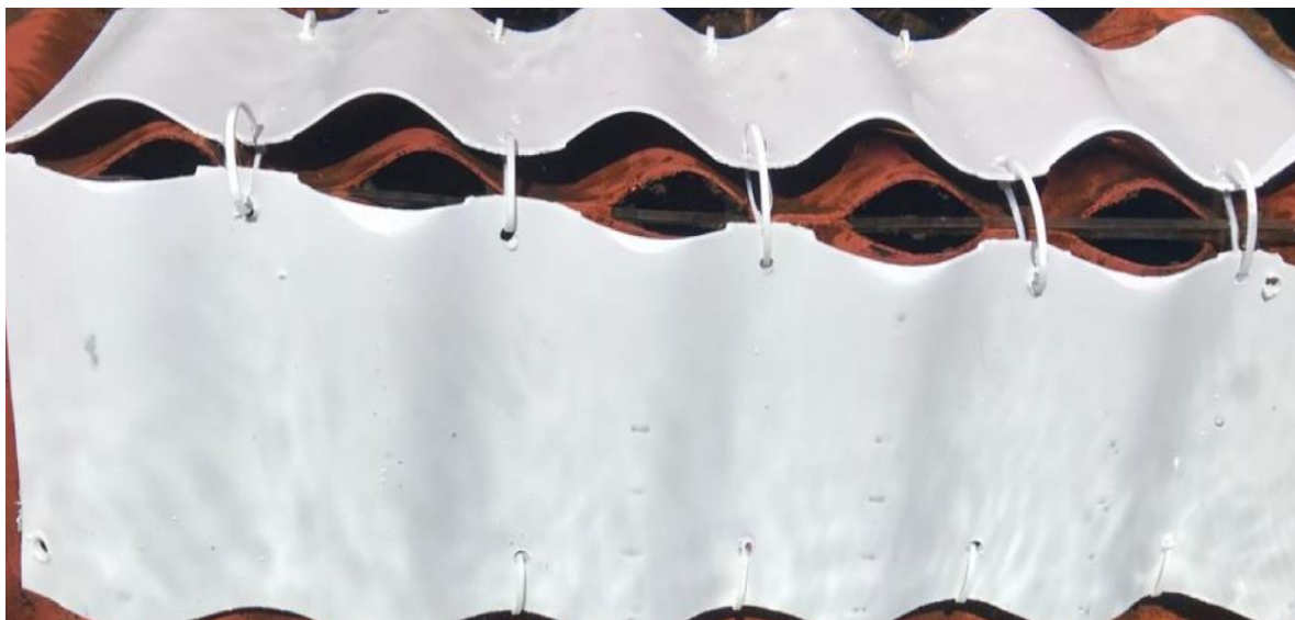
Figura. 61. Lamina actual del clarificador (Colocada el día 1).
